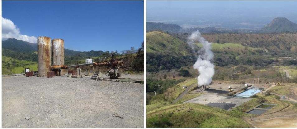
Figura 27. Sistemas de silenciadores colocados en pozos productores en el PG Borinquen (PLB-02)
