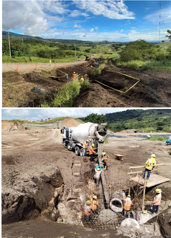
Figura 153. Tubería de Fluidos Condensados SRF.
