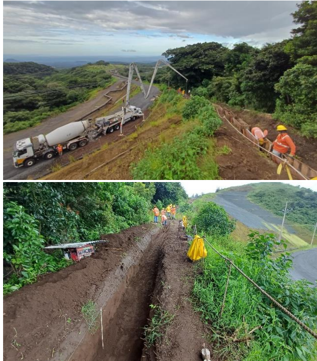
Figura 146. Construcción de disipadores.
