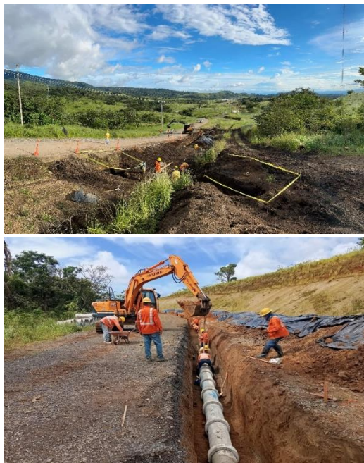
Figura 147. Tubería de fluidos condensados SRF.
