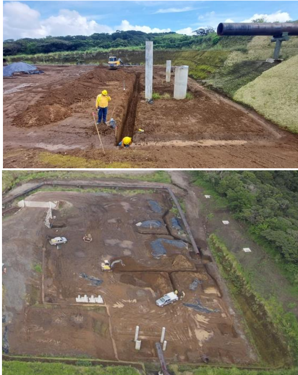
Figura 158. Colocación de malla tierra.
