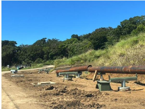
Figura 170. Montaje de tuberías de salmuera y vapor.
