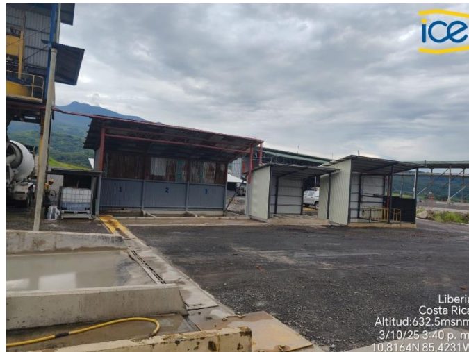
Figura 61. Sedimentadores para la planta de concreto y lavado de equipos.
