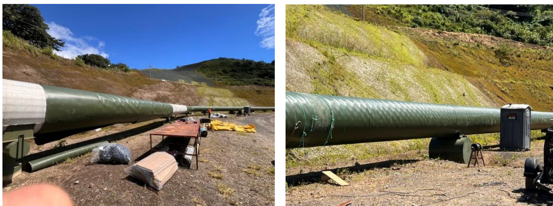
Figura 167. Instalación de aislante térmico a estructura de tuberías.
