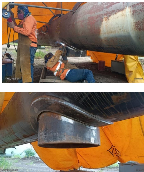
Figura 169. Colocación de colectores de condensados.
