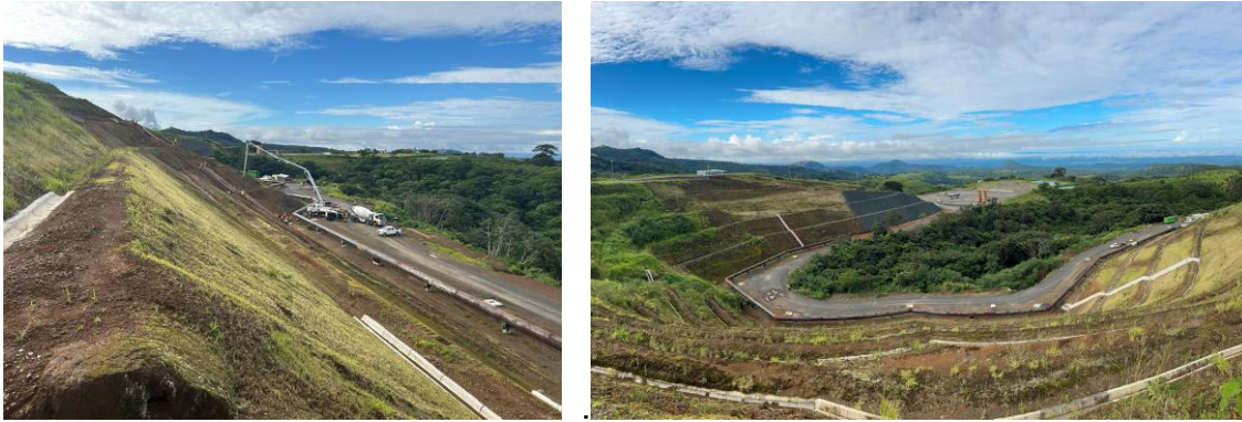
Figura 148. Construcción de cunetas en bermas.
