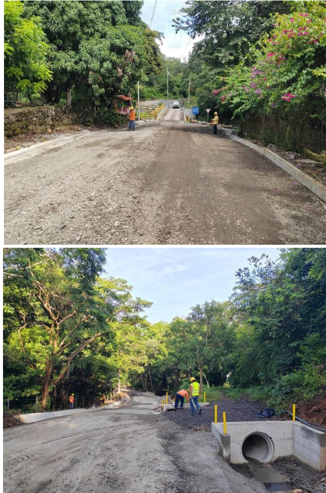
Figura 160. Colocación de alcantarillado y construcción de cunetas.
