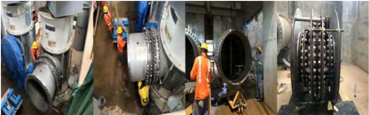
Figura 151. Instalación de tuberías de sistema de pozo caliente.
