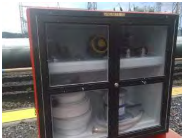
Figura 15. Gabinete con equipo contra incendios en buen estado, con mangueras, pitones y herramientas. Junio 2018.
