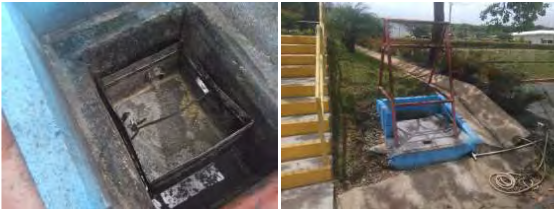
Figura 35. Vista del tamiz de gruesos del comedor. Esta estructura se puede mejorar. Se limpia tres veces al día, si se ve que se rebalsa frecuentemente. Junio 2018
