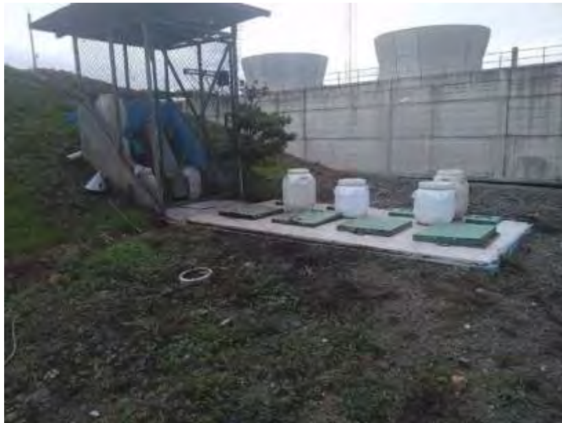
Figura 36. Tanque desgrasador. La grasa flotante se limpia tres veces por día (proyectos). Junio 2018.
