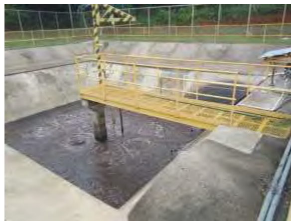
Figura 58. Vista del tanque reactor biológico.
