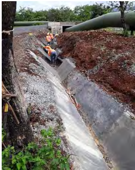
Figura 158. Construcción de cunetas.
