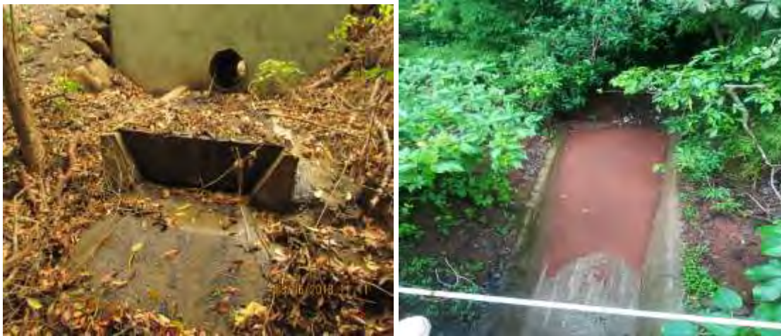
Figura 68. Sedimentadores colmatados en junio, 2018.
