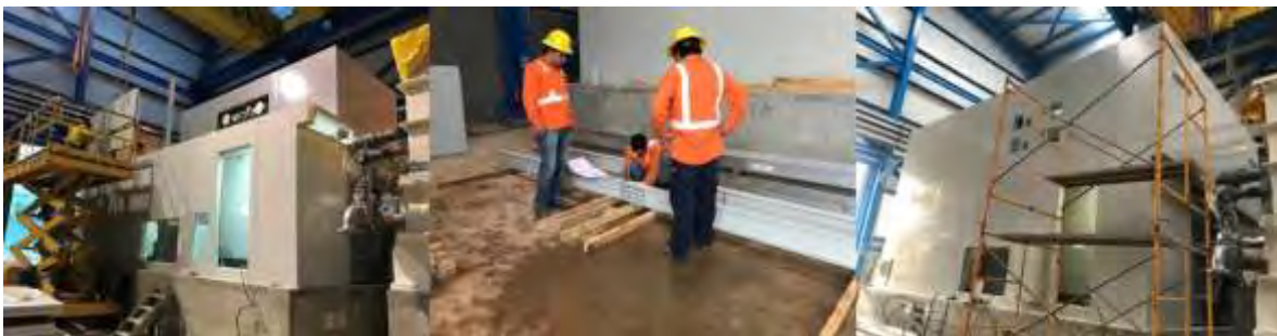
Figura 152. Instalación de turbina y generador
