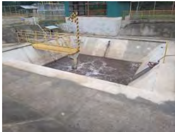
Figura 57. Vista de Tanque homogenizador con nueve aireadores, en buen estado. Junio 2018.
