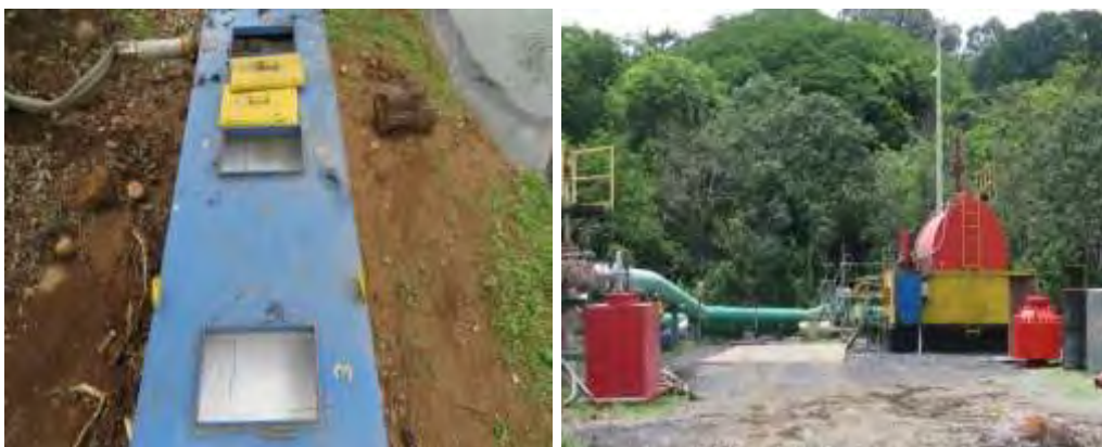
Figura 4. Uso de toallas absorbentes en trampas para aguas oleaginosas en PGP-03.
