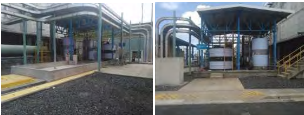
Figura 27. Sistema de soda con muros de contención de derrames. Junio 2018.
