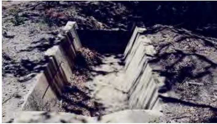
Figura 67. Inspección de sedimentadores en abril 2018. Se observa acumulación de hojas secas.
