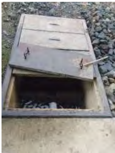
Figura 25. Trampa de aceites de la bodega y almohadillas.
