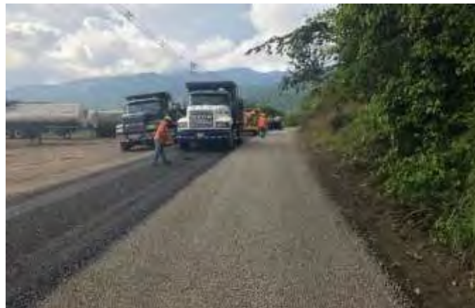
Figura 159. Colocación de tratamiento asfáltico en caminos internos.
