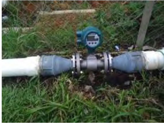
Figura 59. Salida del agua del sedimentador del agua tratada con medidor de flujo magnético. Junio 2018.
