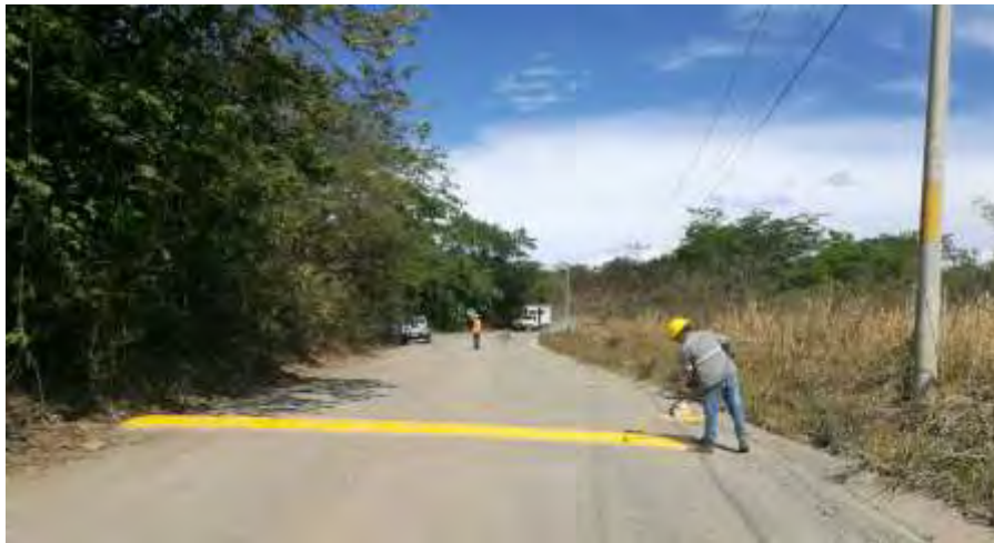
Figura 87. Mantenimiento de reductor de velocidad.
