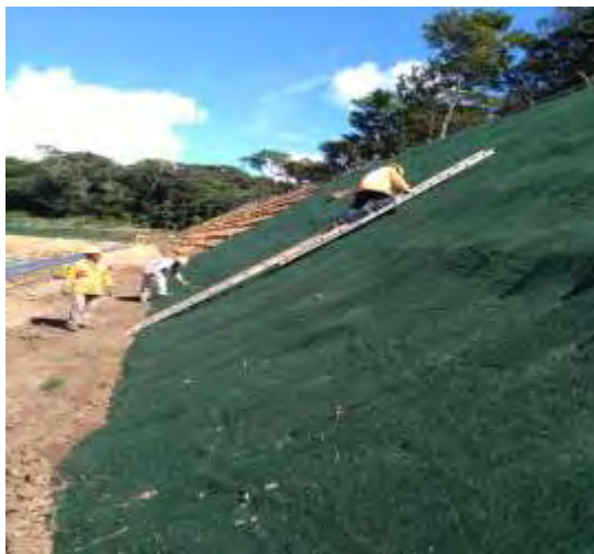
Figura 51. Recubrimiento del talud con geo membrana.
