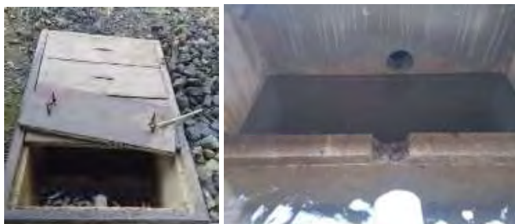
Figura 5. Vista del tanque de contención de derrames, hay que sacar algo de agua de lluvia. Se puede observar la ausencia de derrames. Junio 2018.
