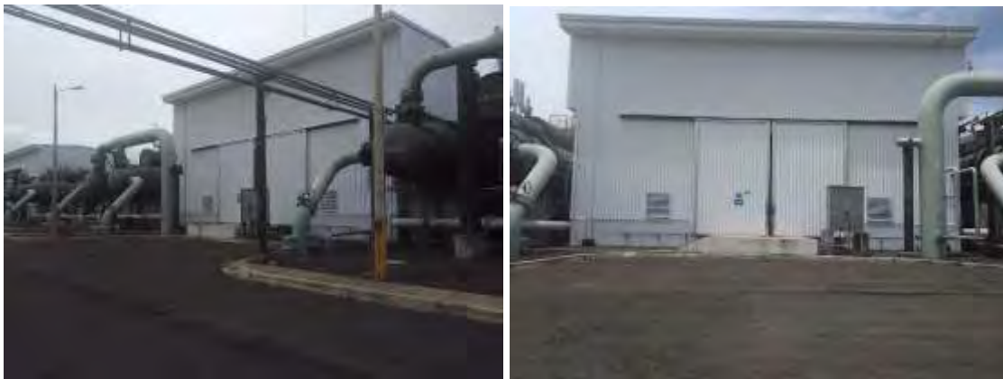
Figura 52. Aislamiento térmico y acústico de la caseta de turbina, está en buen estado y las puertas están cerradas. Junio 2018.
