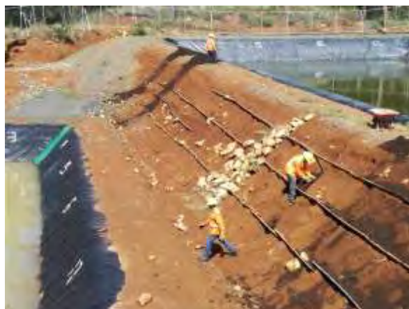
Figura 50. Regla y tierra orgánica sobre los taludes de la Plazoleta 13.
