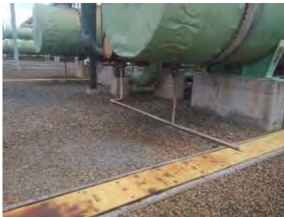
Figura 48. Vista del sistema de drenajes de condensados. Junio 2018.
