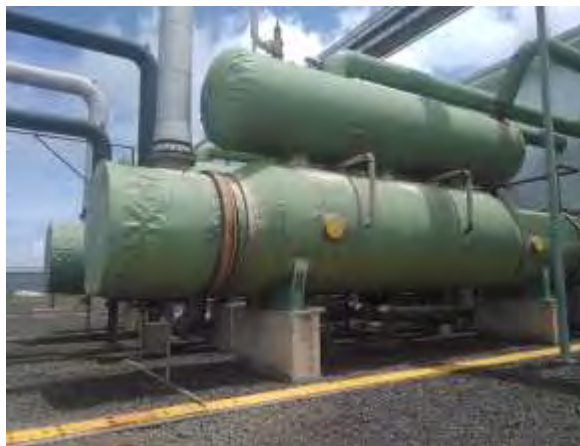
Figura 12. Recubrimientos térmicos de vaporizadores en buen estado. Junio 2018.
