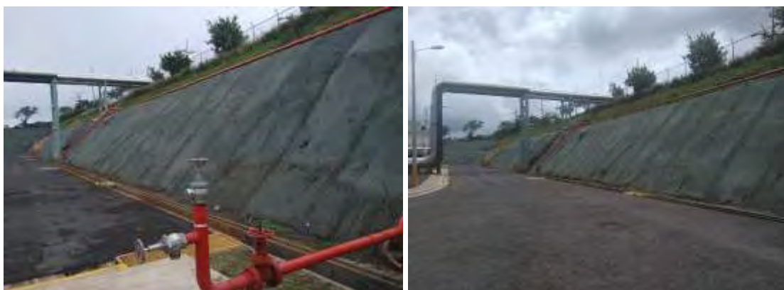
Figura 40. Taludes estabilizados con geo-membranas sintéticas en la Planta Geotérmica Pailas I, ya hay que hacer algunas reparaciones. Junio 2018.
