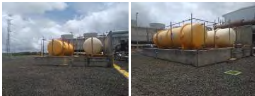
Figura 53. Tanques de pentano, pintura y sistema de aspersión en buen estado. Junio 2018
