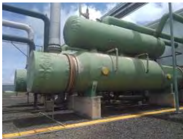
Figura 50. Vaporizadores de pentano con aislamiento térmico en buen estado. Junio 2018.
