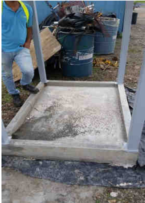
Figura 21. Estructura para almacenamiento de sustancias peligrosas.
