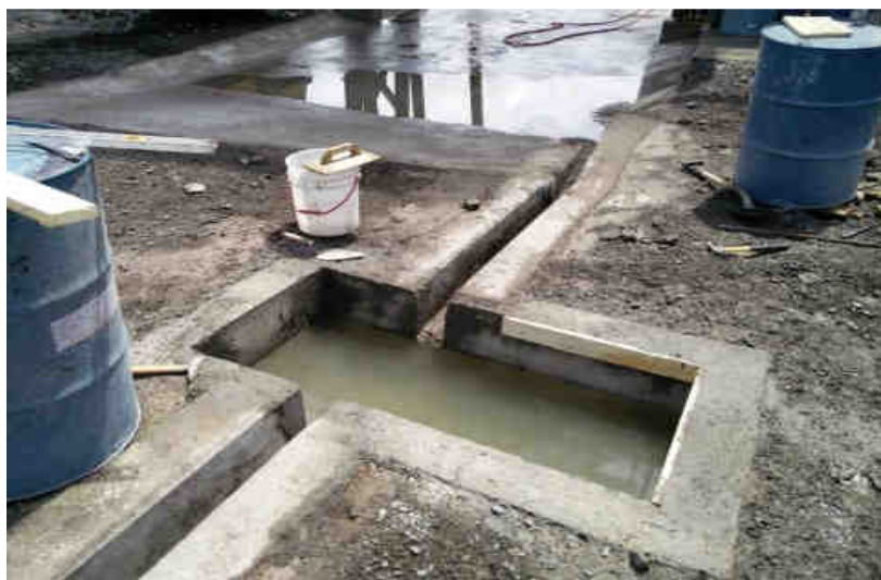
Figura 19. Sedimentador en Planta de Concreto.
