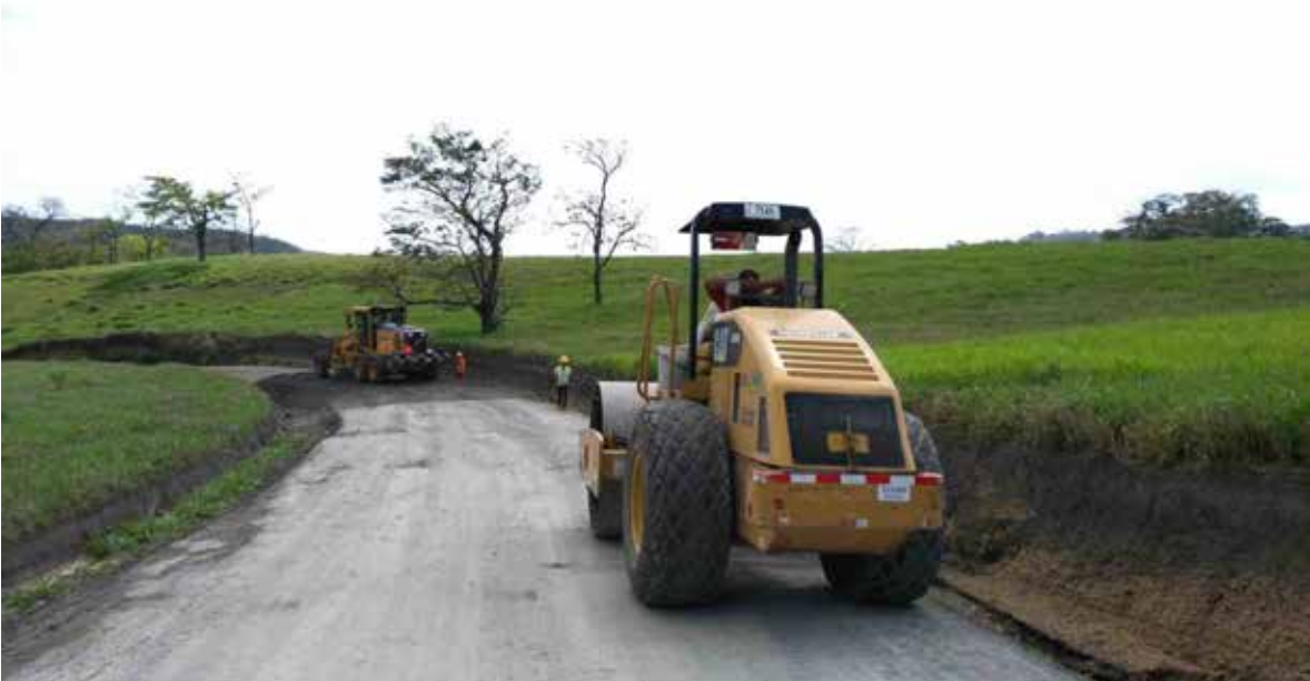
Tratamiento de caminos internos con RCC (concreto compactado con rodillo). Registro al 24 de mayo del 2016.
