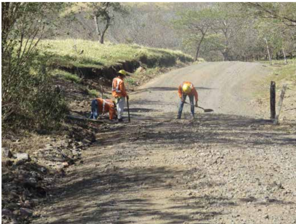
Reparación de “quebrapatas” en pasos de camino interno. 24 de mayo del 2013.
