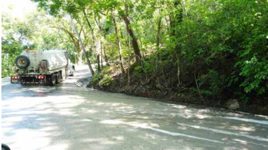
Figura 13. Riego con camión cisterna para el control de polvo.
