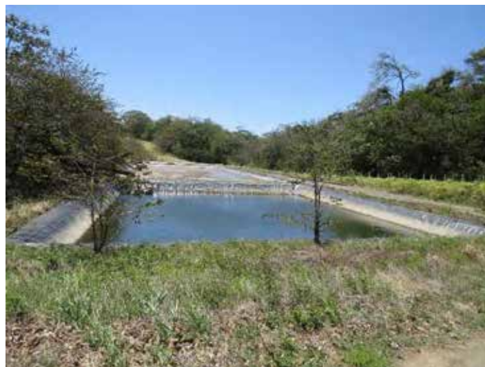
Figura 21. Lagunas impermeabilizadas en PLB-9.
