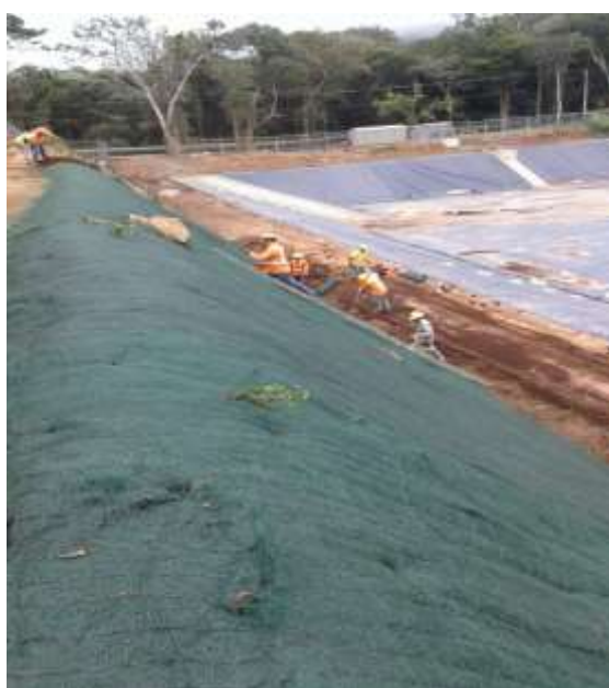
Figura 54. Recubrimiento del talud con geo membrana.
