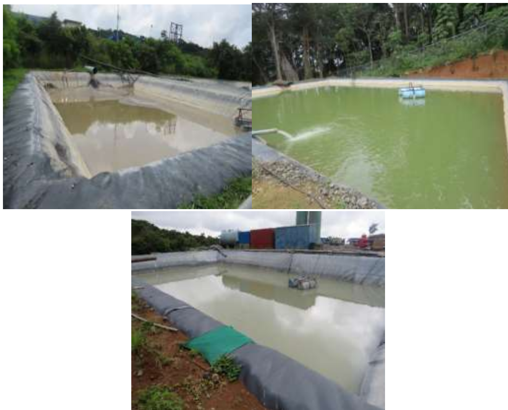
Figura 21. Lagunas almacenamiento de fluidos geotérmicos y de perforación en PLP-11, PLP-12 y PLP-13.
