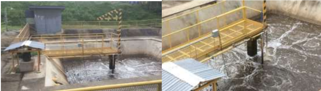
Vista del by pass de aguas en el reactor biológico, (retorno de agua).
