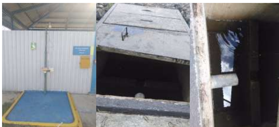
Ilustración 6. Vista de la ducha, el canal de drenaje y el tanque de contención de derrames
