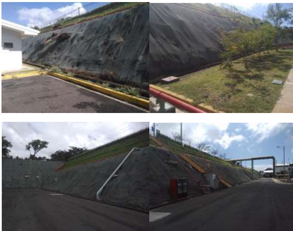
Ilustración 34. Taludes estabilizados con geo-membranas sintéticas en la Planta Geotérmica Pailas 1.
