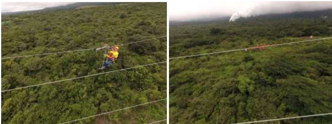
Figura 115. Instalacion de dispersores para aves en la Línea de Transmisión. Septiembre, 2017.
