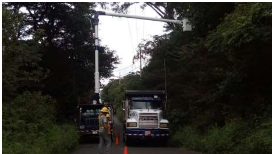
Figura 103. Construcción de paso aéreo para fauna.
