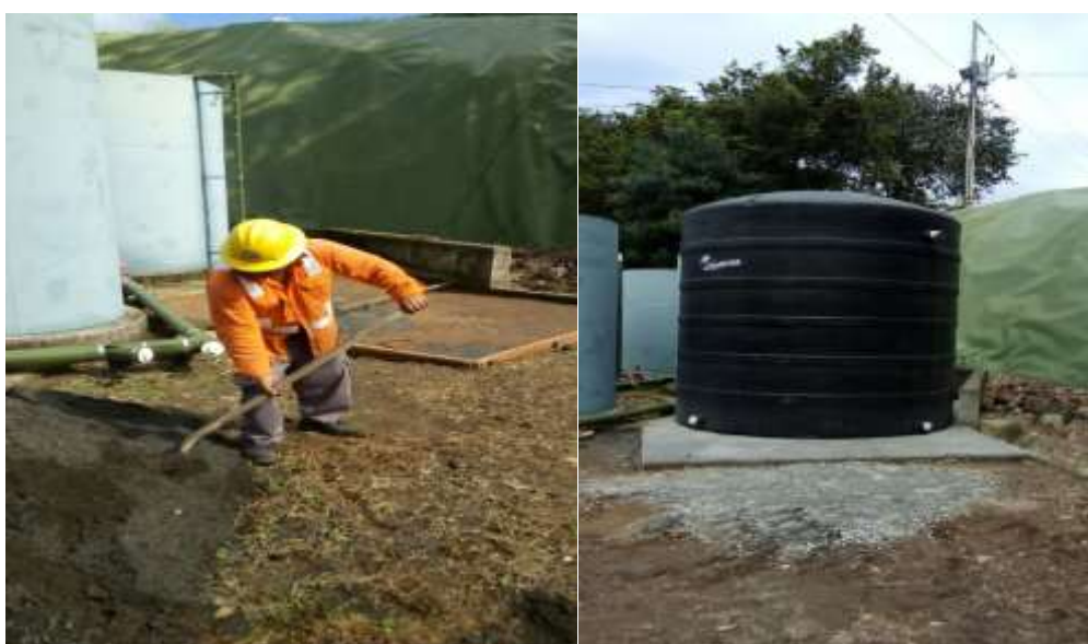
Figura 41. Construcción de losa e instalación de tanque de almacenamiento para aguas residuales
