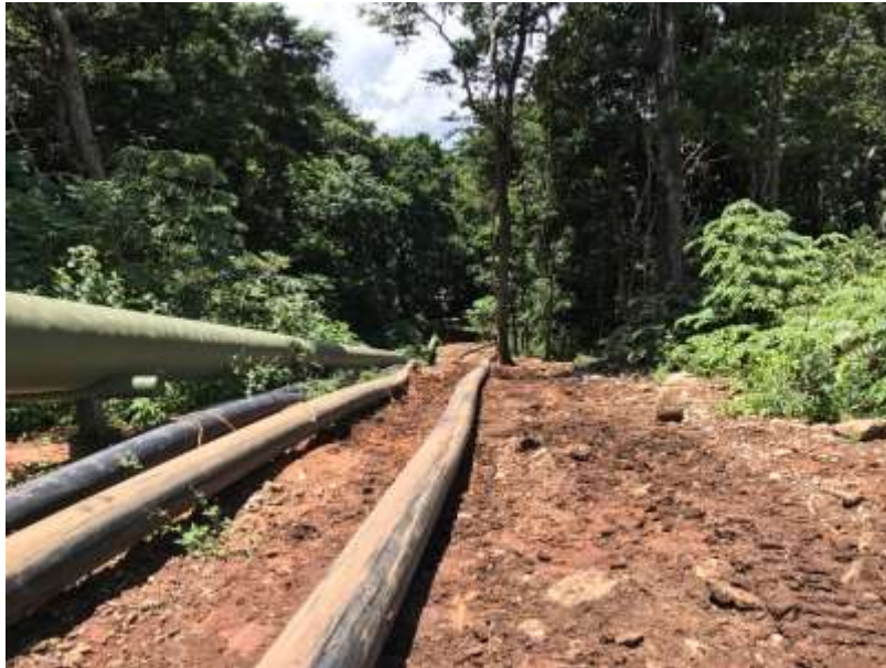
Figura 155. Colocación de tubería de PEAD.
