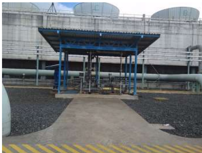
Ilustración 30. Tanque de drenajes de condensado buen estado
