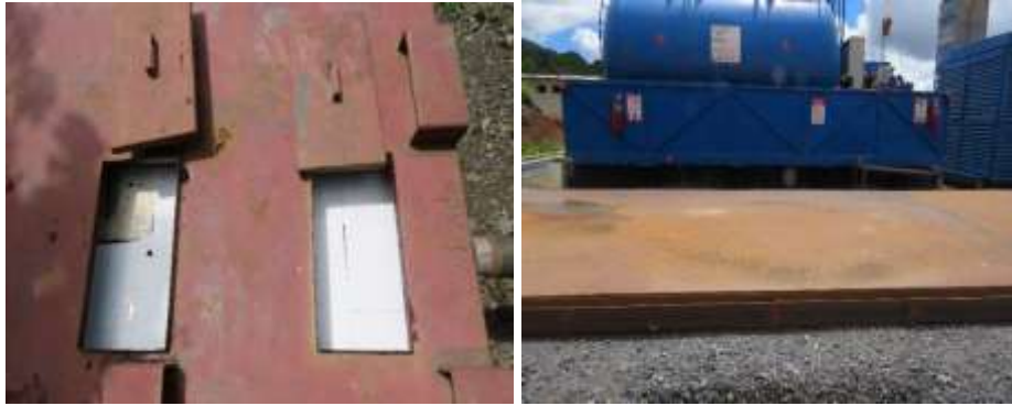
Figura 8. Uso de toallas absorbentes en trampas para aguas oleaginosas en PGP-63.
