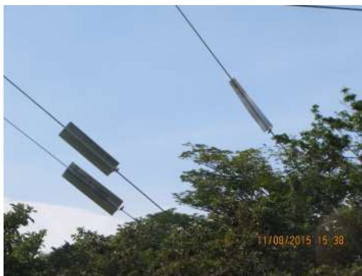
Figura 116. Colocación de láminas antiescalamiento.
