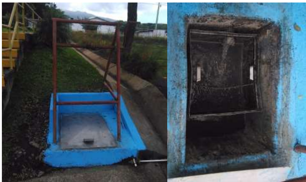
Ilustración 22 Vista del tamiz de gruesos del comedor
