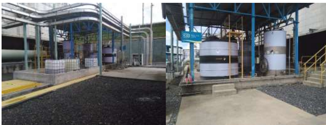
Ilustración 14. Sistema de soda con muros de contención de derrames.
