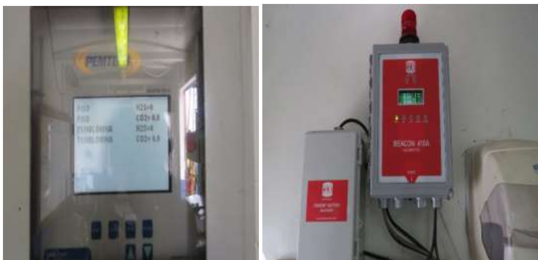
Figura 17. Detectores fijos con sistema de alarmas audibles de CO 2 y H 2 S.
