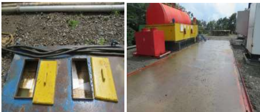
Figura 7. Uso de toallas absorbentes en trampas para aguas oleaginosas en PGP-62.
