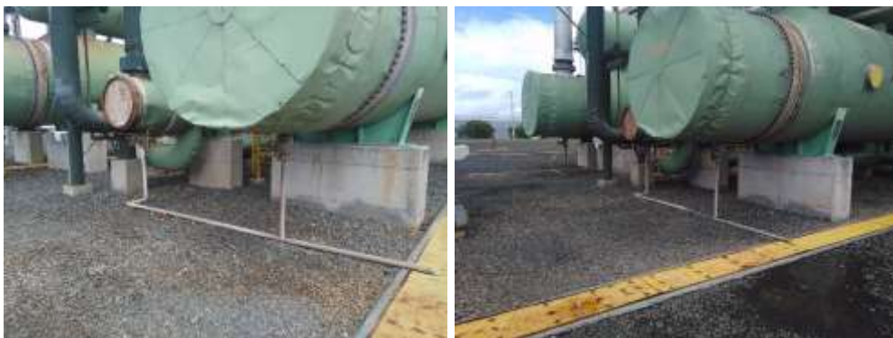
Ilustración 29. Sistema de drenajes de condensados.
