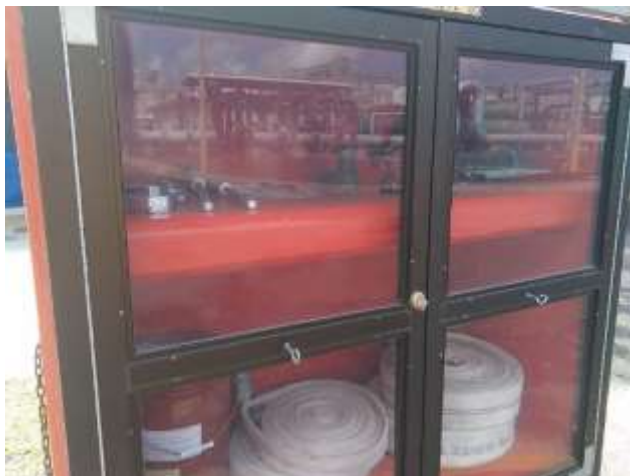
Ilustración 11. Gabinete con equipo contra incendios en buen estado, con mangueras, pitones y herramientas.
