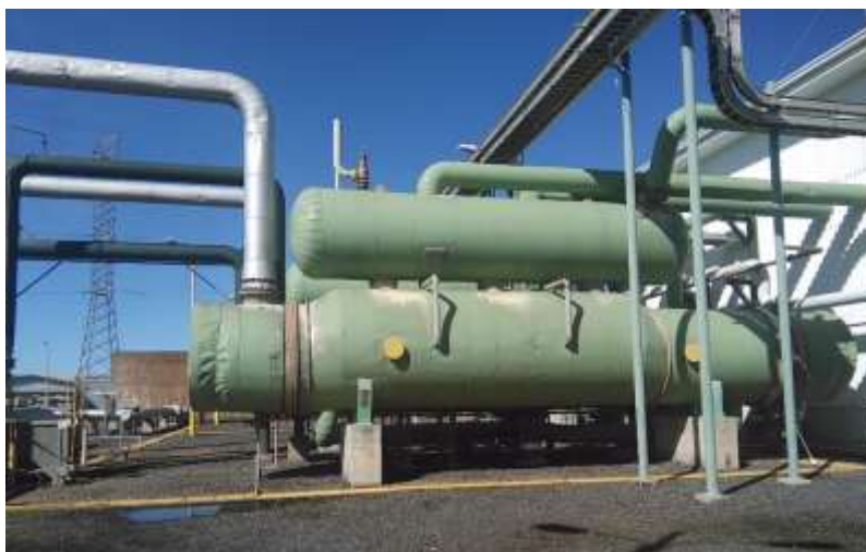
Ilustración 31. Vaporizadores de pentano
