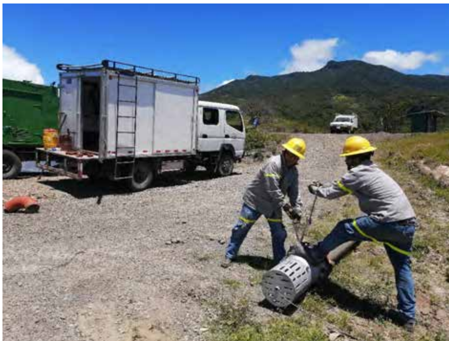
Instalación de tubería de agua de trabajo en la Plazoleta PLP-05. Marzo 2020.
