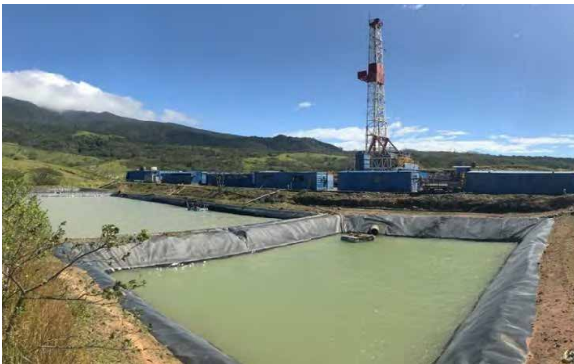
Figura 82. Laguna de cortados y laguna de construpozos en la plazoleta PLB-02 donde se está perforando el pozo PGB-42.
