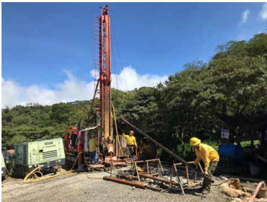
Figura 84. Proceso de re perforación pozo de gradiente #27.
