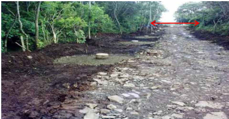
Fotografía 7 Ancho de trocha para una de las rutas de tuberías que se construyó en la unidad I Pailas.
