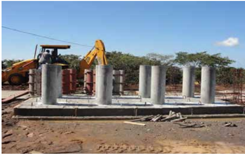
Fotografía 8 Pedestales prefabricados para montaje de las tuberías
