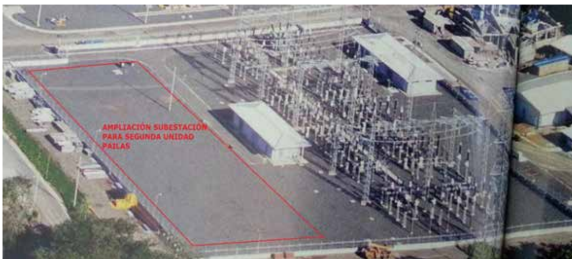
Fotografía 13 Área para ampliación de Subestación para la Unidad 2 Campo Geotérmico Las Pailas.
