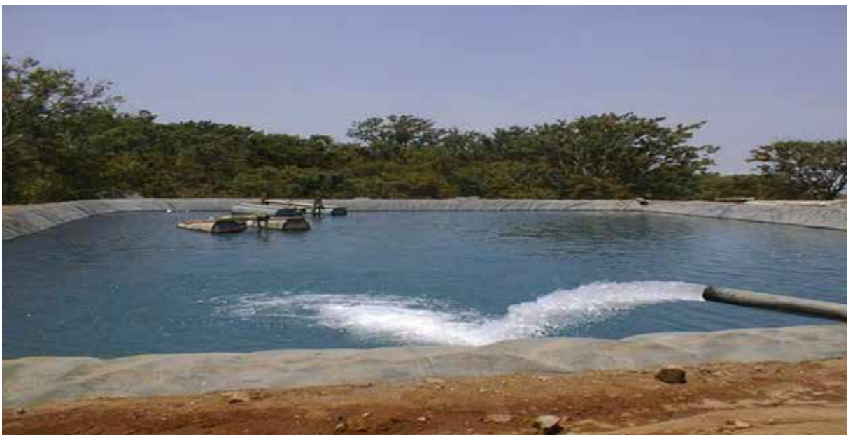
Fotografía 3 Laguna para el almacenamiento de agua en la plataforma. Se puede apreciar la geomembrana de impermeabilización de la laguna
