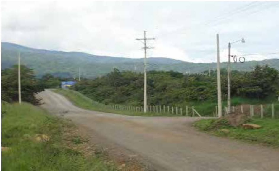
Fotografía 11 Construcción de pantalla natural en la unidad 1 de Pailas
