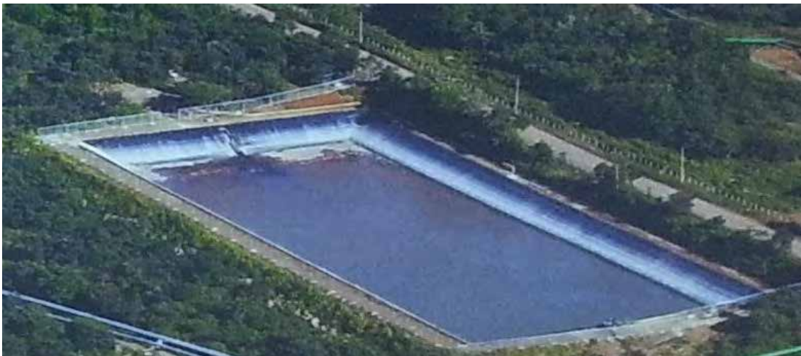
Fotografía 9 Laguna de reinyección en operación.
