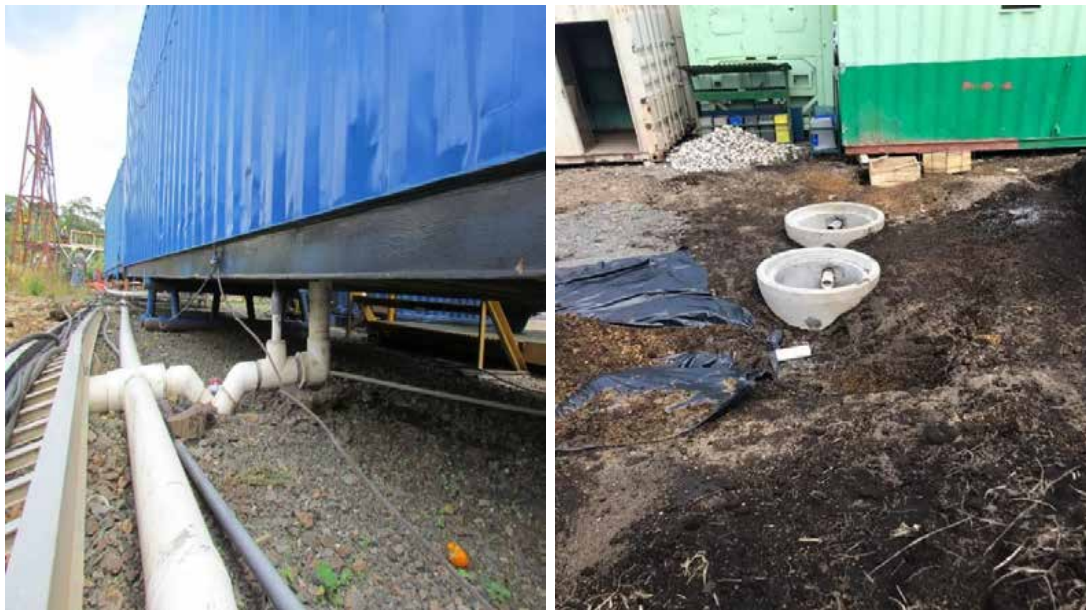
Figura 36. Manejo de aguas ordinarias en sitios de perforación.
