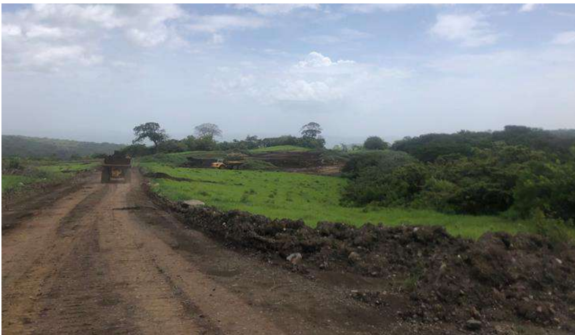
Figura 137. Escombrera 01, Conformación de acceso y conformación del relleno.
