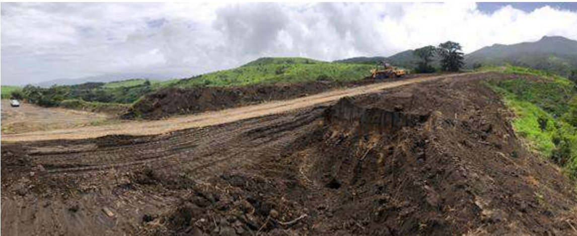
Figura 141. Limpieza de capa vegetal en PLB-05.
