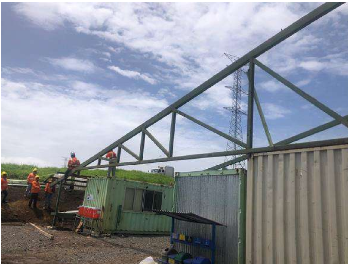
Figura 135. Construcción de estructura de techo para instalaciones provisionales.
