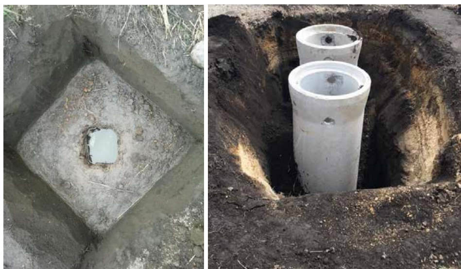
Figura 37. Prueba de infiltración e instalación de tanque séptico en la PGB-08.
