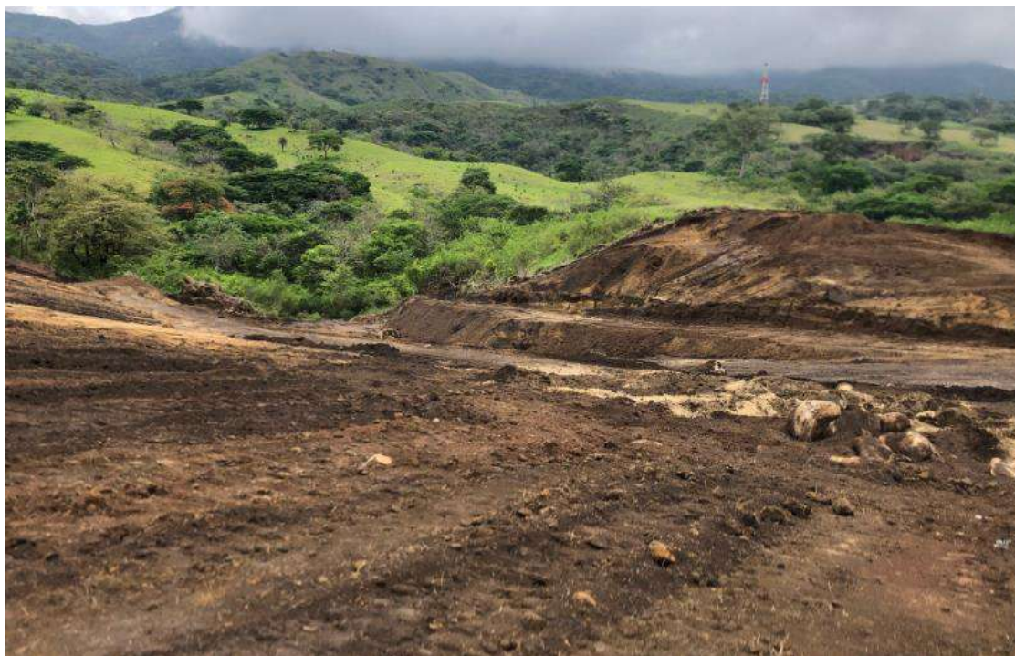
Figura 128. Movimiento de tierra en la plazoleta PLB-08, limpieza de capa vegetal.
