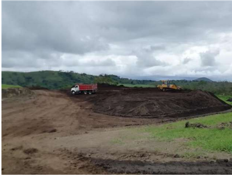
Figura 53. Separación de la capa superior de suelo.
