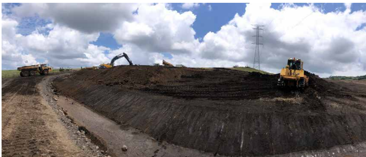
Figura 127. Movimiento de tierra en la plazoleta PLB-08, conformación de taludes en zona de corte.
