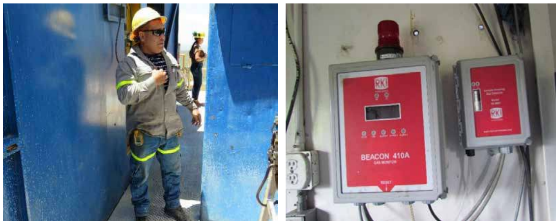
Figura 17. Detectores de gases utilizados en pruebas de producción y labores de perforación de pozos profundos.
