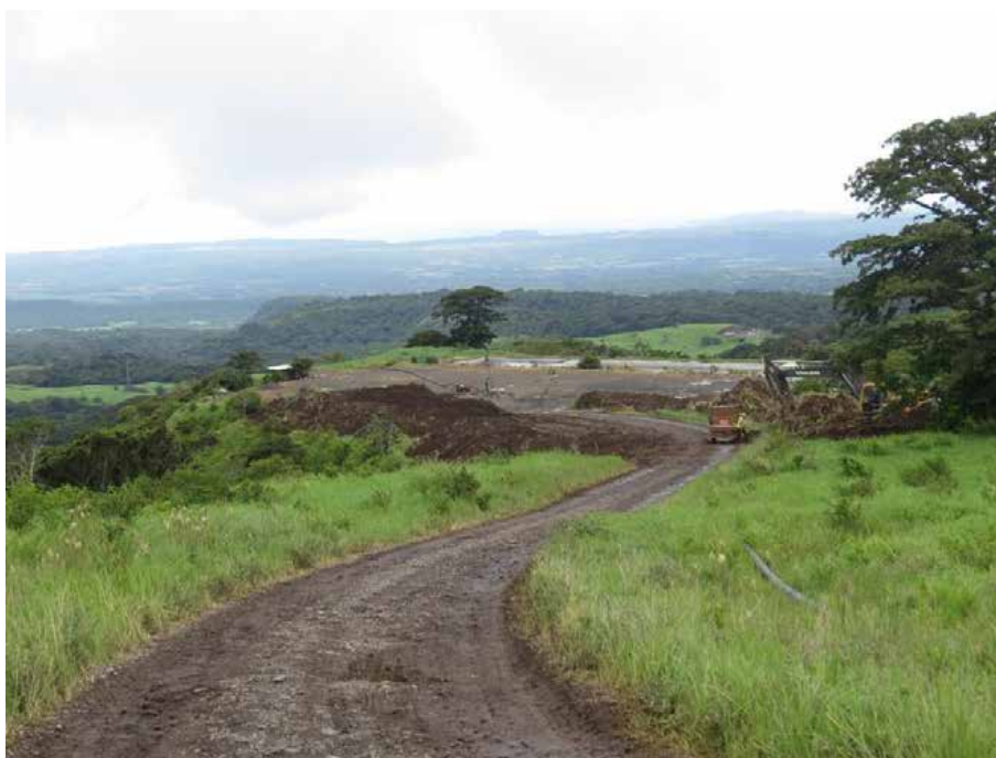
Remoción de capa orgánica para la ampliación de la Plazoleta PLB-05. Junio 2020.
