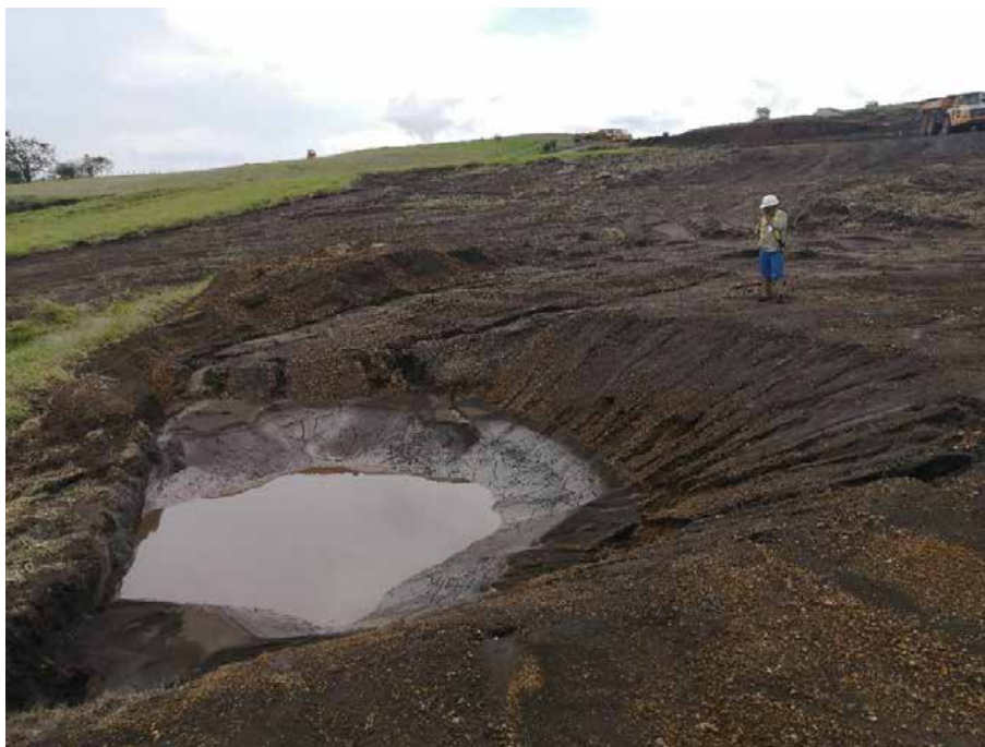
Sedimentador implementado durante proceso constructivo de la Plazoleta PLB-08. Mayo 2020.
