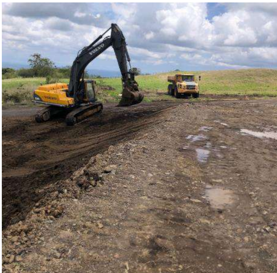
Figura 130. Movimiento de tierra en la plazoleta PLB-08, construcción de acceso.
