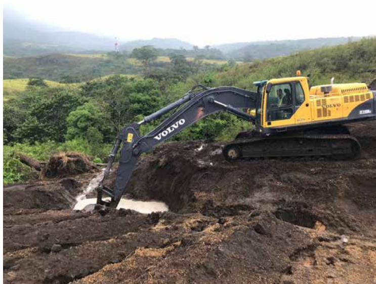
Figura 27. Mantenimiento de los sedimentadores temporales habilitados en la Plazoleta PLB-08.
