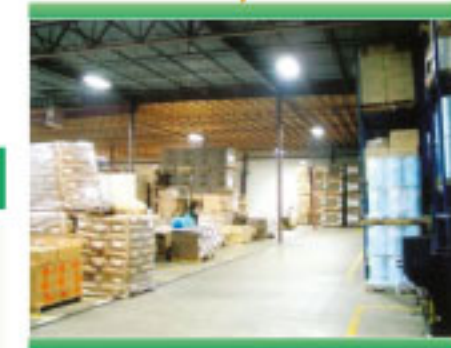
Ilustración 28: Sustitución de lámparas HID por Fluorescentes tubulares T5
