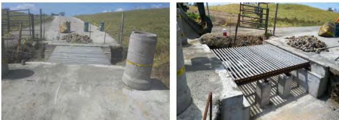
Figura 98. Instalación de quiebra patas.
