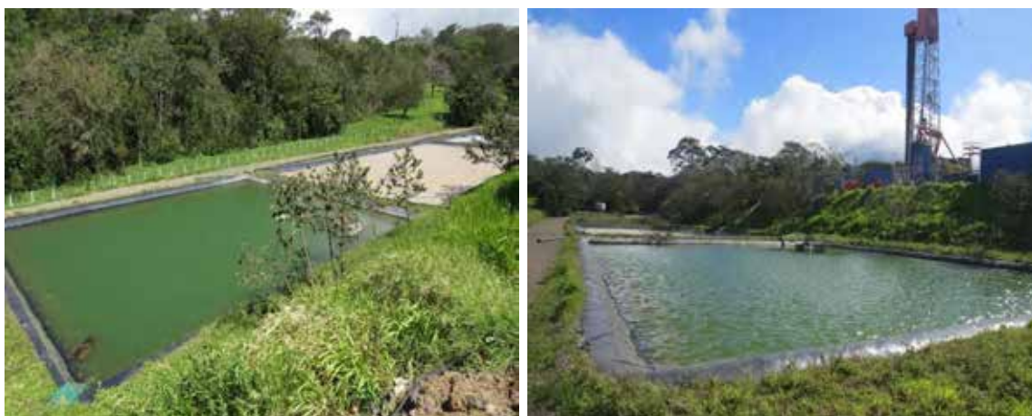
Figura 28. Lagunas impermeabilizadas en PLB-09.
