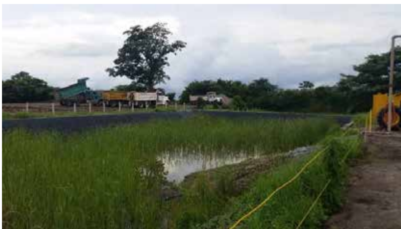
Figura 31. Laguna para vertido de aguas con sedimentos de la Planta de Concreto.
