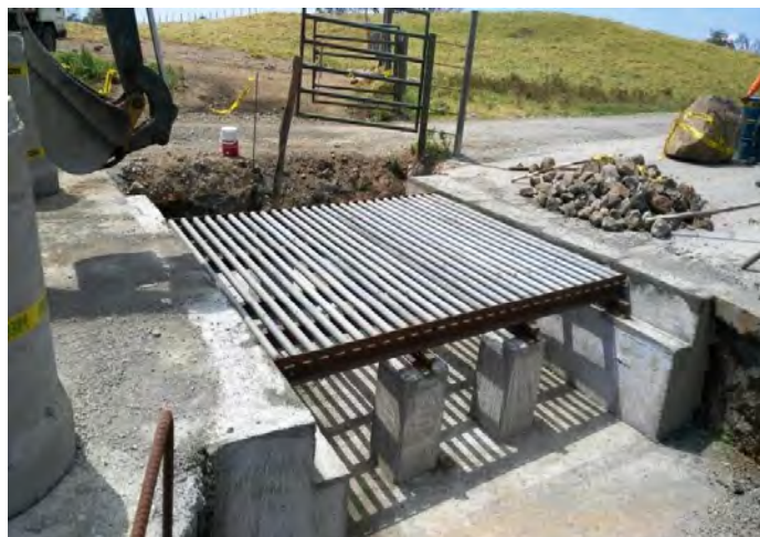
Figura 108. Colocación de quiebra-patas.
