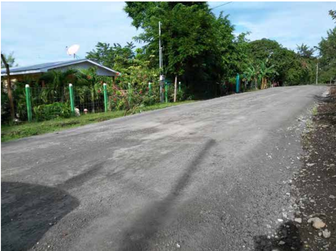
Colocación de RCC en camino en el sector de la comunidad de El Cedro. Diciembre 2016.
