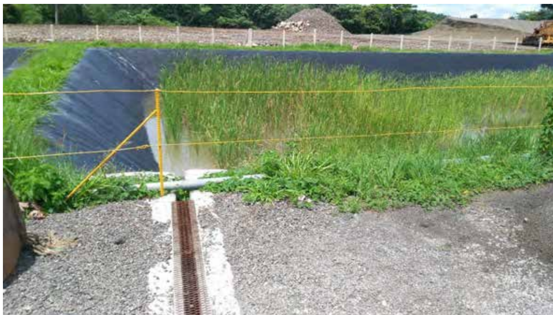
Figura 47. Lagunas para el manejo de agua residuales de la planta de concreto.
