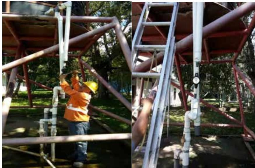
**Figura 97.** Instalación de medidor de agua en el campamento.
