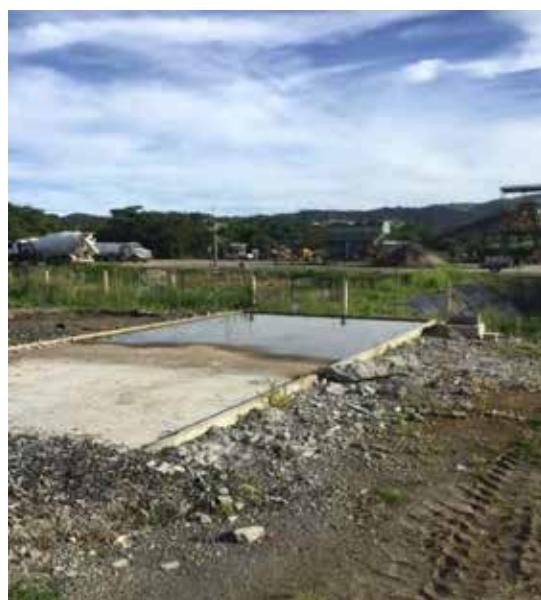
**Figura 28.** Losa para el mantenimiento de maquinaria.
