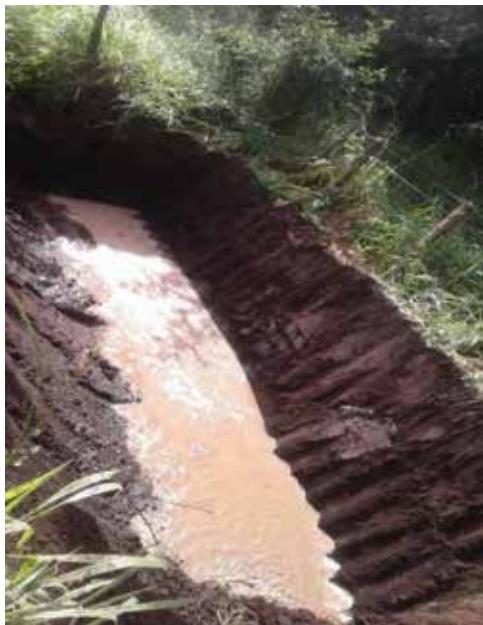
**Figura 23.** Sedimentador construido para manejo de aguas de la Escombrera 2.
