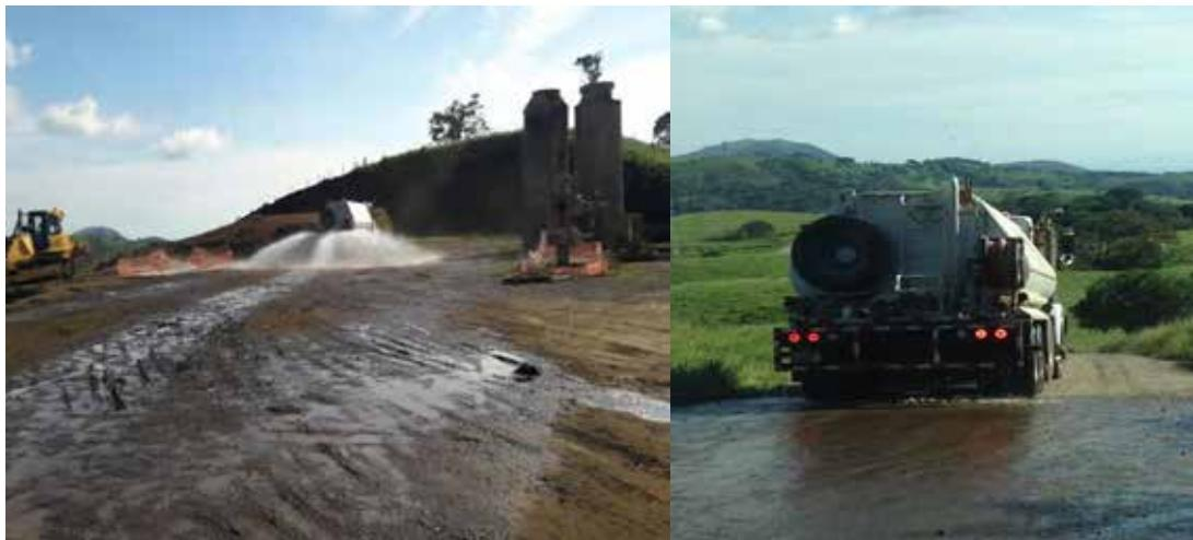
**Figura 15.** Riego de camino y obras para la reducción del polvo.
