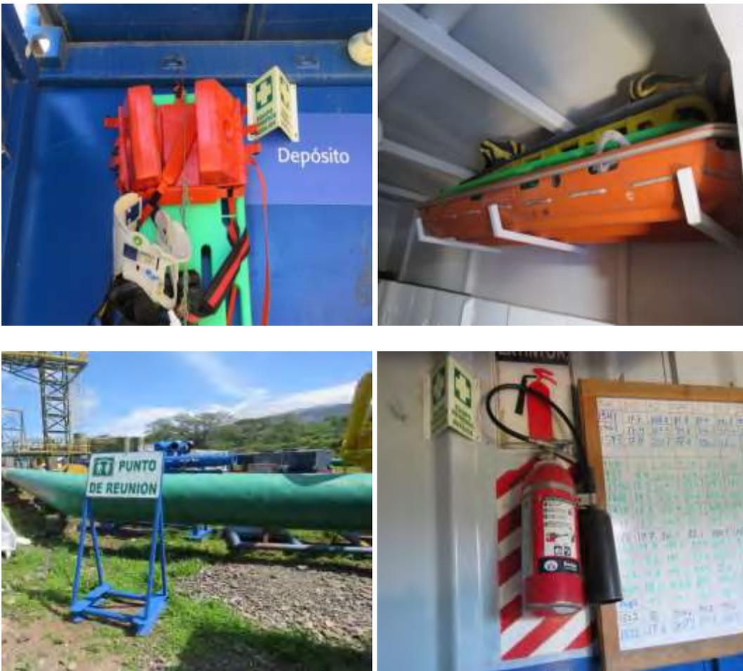
Figura 134: Equipo para emergencias médicas y extintores en perforadoras.
