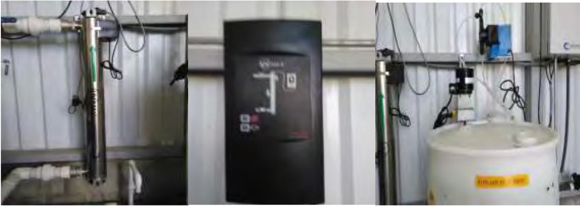
Sistema de desinfección del agua potable con hipoclorito de sodio y lámpara ultravioleta.
