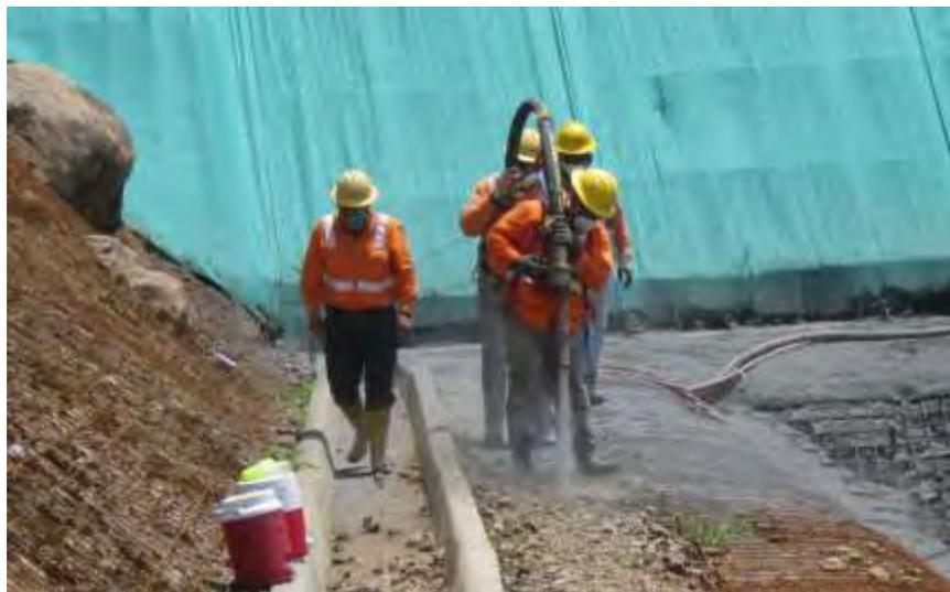
Figura 46. Uso de equipo de seguridad auditivo.
