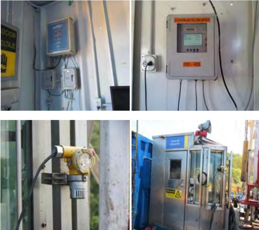
Figura 15: Detectores fijos con sistema de alarmas audibles de H<sub>2</sub>S y CO<sub>2</sub>
