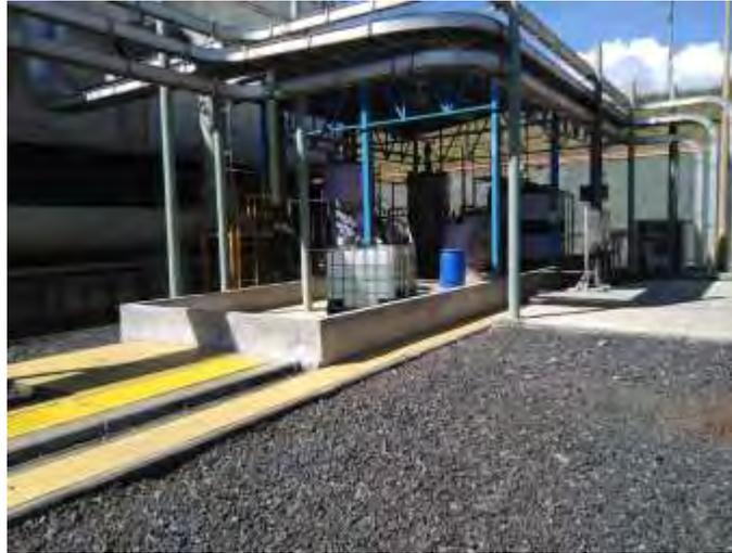
Sistema de soda, muros de contención de derrames se cuenta con un kit de contención de derrames de aceites en el laboratorio, esponjas y paños absorbentes.
