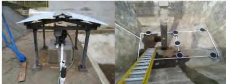
Colocación de las boquillas y soplador, se colocaron 6 boquillas
