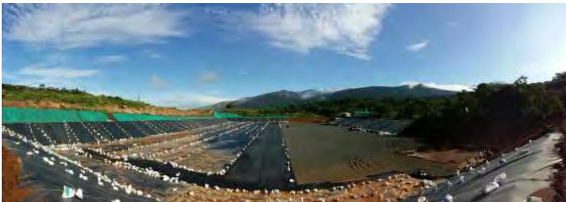
Figura 156. Impermeabilización de la Laguna 2.
