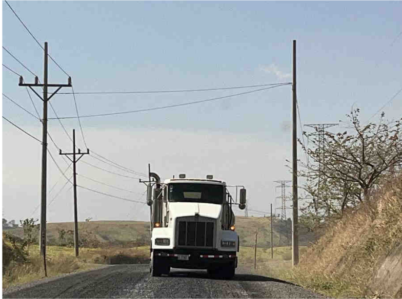
Figura 23. Irrigación de agua en frentes de trabajo internos del proyecto para mitigación de polvo.
