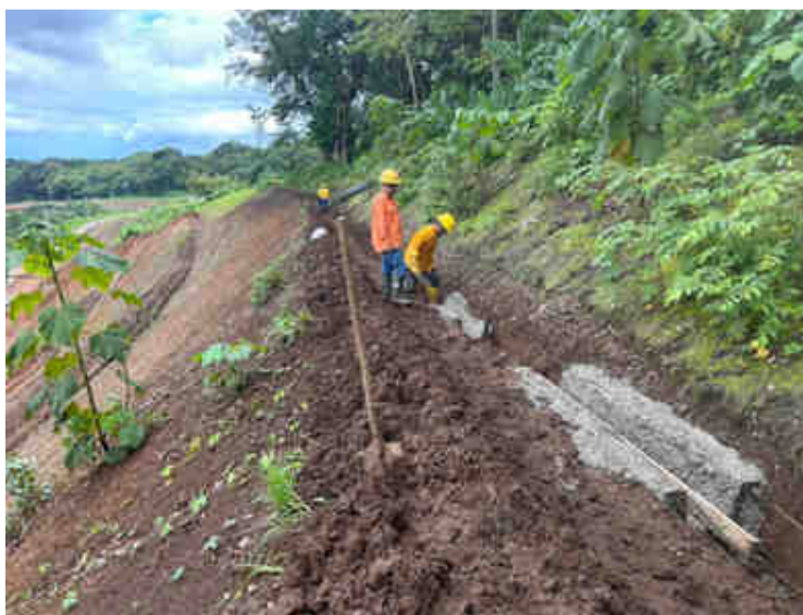
Figura 154. Construcción de cunetas de concreto para control de erosión.
