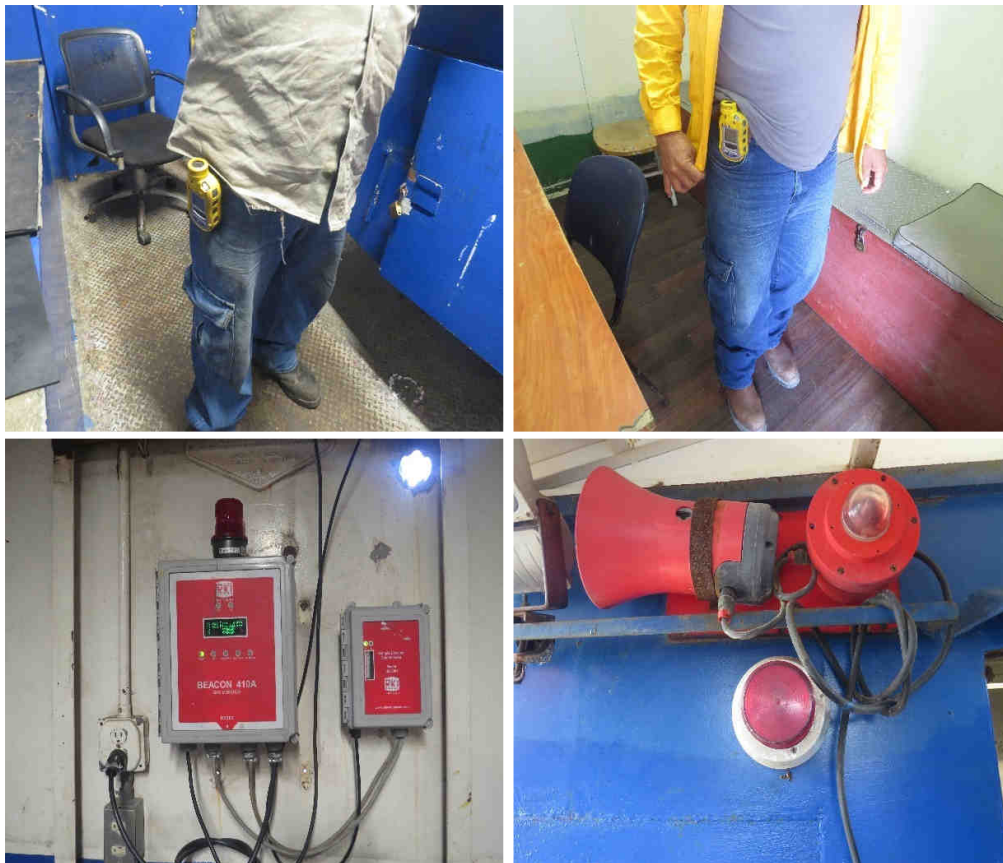
Figura 17. Detectores de gases utilizados en pruebas de producción y labores de perforación de pozos profundos.
