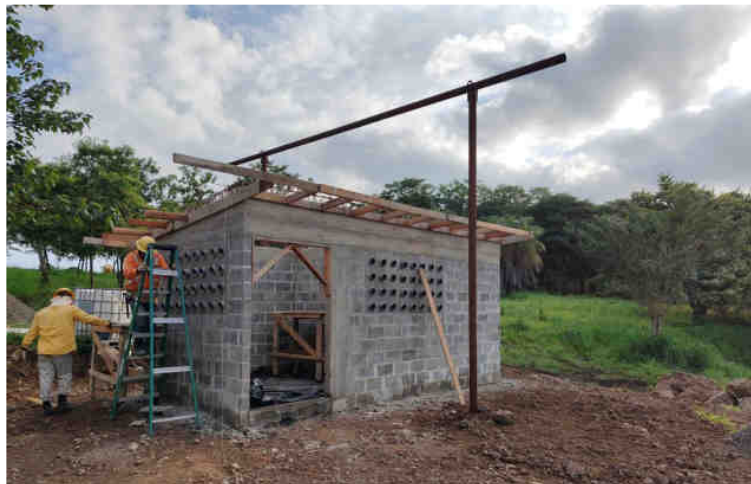
Figura 109. Construcción de Caseta de Control para pozo de agua potable El Cedro.
