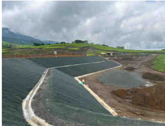
Obras de control de erosión: Colocación de Geomanto y cunetas de concreto en Taludes y Bermas
