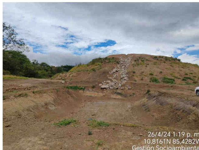
Figura 36. Sedimentador de la escombrera 1, invierno 2024.
