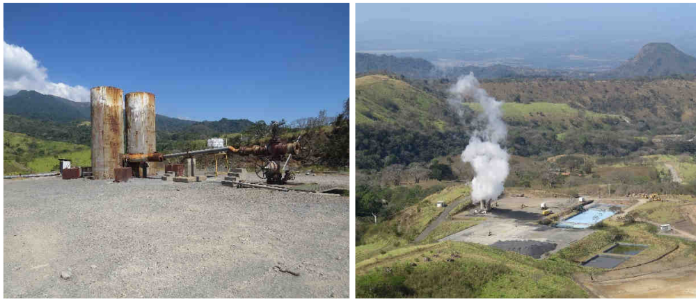
Figura 28. Sistemas de silenciadores colocados en pozos productores en el PG Borinquen (PLB-02).
