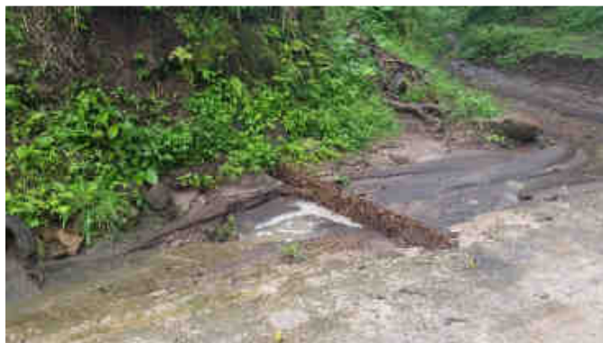
Figura 23. Barrera para sedimentación cerca de la Quebrada Gata.
