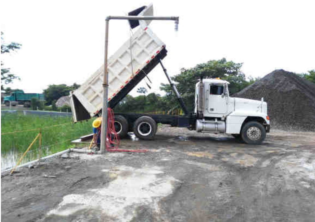
Lavado de vagonetas y manejo de residuos de concreto en fosa impermeabilizada ubicada en PGB-03. Agosto del 2016.
