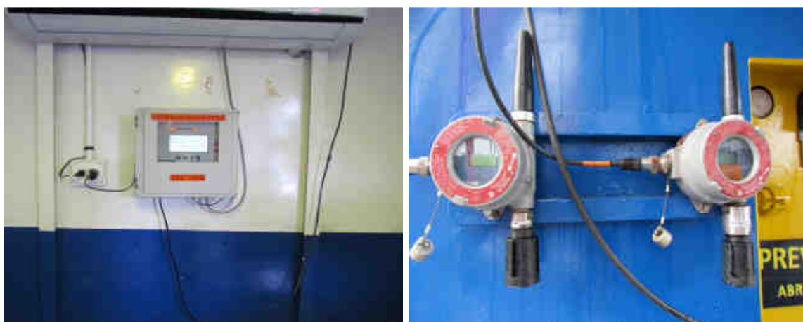
Figura 10. Detectores de gases utilizados en pruebas de producción y labores de perforación de pozos profundos.
