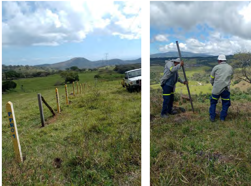
Figura 57. Construcción de cerca perimetral del Campo Geotérmico Borinquen.
