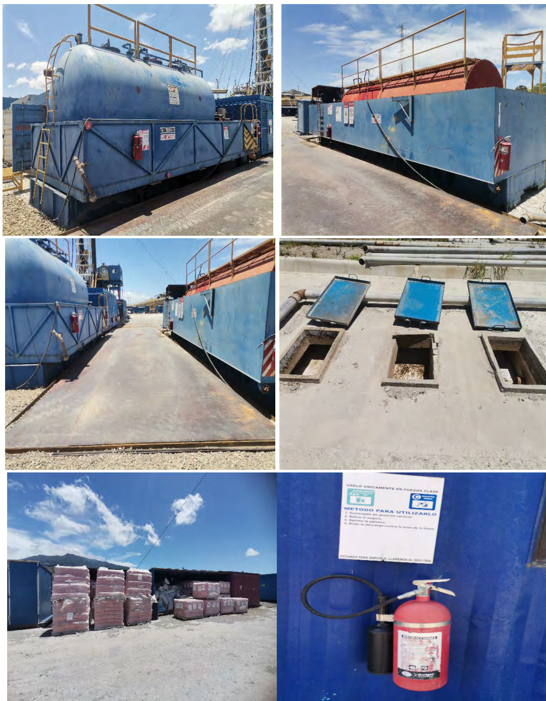
Figura 24: Áreas de almacenamientos de sustancias químicas peligrosas.
