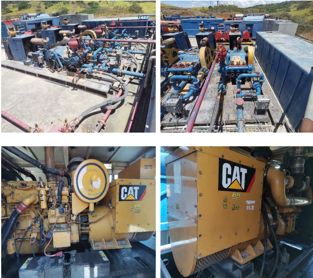
Figura 8. Panorámica de los equipos de perforación.
