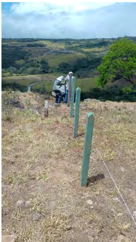
Proceso de construcción de cerca perimetral. Febrero 2022.
