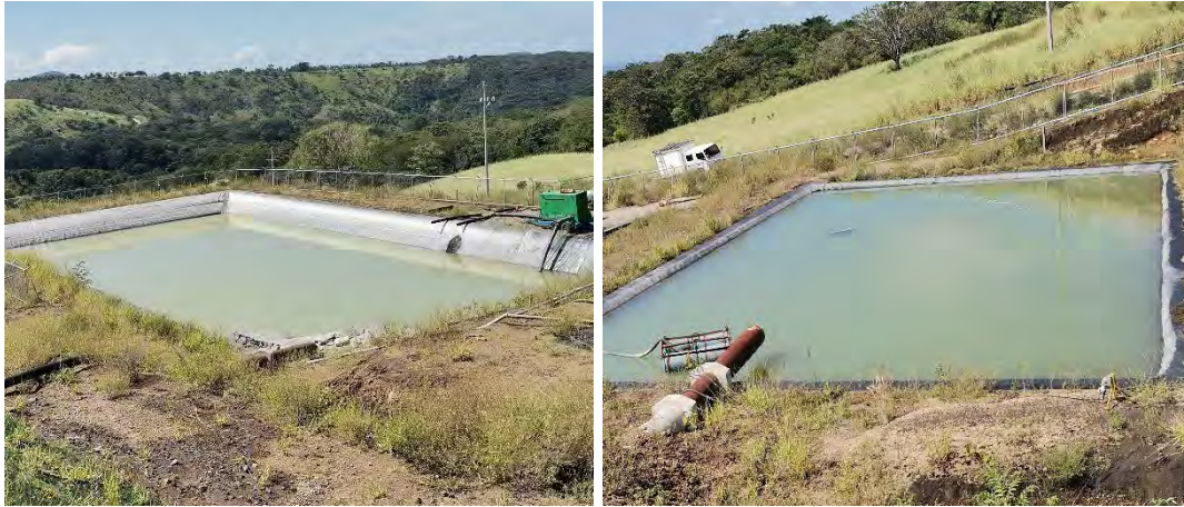
Figura 27. Lagunas impermeabilizadas en PLB-08.
