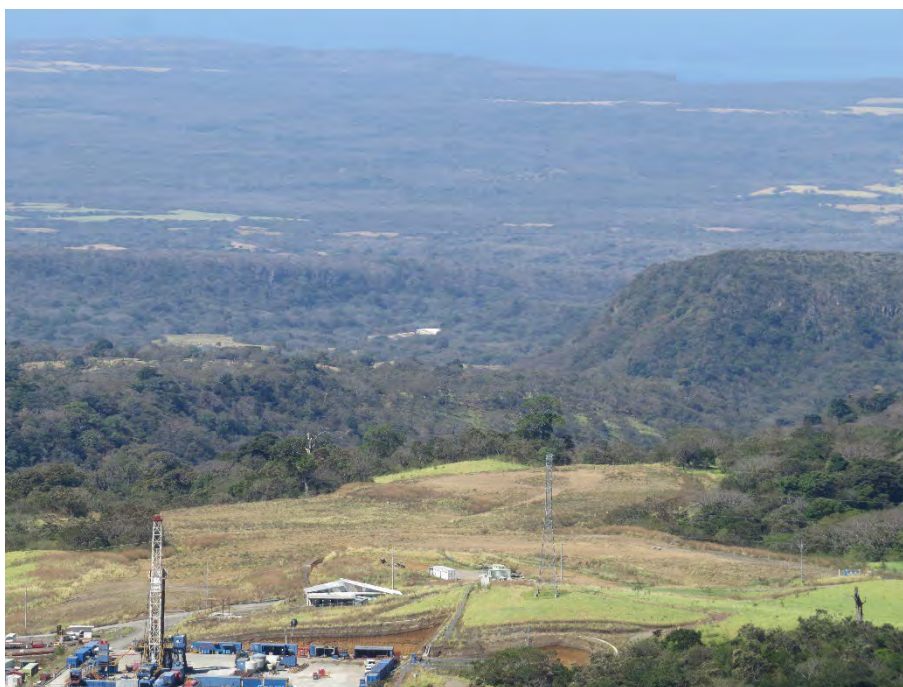
Vista panorámica sitio de obra Escombrera 1. Febrero 2022.
