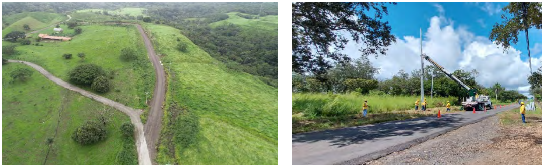
Figura 120. Línea de distribución eléctrica del PG Borinquen.
