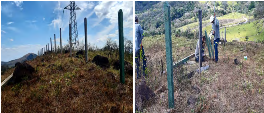
Figura 103. Colocación de cerca perimetral, marzo, 2022.
