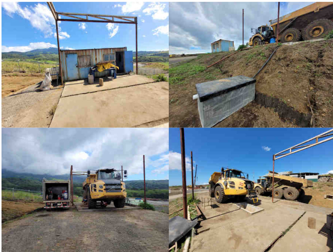
Figura 11. Losa temporal de reparación de equipos y maquinaria.
