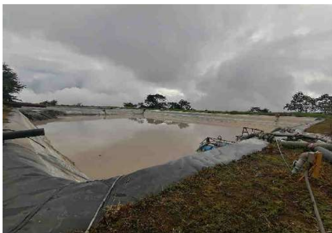
Figura 39. Lagunas impermeabilizadas en PLB-05.
