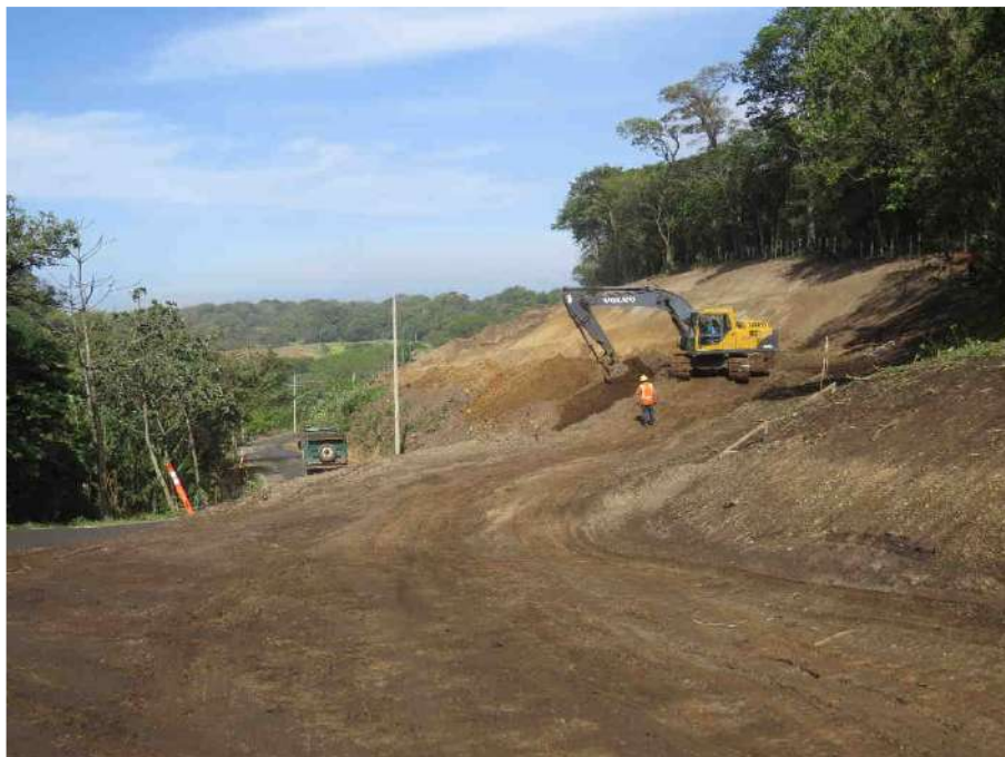
Excavación en sitio de obra Tubería de fluidos geotérmicos, ampliación de camino en sector ruta norte. Marzo 2023.
