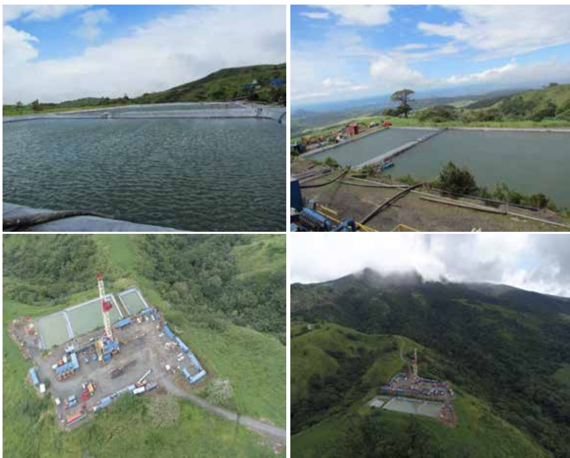
Figura 25. Lagunas impermeabilizadas en PLB-5.
