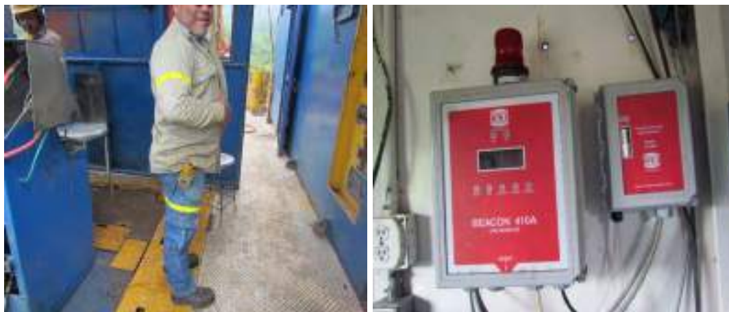
Figura 16. Detectores de gases utilizados en pruebas de producción y labores de perforación de pozos profundos.
