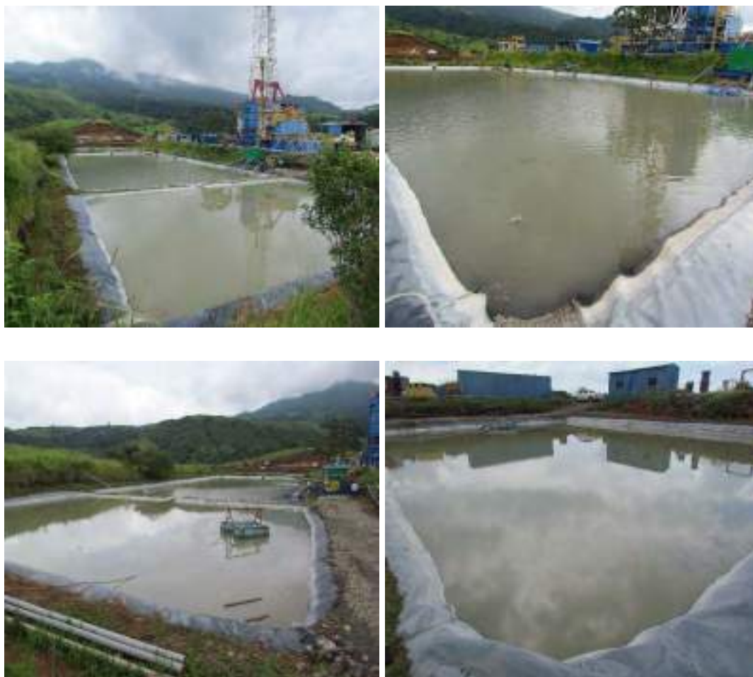
Figura 33. Lagunas impermeabilizadas en PLB-02
