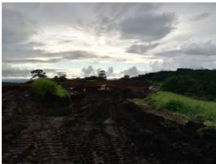
Figura 56. Separación de la capa superior de suelo.
