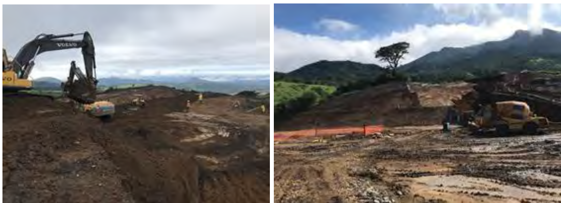
Figura 132. Excavación del camino de acceso y conformación de talud.
