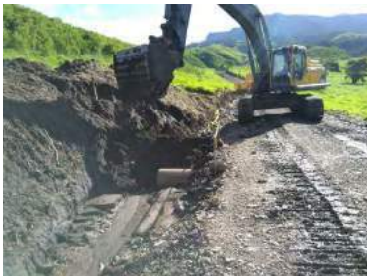
Figura 27. Mantenimiento de los sedimentadores naturales habilitados en la PGB.
