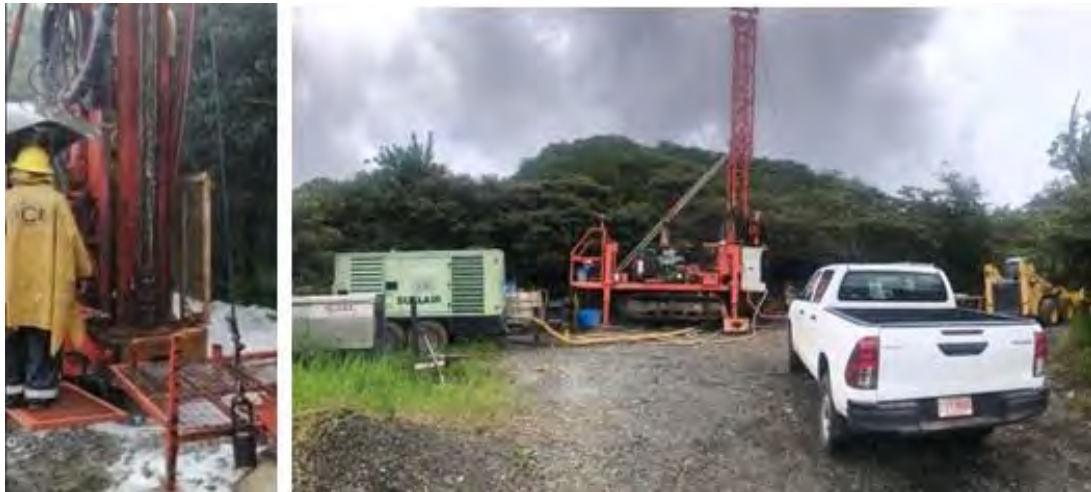
Figura 146. Pozos de abastecimiento para agua de trabajo.
