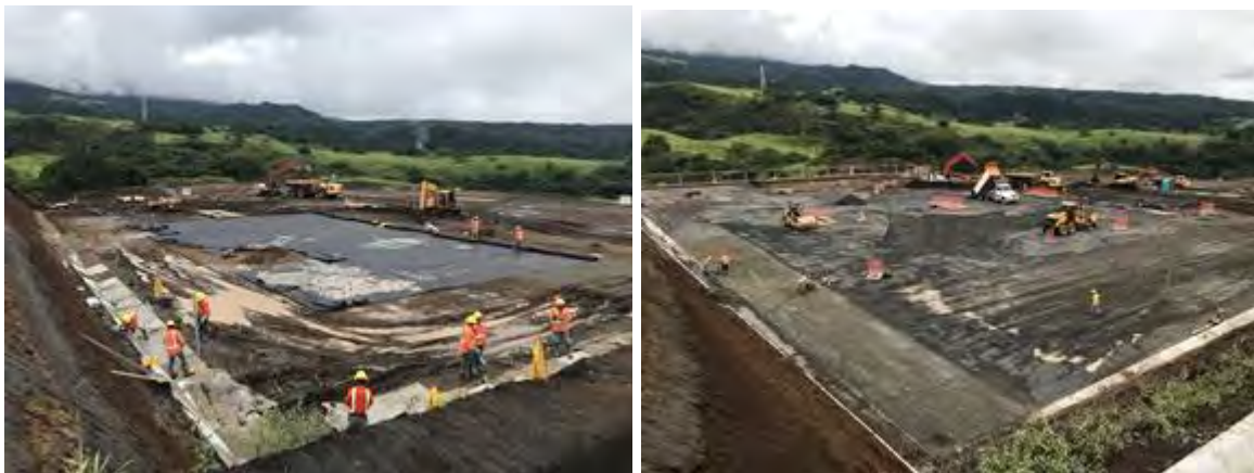
Figura 131. Conformación de terraza y taludes en PLB-08.
