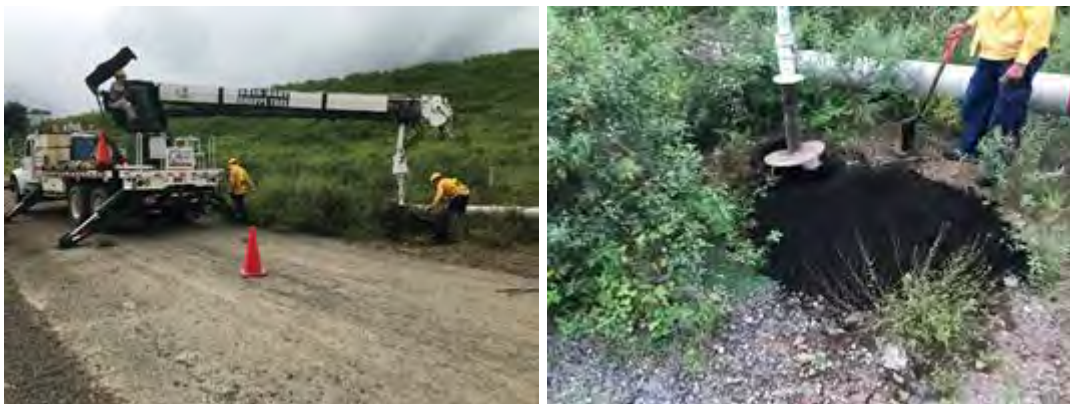
Figura 136. Excavación de pozos para postes.
