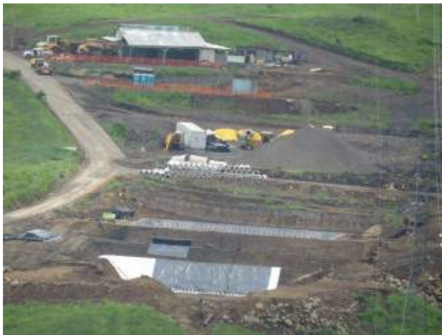
Impermiabilización de fosas en la Plazoleta PLB-08. setiembre 2020.
