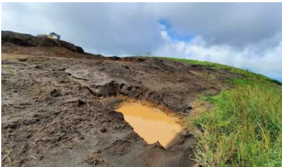
Sedimentador implementado durante proceso constructivo de la Laguna de almacenamiento LGB-05. Noviembre 2020.
