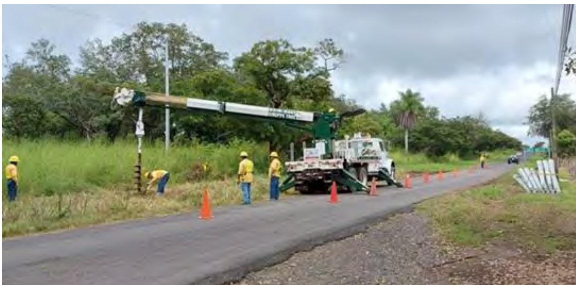
Figura 144. Posteo de Línea de Distribución Eléctrica.
