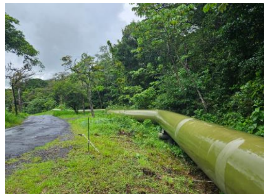
Figura 29. Tuberías de transporte de vapor con uso de tonos que minimizan el impacto visual en campo
