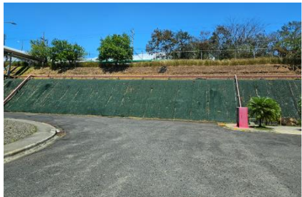
Figura 62 Taludes y estado de geomembrana en Unidad I PG Las Pailas
