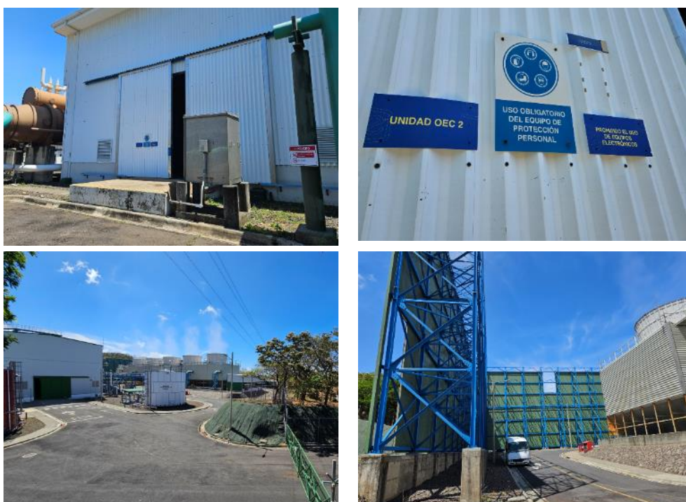
Figura 32 Casas de máquinas de Unidades I y II con puertas cerradas y pantalla sónica en Unidad II
