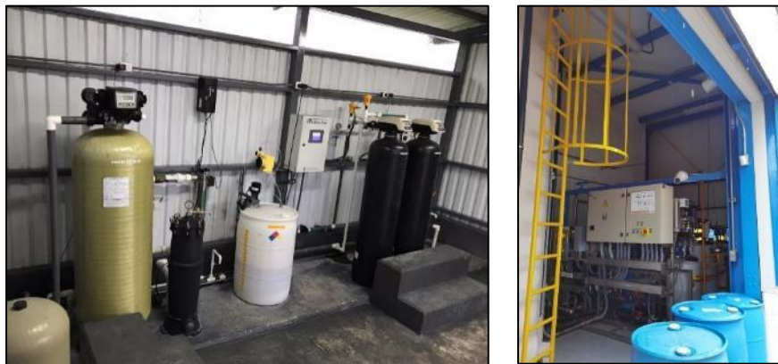
Figura 66 Sistemas de filtración y desinfección del agua de ambas unidades
