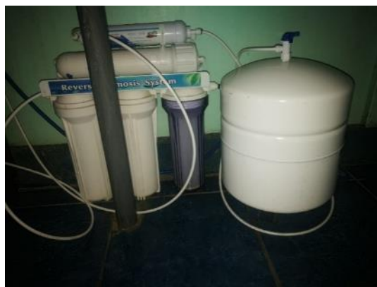
Figura 67 Sistema de osmosis inversa instalado en comedores
