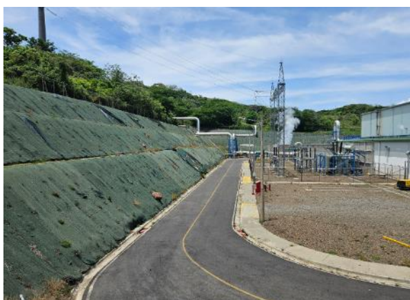
Figura 63 Taludes y estado de geomembrana en Unidad II PG Las Pailas
