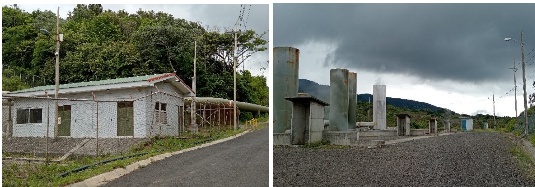
Figura 31. Iluminación en caminos en Campo Geotérmico Las Pailas.
