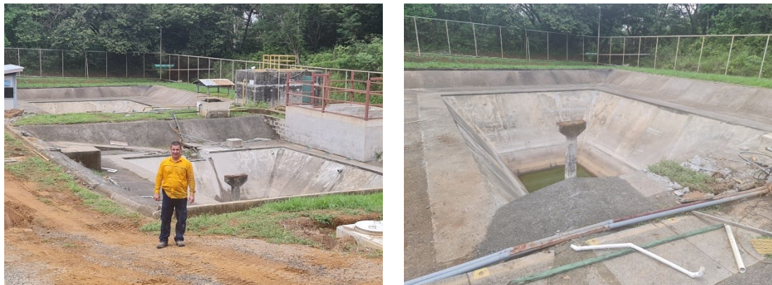
Figura 20 Retiro de todos los equipos, cables, paneles eléctricos, techos, barandas, y tuberías a las que se les dará un segundo uso
