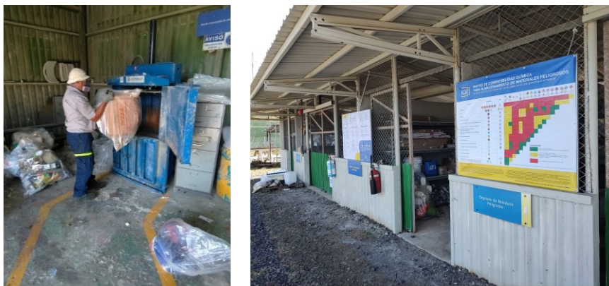
Figura 10 Centros de transferencia de Residuos del Campo Geotérmico (izq) y Planta (der)
