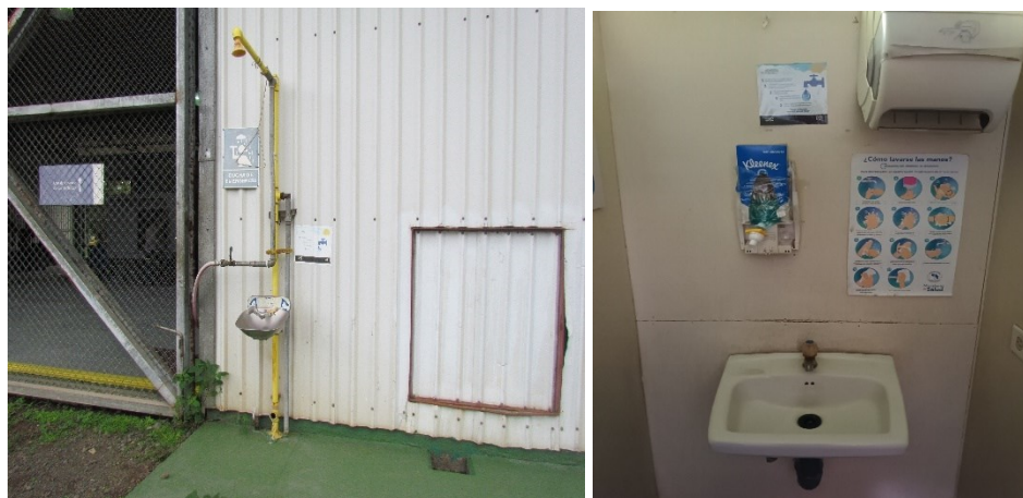
Figura 26. Ayudas visuales colocadas en sitio de consumo y verificadas en rutas de inspección.
