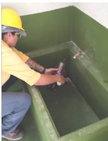
Aplicación de tinte rojo en pila de taller Pailas I Verificación de tinte en caja de registro
