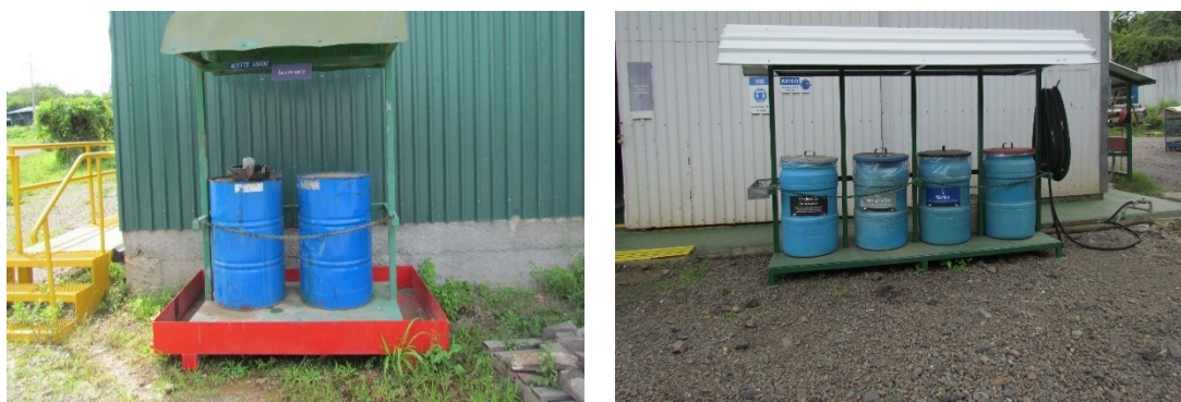
Figura 9 Ejemplos de Áreas de acopio temporal de residuos en instalaciones
