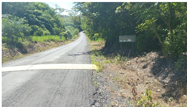
Figura 54. Inspección de reductores de velocidad y señalización. CGP. I Semestre 2023.
