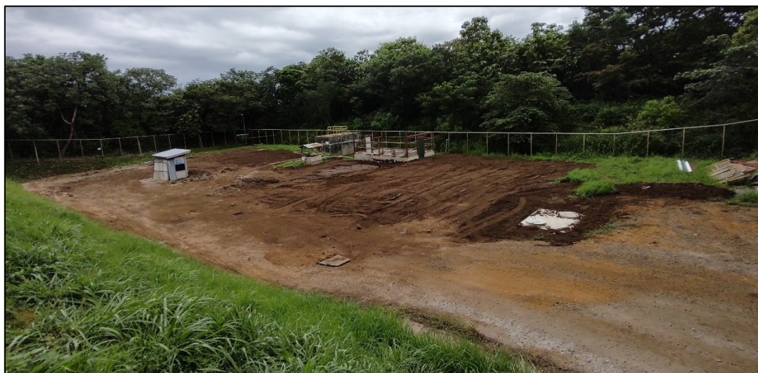
Figura 21 Relleno concluido de las fosas de la PTAR
