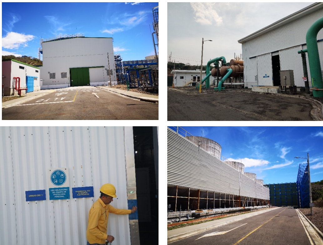
Figura 34 Estado de casas de máquinas cerradas para evitar salida de ruido en Planta
