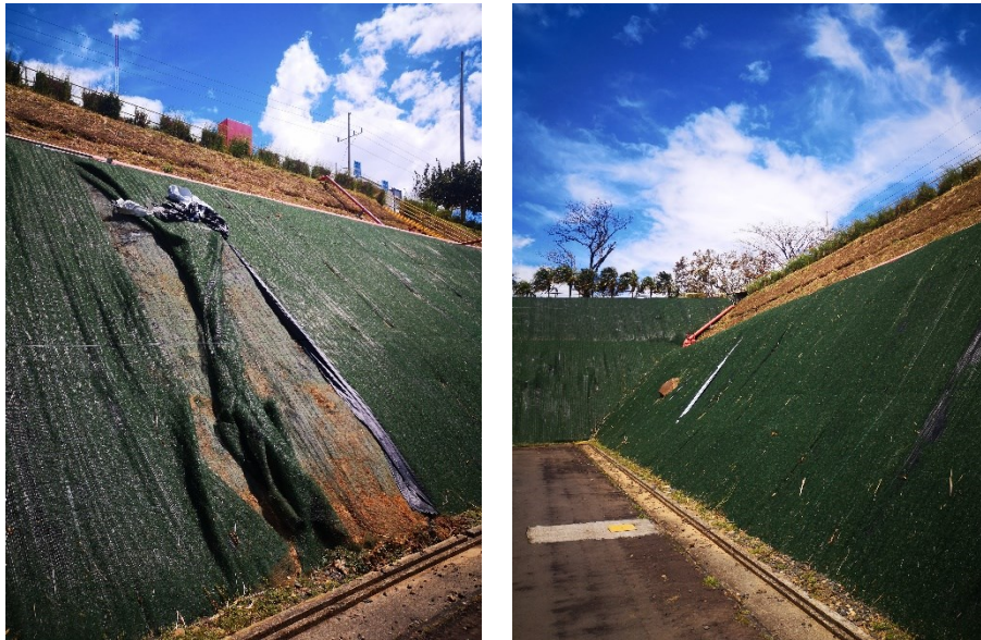
Figura 58 Taludes y estado de geomembrana instalada en la Unidad I
