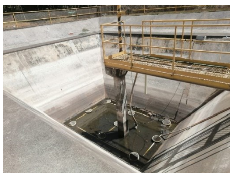
Figura 17 Fosas de la PTAR secas y libres de aguas residuales
