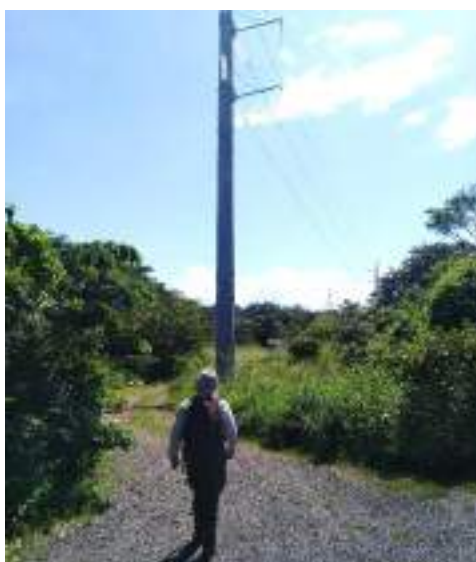
Figura 53. Recorridos en ruta de la Línea de Transmisión, agosto 2019.
