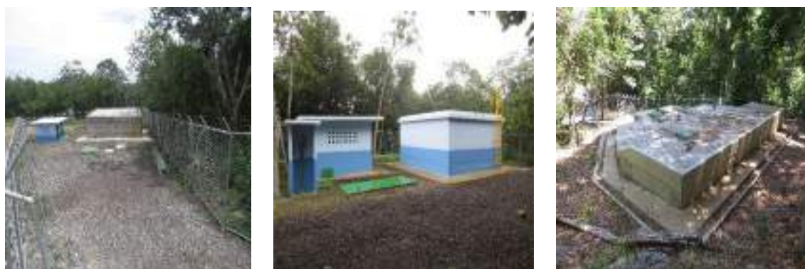
Figura 58. Principales obras, acueducto Curubandé, III Trimestre, 2019.
