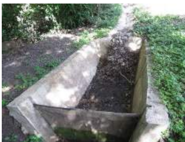
Figura 24. Inspección de sedimentadores en julio 2019.
