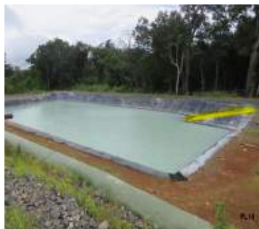
Figura 4. Lagunas impermeabilizadas en el AP
