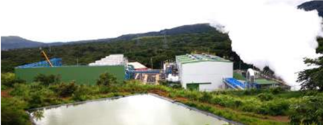
Figura 20. Etapa final de la construcción de la barrera sónica en Planta Unidad II
