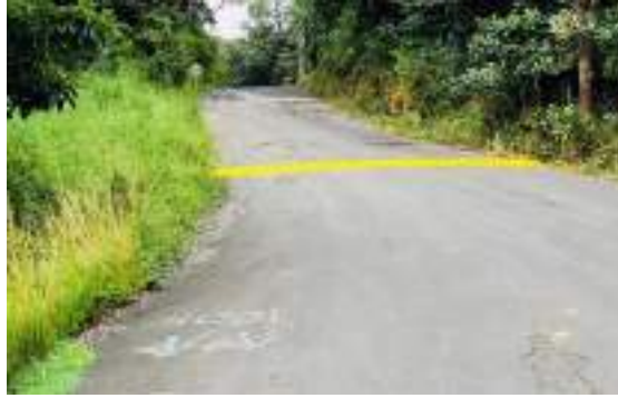
Figura 25. Reductor de velocidad en vía de acceso a la Planta.
