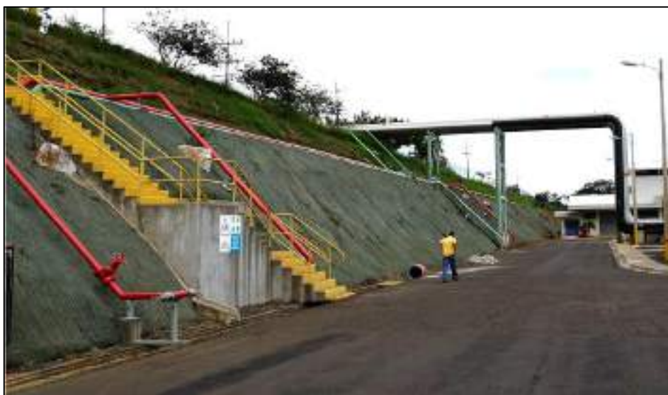
Figura 74. Estabilización de terrenos alrededor de la unidad I, lo cuales están recubiertos con geo membrana de color verde. En la parte superior se observan árboles, vetiver y arbustos que minimizan los efectos sobre el cambio del paisaje.
