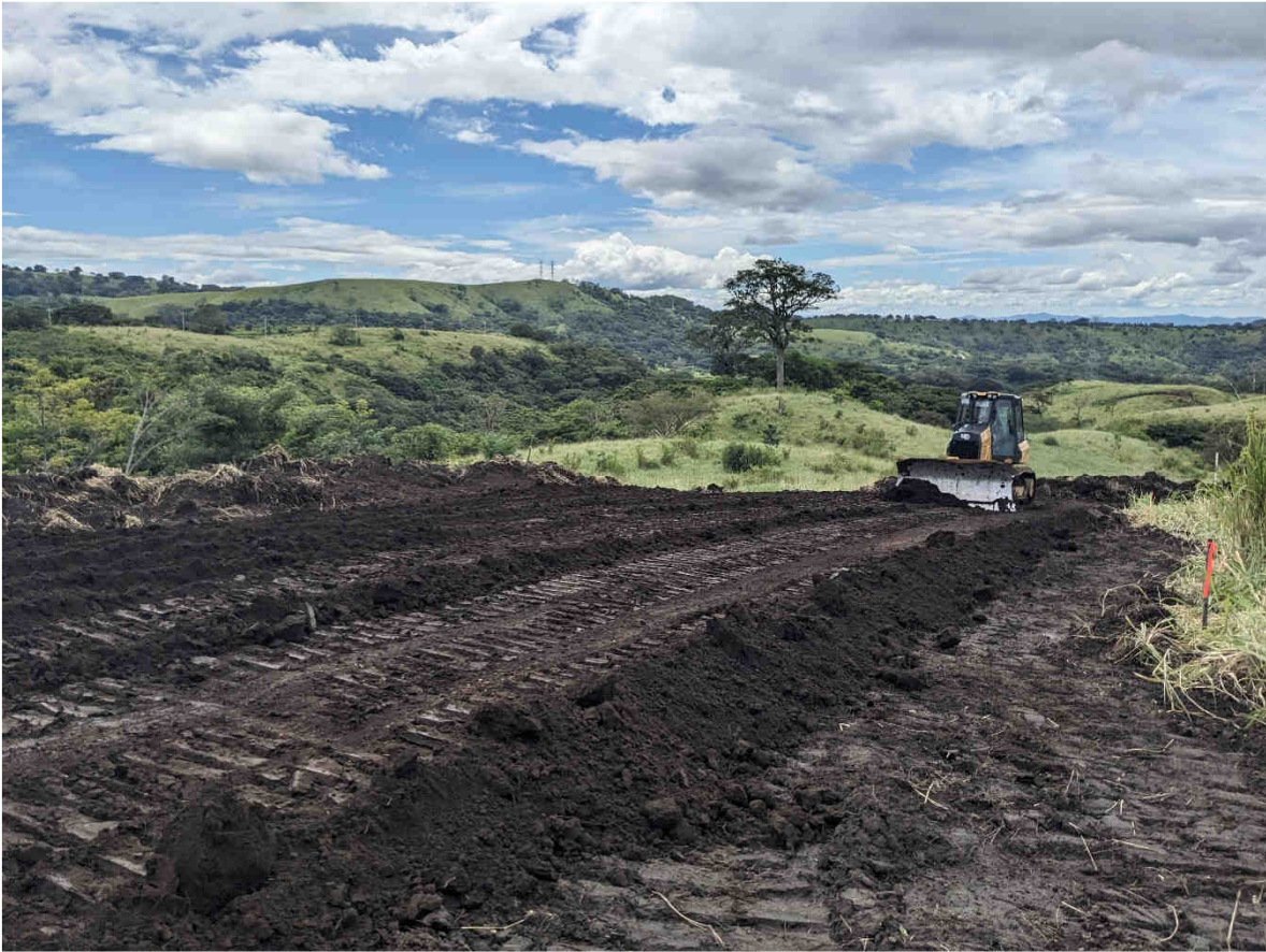
Figura 152. Movimiento de tierra con tractora para obra tramo central-ruta sur.
