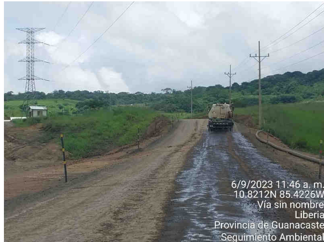
Figura 21. Irrigación de agua en frentes de trabajo internos del proyecto para mitigación de polvo.
