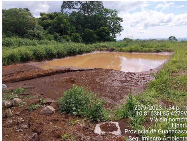
Figura 31. Sedimentador de la escombrera 1.
