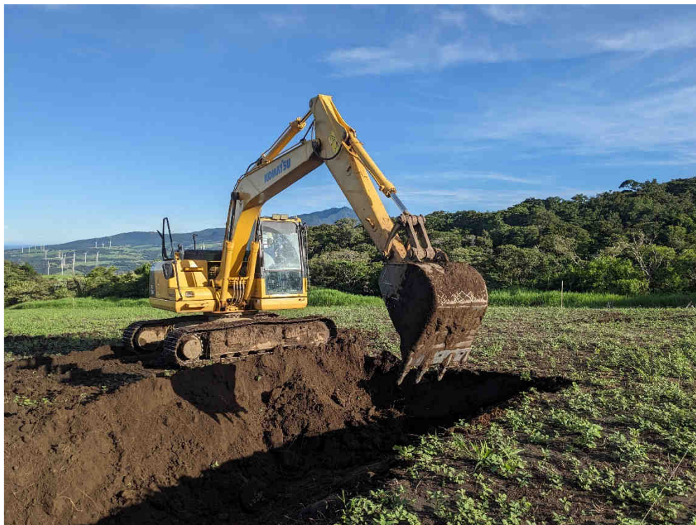
Figura 149. Movimiento de tierra con excavadora para estación separadora 5.
