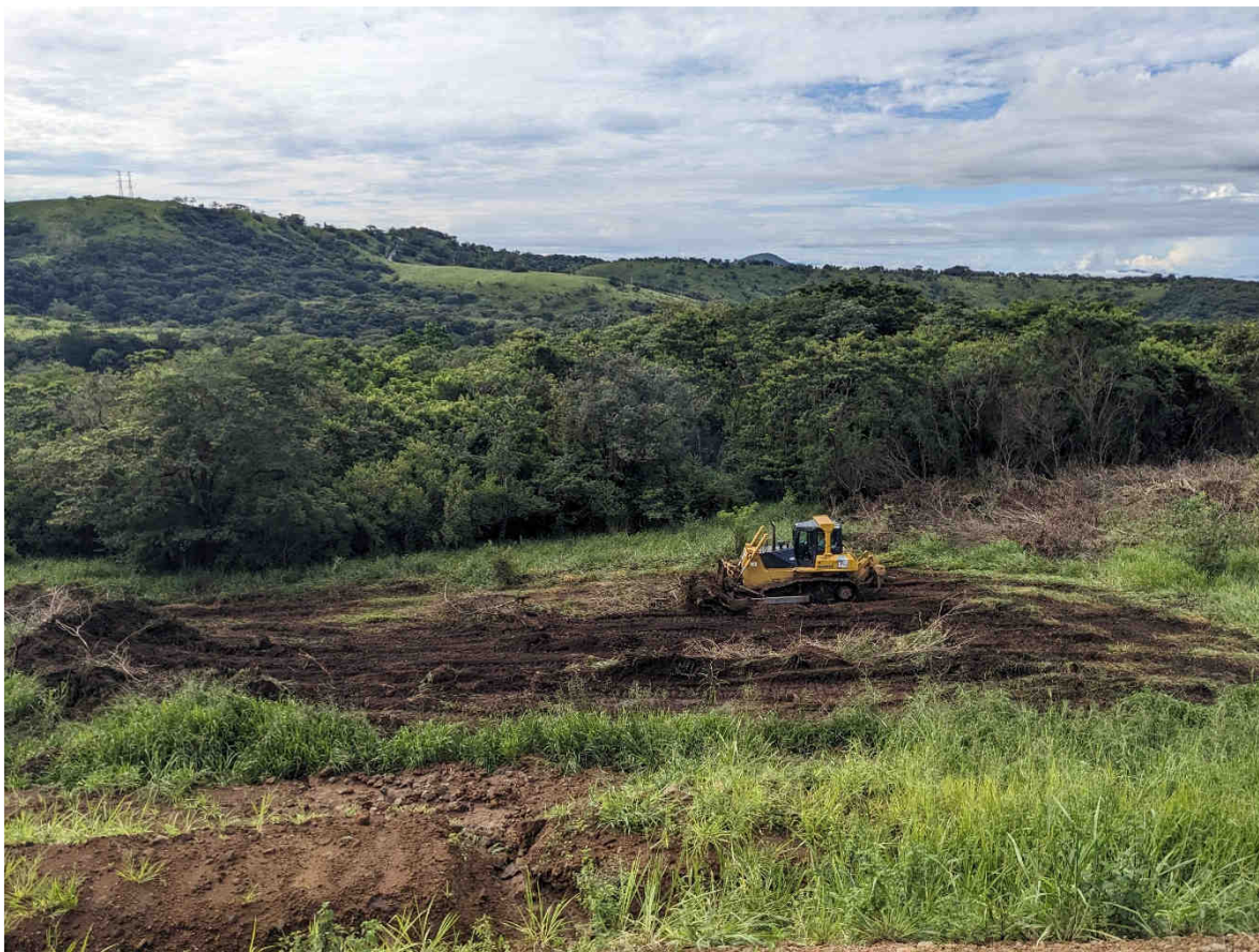
Figura 150. Movimiento de tierra con tractora para ampliación de Escombrera 1.
