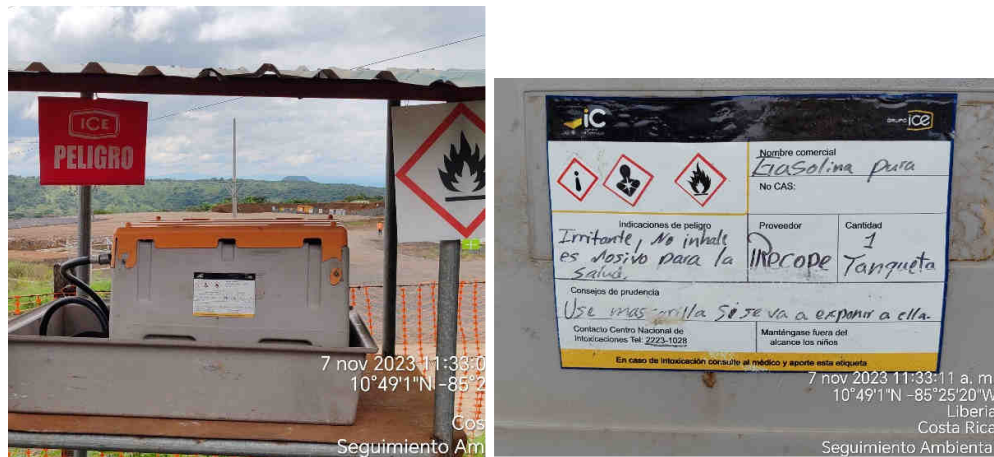
Figura 36. Contenedor de almacenamiento de combustible.
