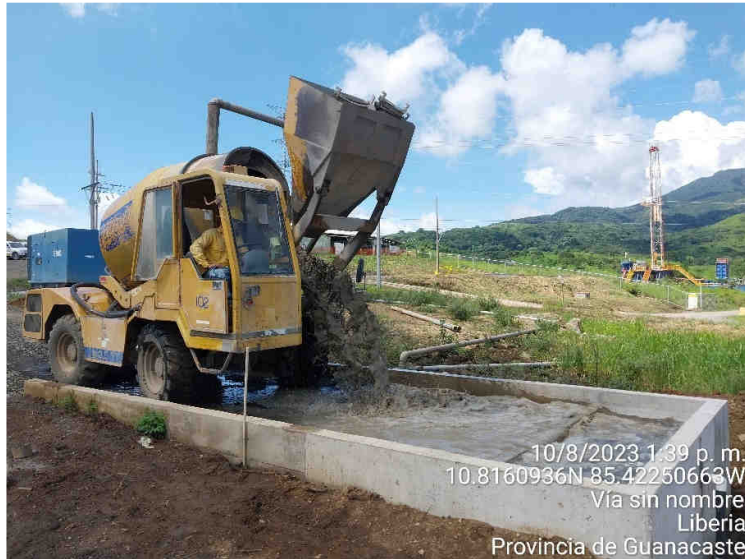
Figura 70. Lavado de autohormigonera posterior a colocación de concreto.
