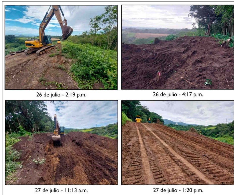
Figura 131. Movimiento de tierras para ampliación de ruta norte.
