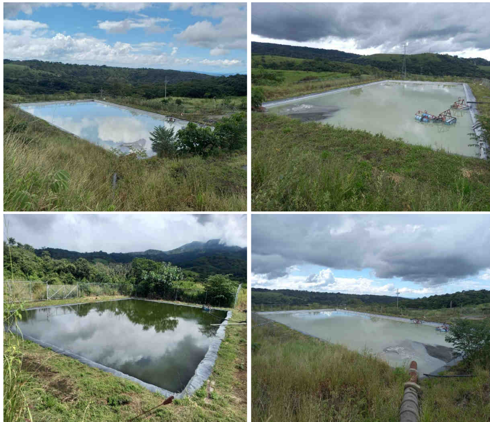
Figura 40. Lagunas impermeabilizadas en PLB-08.
