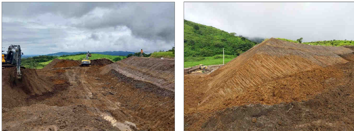
Figura 133. Talud con 10 metros de corte efectuado durante la supervisión de movimientos de tierra para tubería bifásica PLB-05.
