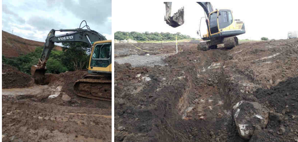
Figura 29. Limpieza de sedimentadores.
