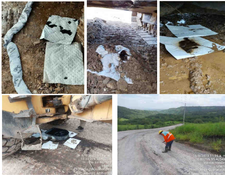
Figura 38. Uso de equipo de contención de derrames en diferentes circunstancias.
