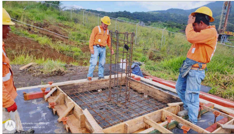
Figura 177. Diseño general y proceso constructivo de cimientos para tuberías de vaporductos.
