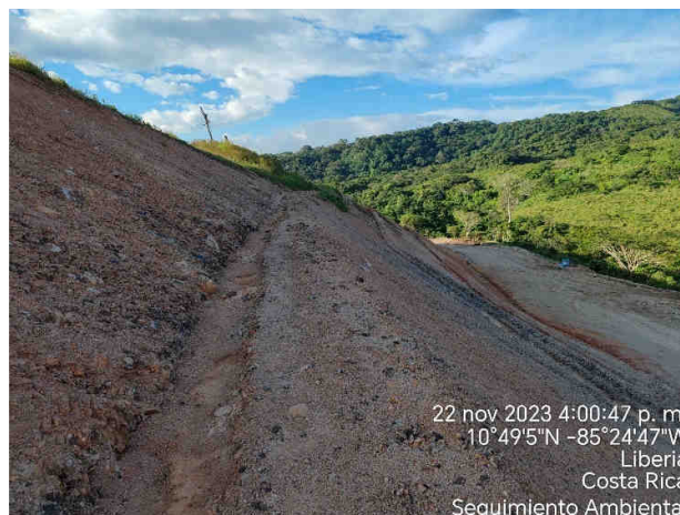
Figura 28. Canales en taludes para manejo de aguas y sedimentos.
