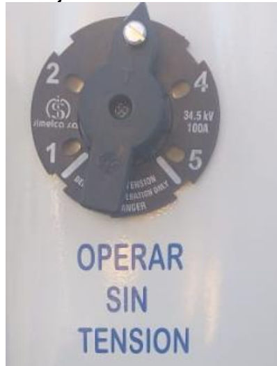
Imagen 16. Imagen representativa de etiqueta de ejemplo de no operar con tensión junto al cambiador de derivaciones
