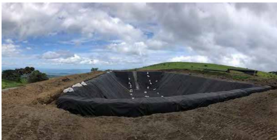
Figura 76. Laguna secundaria para el almacenamiento de agua de trabajo en proceso de construcción.
