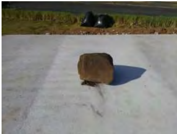
Figura 115. Loza de concreto.
