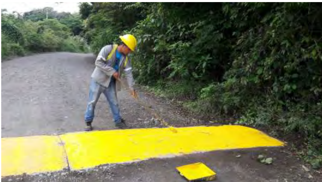
Figura 82. Mantenimiento a reductor de velocidad ubicado en los accesos a sitios de obra.
