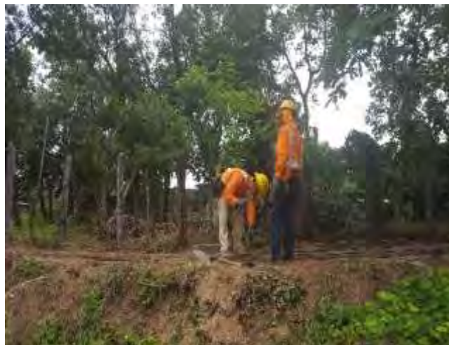
Figura 135. Construcción de aceras, Curubandé, II trimestre 2017.
