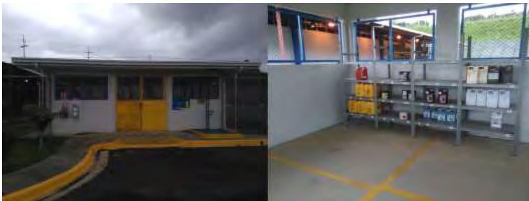
Figura 157. Vista del exterior e interior de la bodega de químicos, los edificios están en buenas condiciones, no hay derrames.
