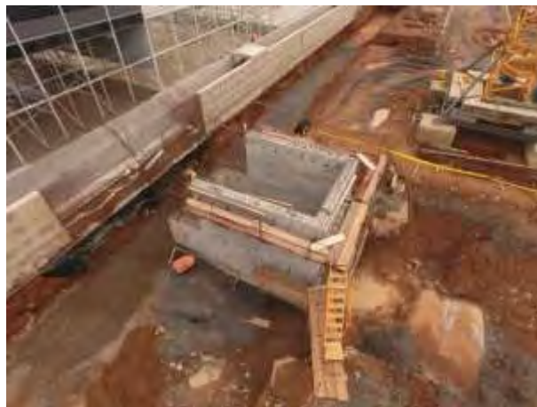
Figura 142. Avance en el foso de aspiración.
