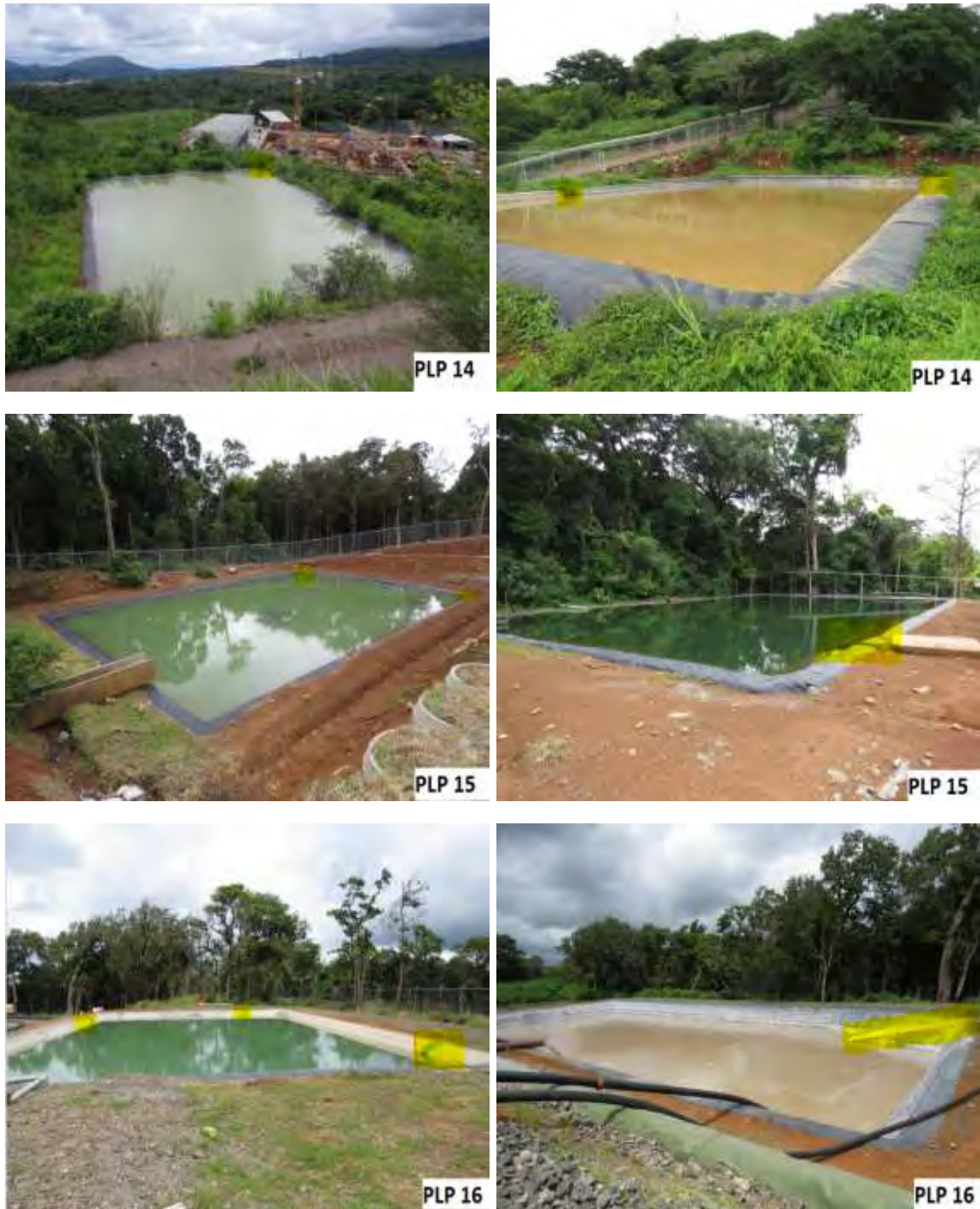
Figura 29. Dispositivos para escape de fauna en plazoletas de perforación.
