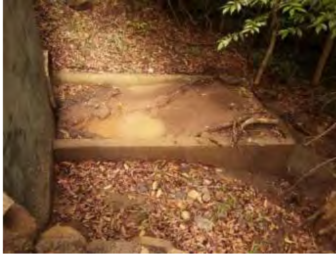
Figura 64. Inspección de sedimentadores en junio 2017.
