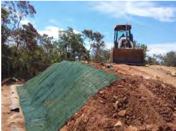
Figura 107. Cobertura de residuos orgánicos en relleno sanitario.
