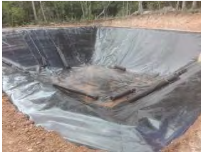
Figura 145. Impermeabilización fosa de bypass Laguna 04
