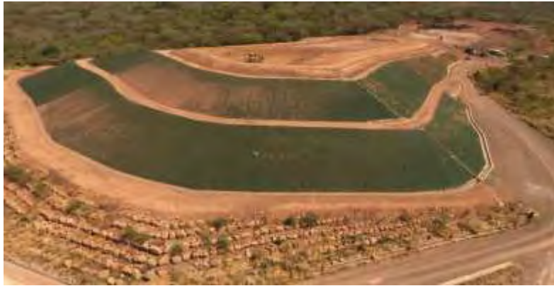
Figura 116. Taludes recubiertos con Geo-manta en la escombrera 1.
