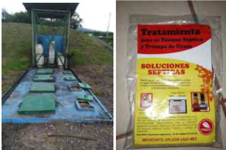
Figura 166. Bacterias descomponedoras y tanque desgrasador del comedor de proyectos.
