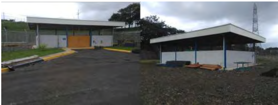
Figura 151. Vista exterior de la bodega de inflamables en su parte frontal y posterior.
