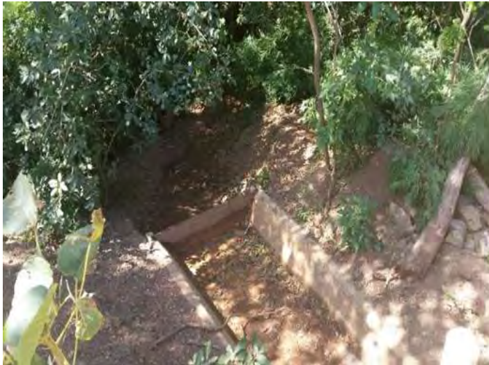
Figura 32. Sedimentador en el Proyecto Geotérmico Las Pailas II.
