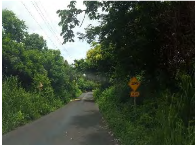
Figura 138. Reductor de velocidad, ruta de acceso Proyecto.
