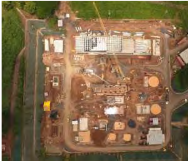
Figura 140. Avances de trabajos en el sitio de Casa de Máquinas.
