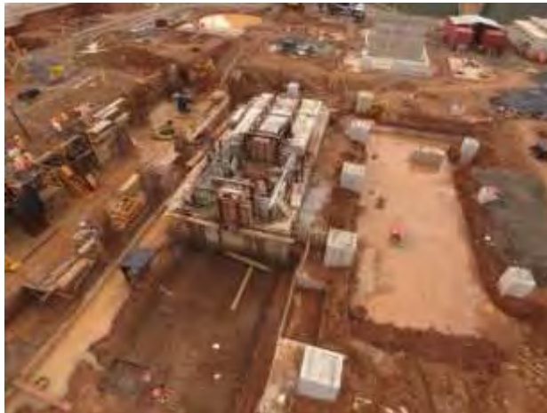
Figura 141. Avance en la cimentación del Turbogenerador.
