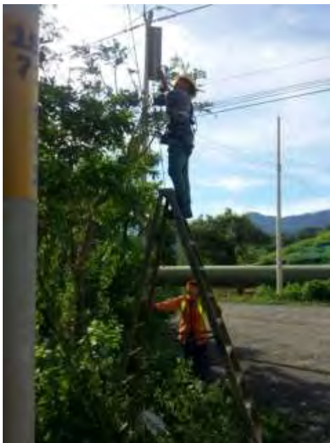
Figura 111. Colocación de láminas antiescalamiento.
