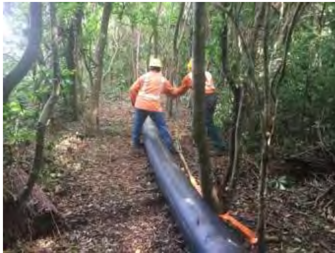
Figura 148. Colocación de tubería de PEAD.
