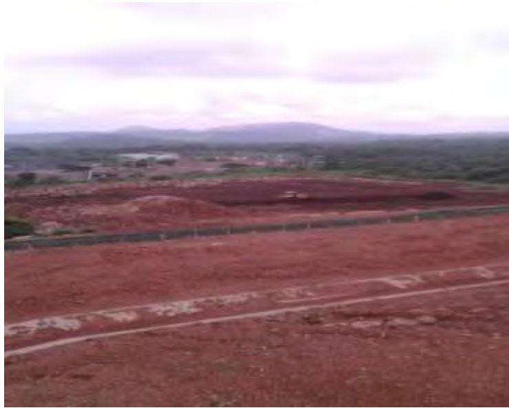
Figura 149. Escombrera Pailas I.
