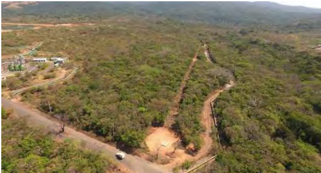
Figura 53. Foto área de la servidumbre de la Línea de Transmisión del Proyecto Geotérmico Pailas Unidad II.
