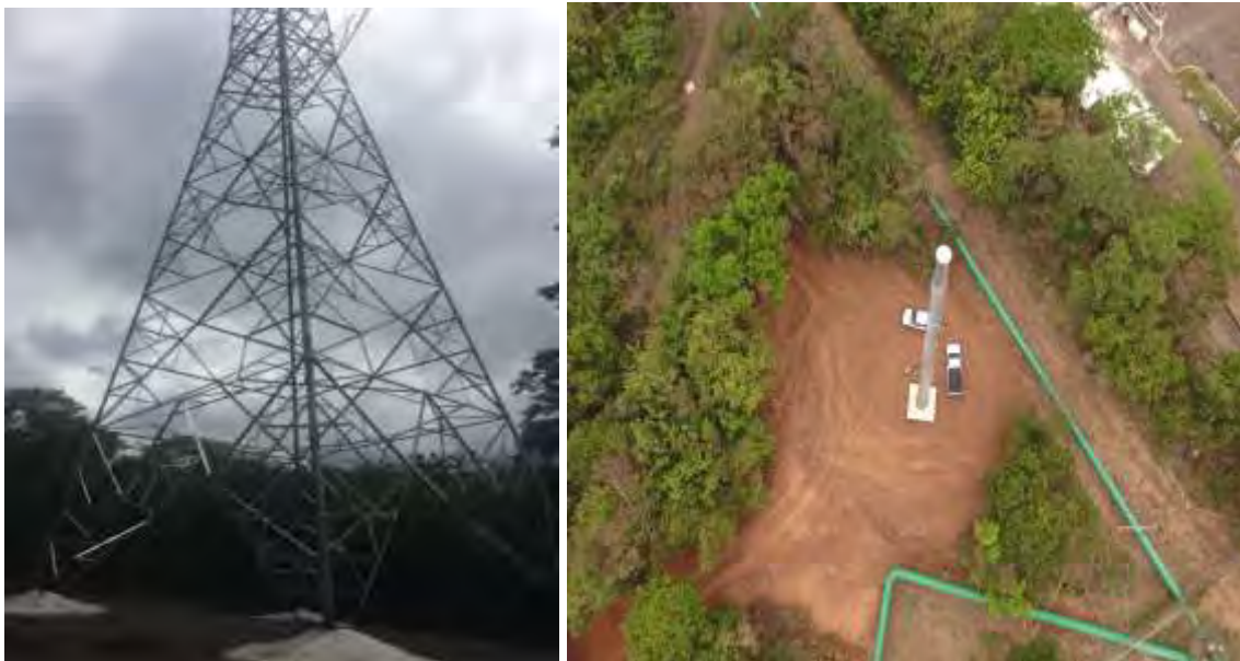
Figura 150. Armado de Torres y armado de postes.
