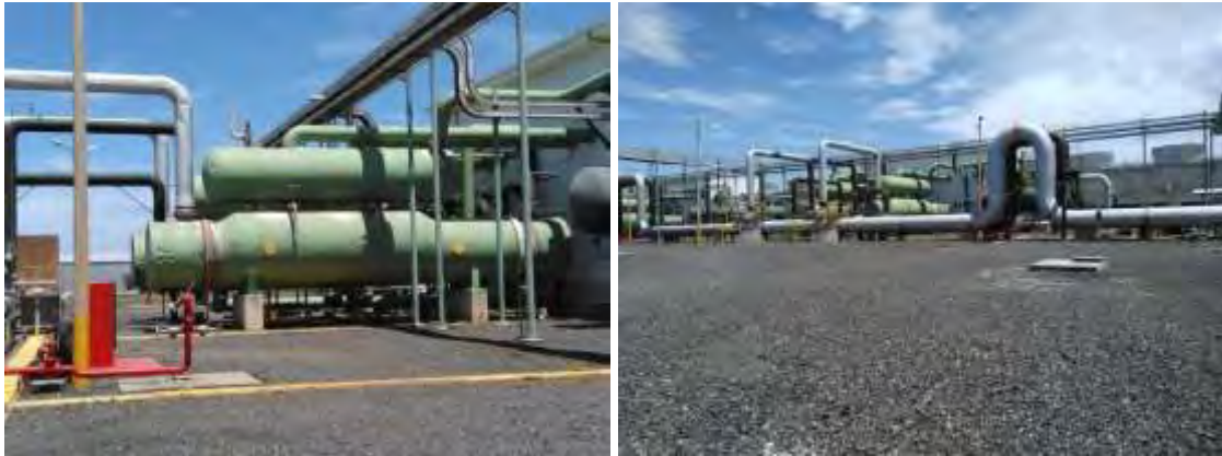
Figura 173. Estado de cubiertas aislantes de precalentadores y vaporizadores.
