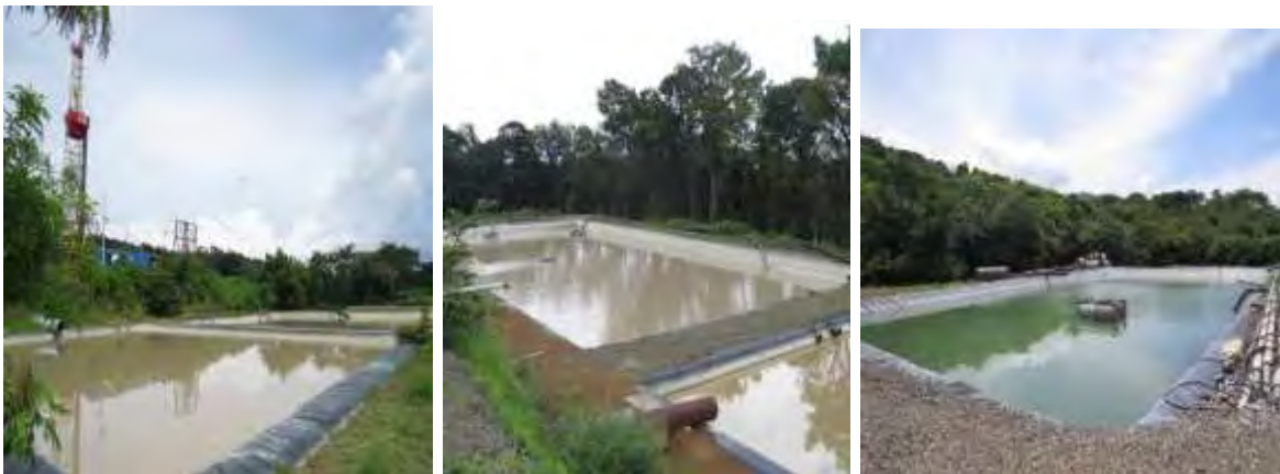
Figura 23. Lagunas almacenamiento de fluidos geotérmicos y de perforación en PLP-11, PLP-12 y PLP-13
