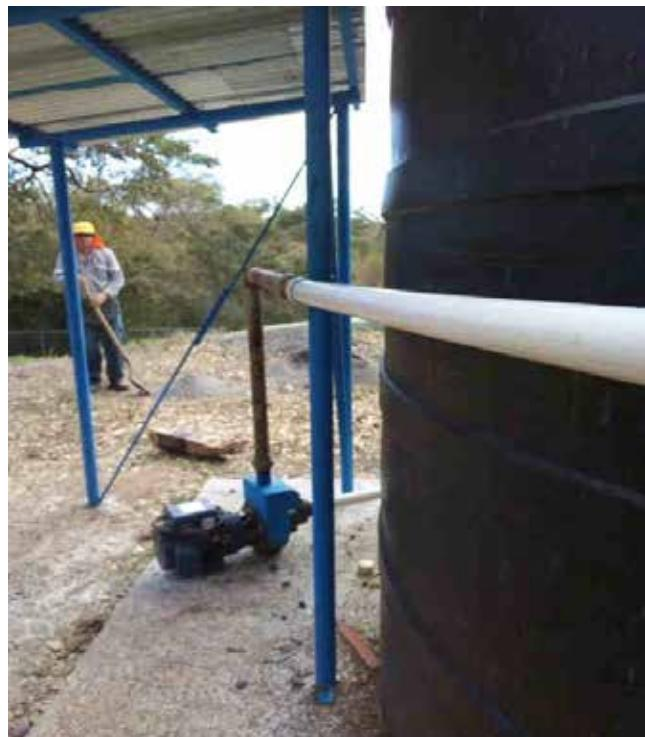
**Figura 96.** Instalación de tubería para reutilización de aguas residuales.
