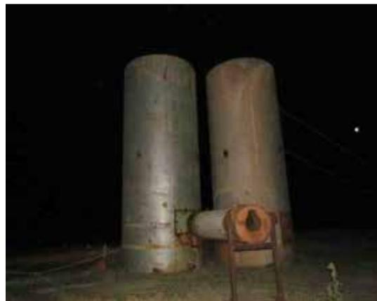
**Figura 25.** Sistemas con silenciadores en pozos Borinquen.
