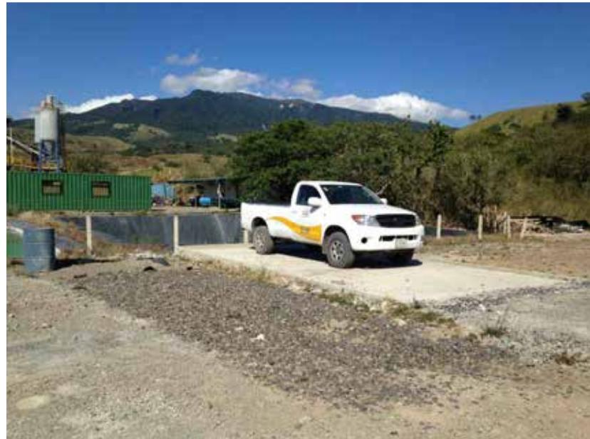
**Figura 34.** Losa para el mantenimiento de maquinaria.
