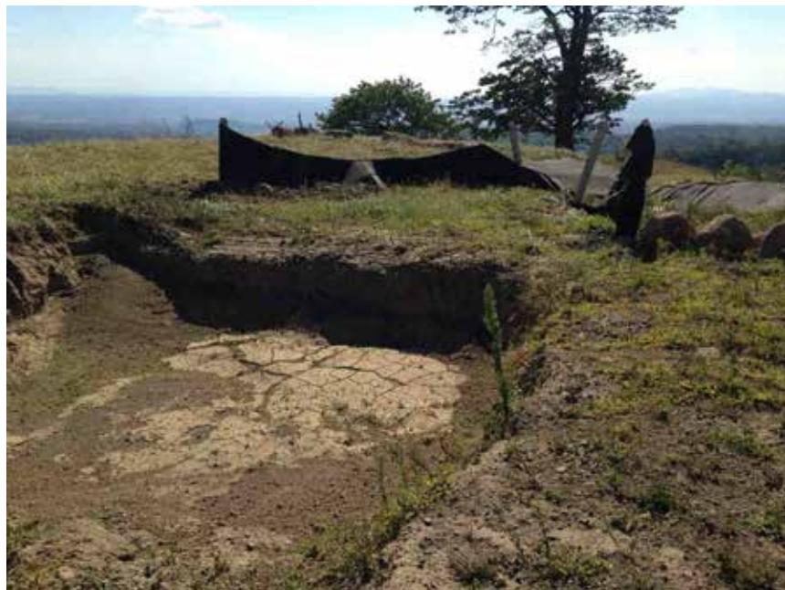
**Figura 28.** Sedimentador construido para manejo de aguas de la PL-05.
