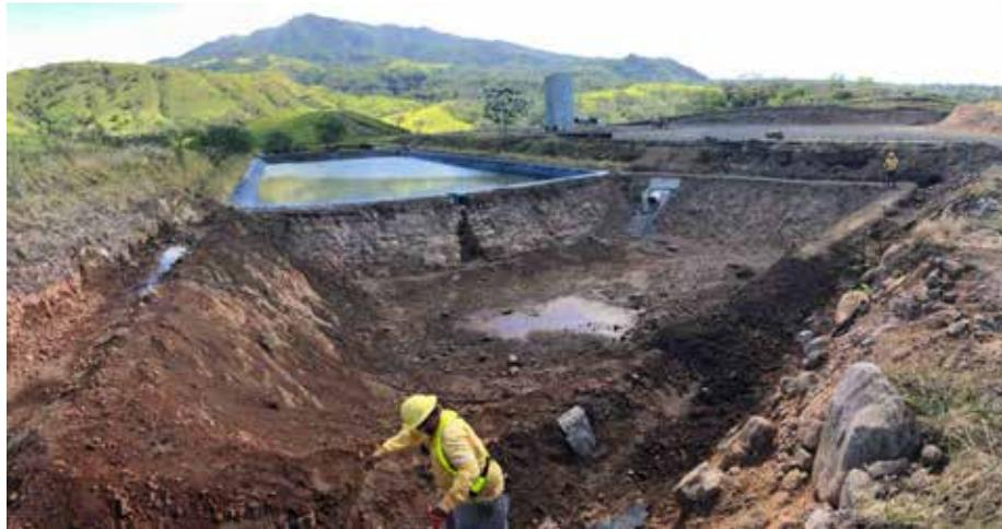
**Figura 124.**Conformación de taludes en fosa de la PL-02.
