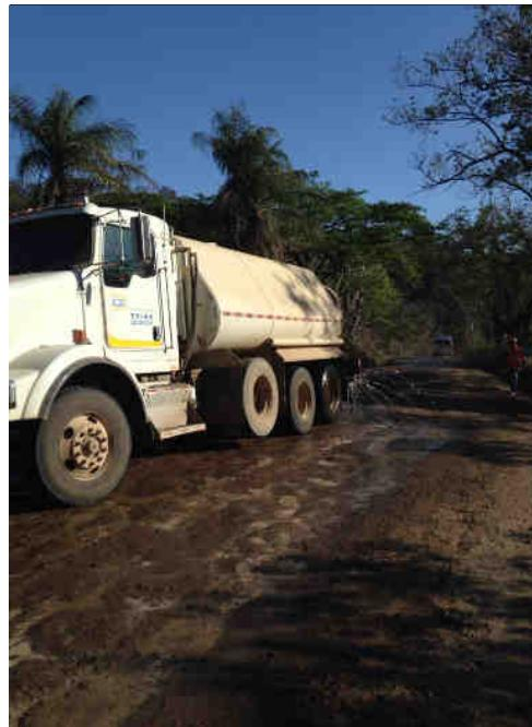
**Figura 19.** Riego de camino y obras para la reducción del polvo.
