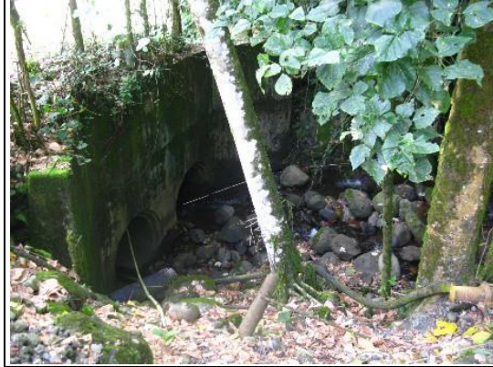
Photo 158: I-16 I-17 Quebrada Tres Amigos
