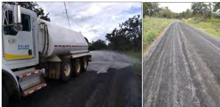
**Figura 12.** Cisterna para el control de polvo producido por el paso de maquinaria.
