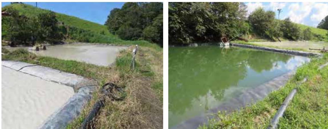
**Figura 23.** Lagunas impermeabilizadas en PLB-9.
