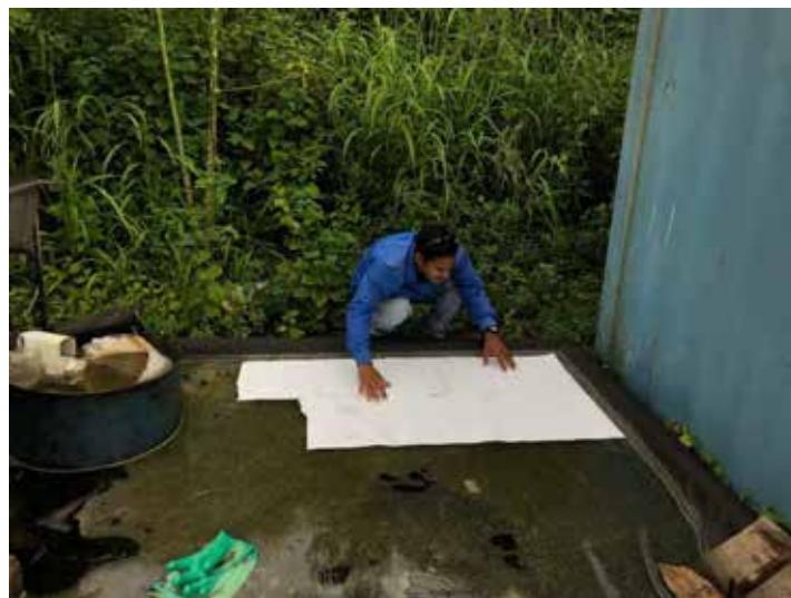
**Figura 25.** Limpieza de hidrocarburos sobre losa.
