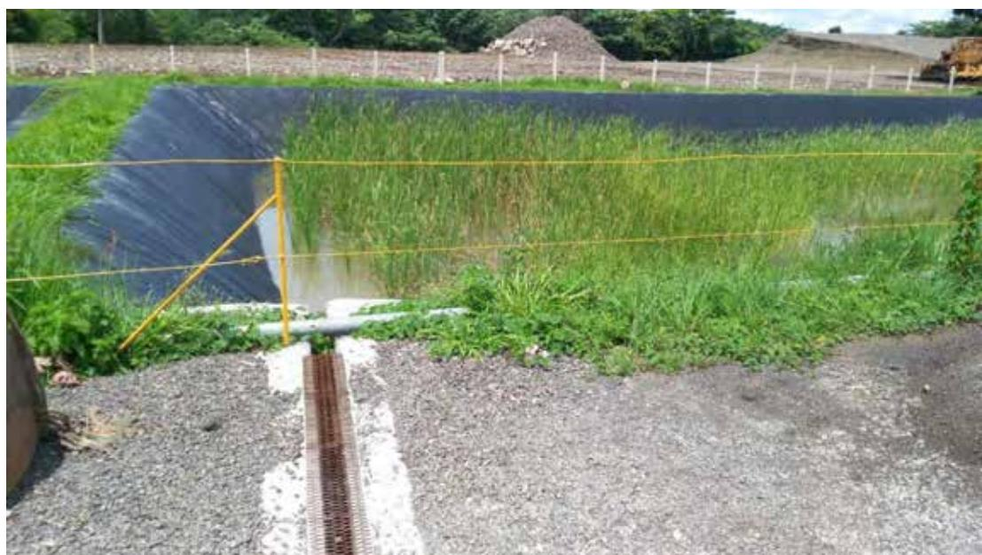
**Figura 34.** Lagunas para el manejo de agua residuales de la planta de concreto.
