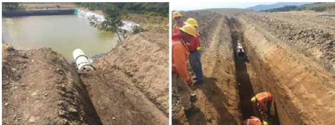
**Figura 92.** Colocación de tuberías de los pozos a las fosas.
