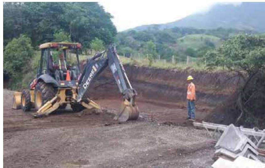
**Figura 94.** Ampliación de plazoleta 09 para la construcción de contrapozo.
