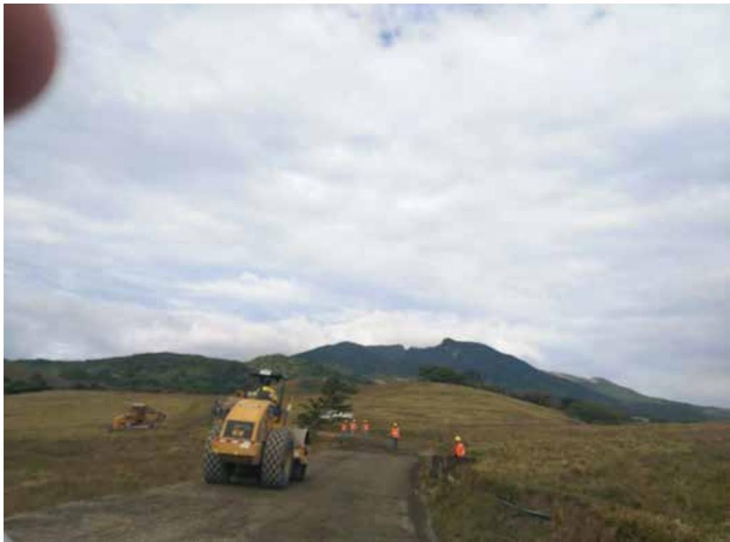
Reparación de camino interno principal. Colocación de capa de rodamiento con sistema RCC. Abril 2017.
