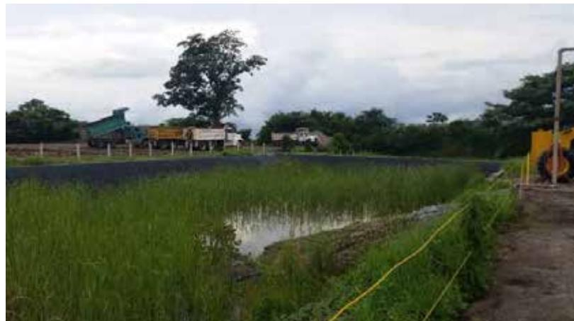
**Figura 23.** Laguna para vertido de aguas con sedimentos de la Planta de Concreto.
