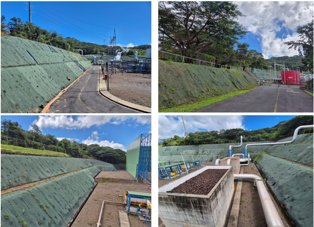
Figura 65 Taludes y estado de geomembrana en Unidad II PG Las Pailas
