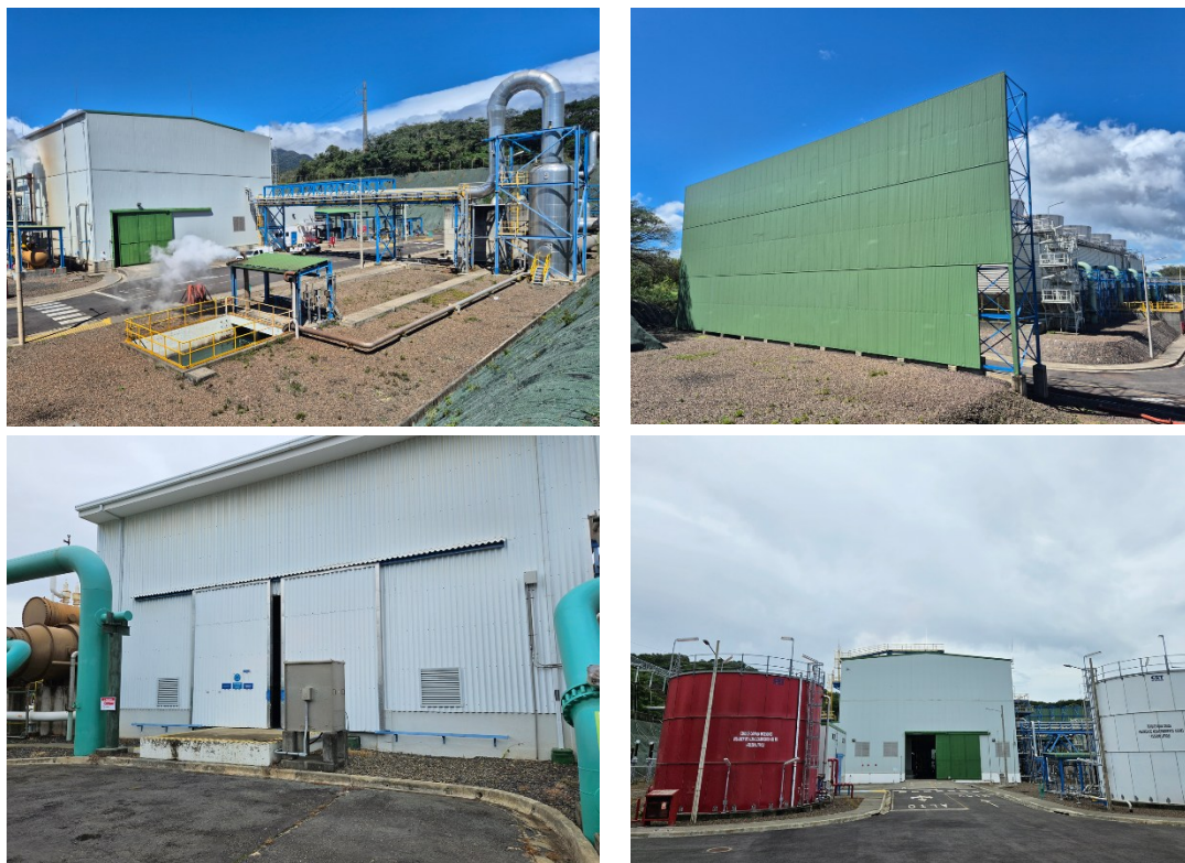
Figura 28 Casas de máquinas de Unidades I y II con puertas cerradas y pantalla sónica en Unidad II
