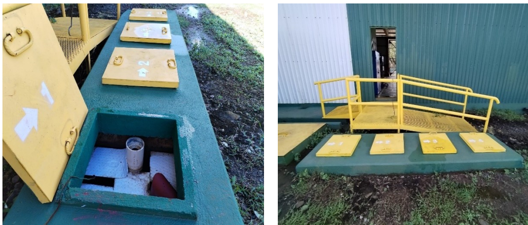
Figura 15 Trampas para aguas oleaginosas de talleres del campo geotérmico
