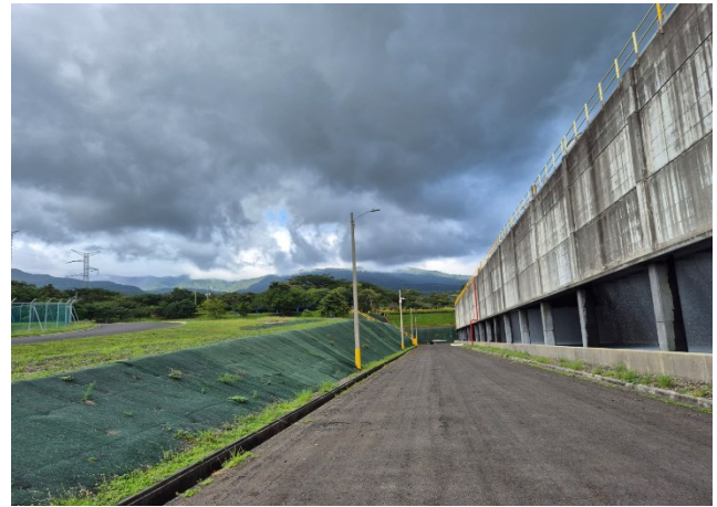
Figura 66 Taludes y estado de geomembrana en Unidad I PG Las Pailas
