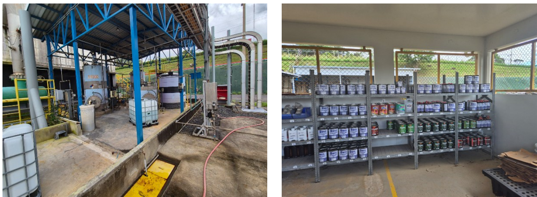
Figura 17 Ejemplos de zonas de almacenamiento para sustancias peligrosas
