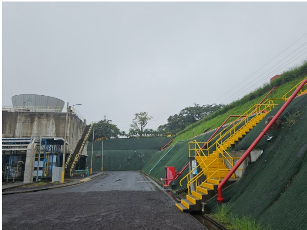
Figura 66 Taludes y estado de geomembrana en Unidad I PG Las Pailas
