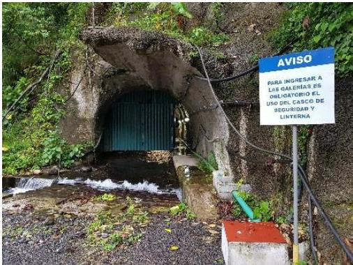
Foto 68: I-5 Galería de la presa y el flujo cerca del lado derecho de la presa adyacente al aliviadero.
