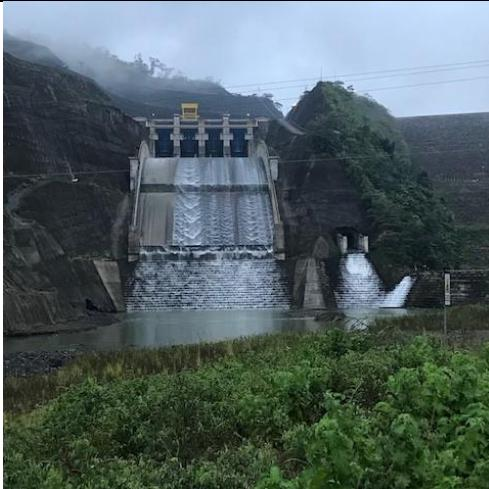
Foto 181: I-20 Vista del aliviadero aguas abajo, con salida inferior a la derecha.
