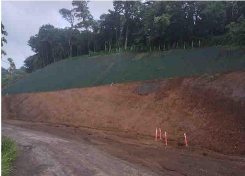
**Figura 67.** Geomanto colocado en taludes de la Ruta Norte.
