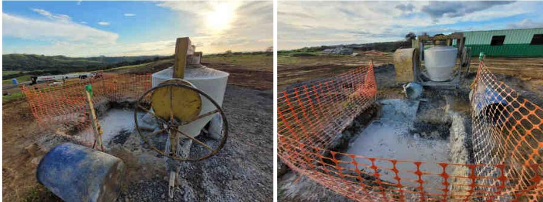
**Figura 68.** Fosa para la sedimentación de aguas residuales con concreto.
