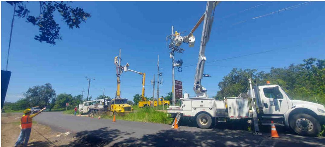
**Figura 198.** Proceso constructivo de la obra Línea de Distribución Eléctrica LD.
