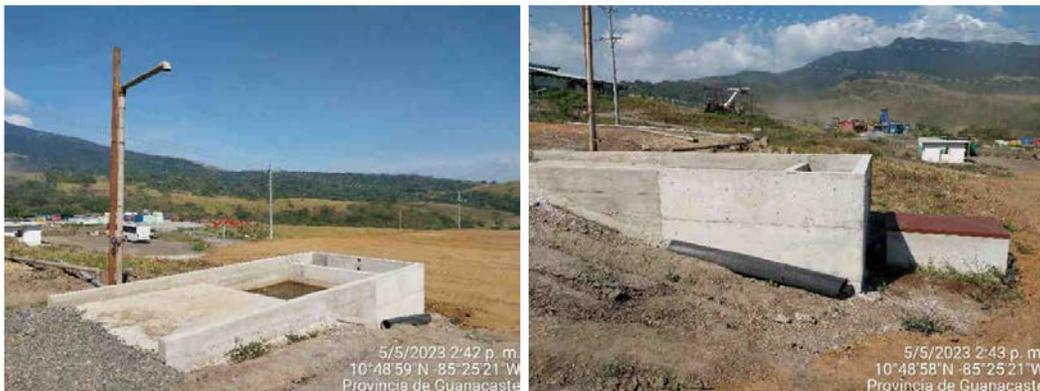
**Figura 69.** Sedimentador y trampa de grasas y aceites de la planta de concreto.
