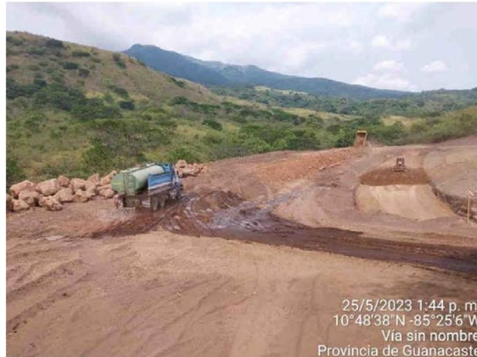
**Figura 18.** Irrigación de agua en frentes de trabajo internos del proyecto para mitigación de polvo.
