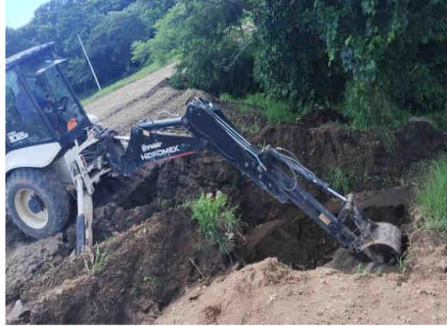
**Figura 29.** Limpieza de sedimentadores de la Escombrera 02.
