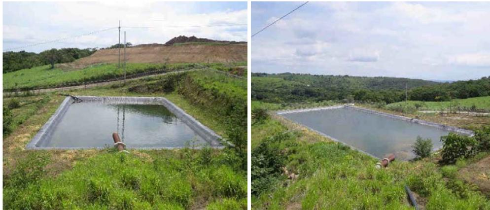
Figura 40. Lagunas impermeabilizadas en PLB-08.
