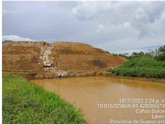
**Figura 31.** Sedimentador con filtro de roca en Escombrera 01.
