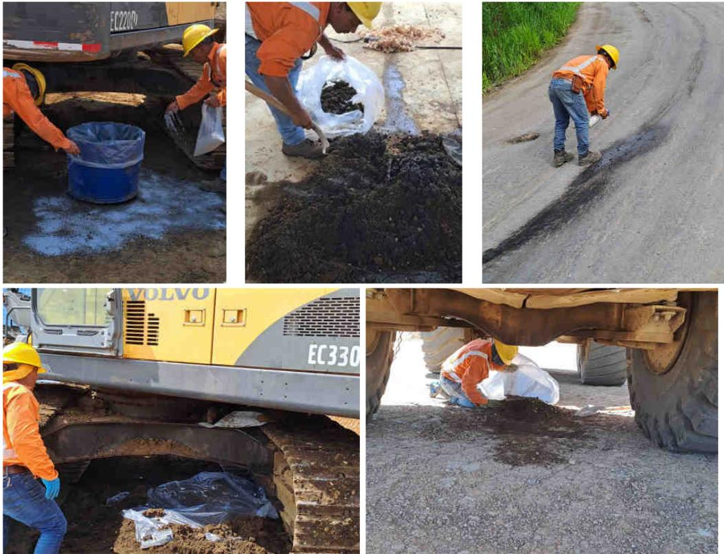
**Figura 35.** Acciones de atención de derrames de hidrocarburos.
