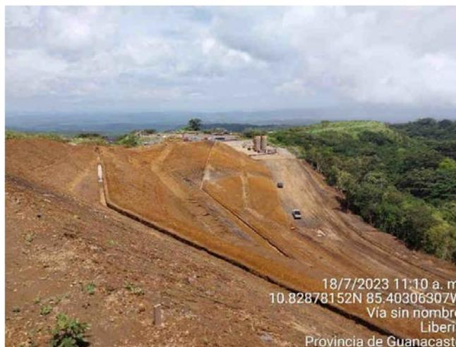
**Figura 28.** Canales en taludes para manejo de aguas y sedimentos.
