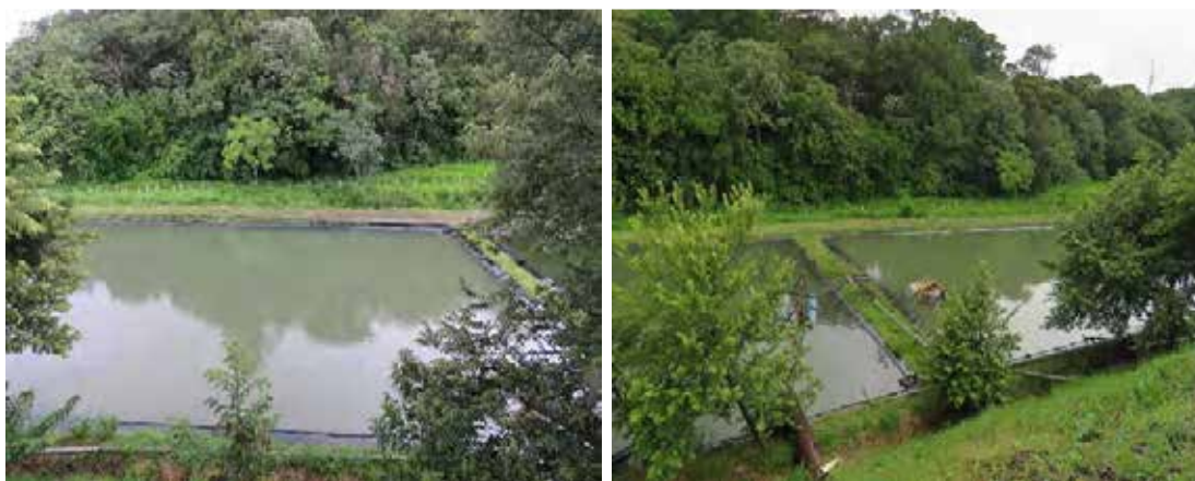
Figura 32. Lagunas impermeabilizadas en PLB-9.
