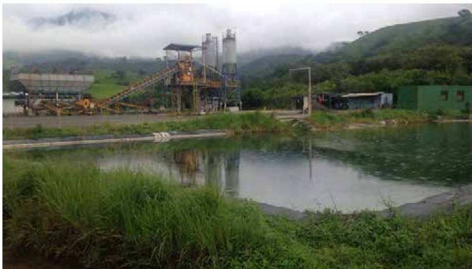
Figura 33. Laguna para vertido de aguas con sedimentos de la Planta de Concreto.
