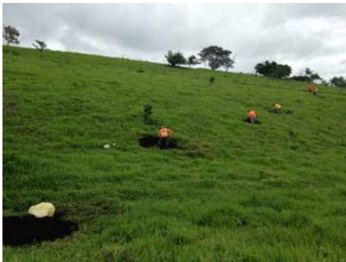
Figura 104. Excavación de pozos de sondeo sobre trazado del Vaporducto.
