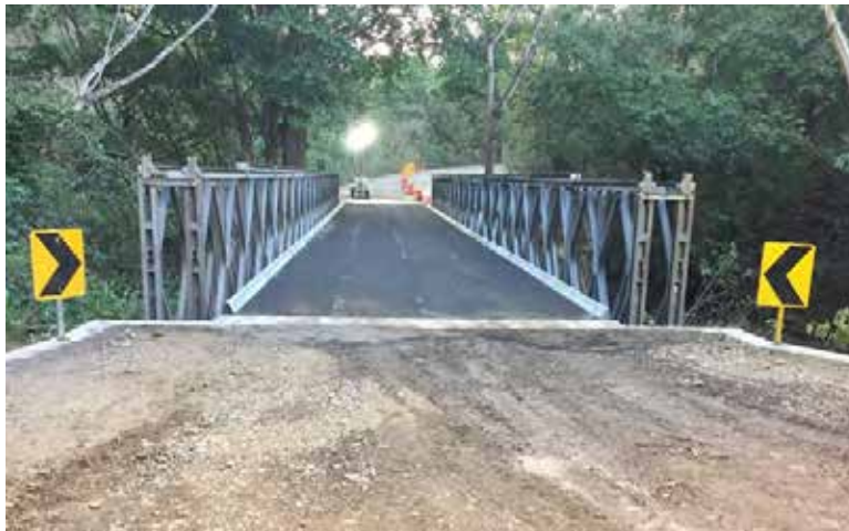
Figura 121. Construcción de puente Bailey sobre Río Tizate.
