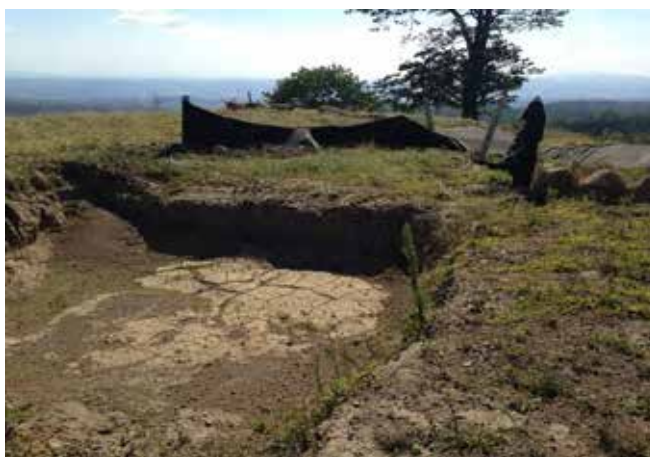
Figura 25. Sedimentador construido para manejo de aguas de la PLB-05.
