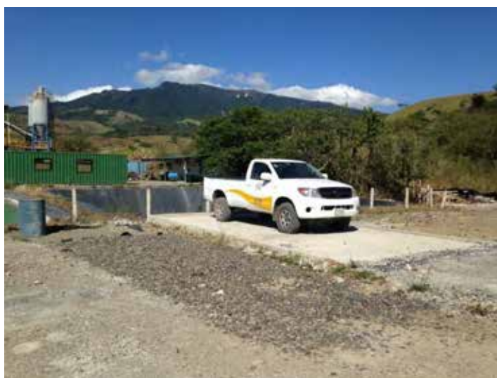
Figura 31. Losa para el mantenimiento de maquinaria.
