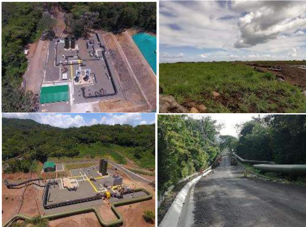
Figura 135. Obras de campo donde se retiraron las instalaciones provisionales.
