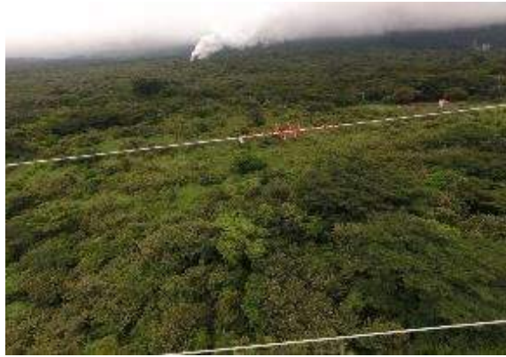
Figura 93. Dispersores para aves instalados en LT, Proyecto Geotérmico Las Pailas Unidad II.
