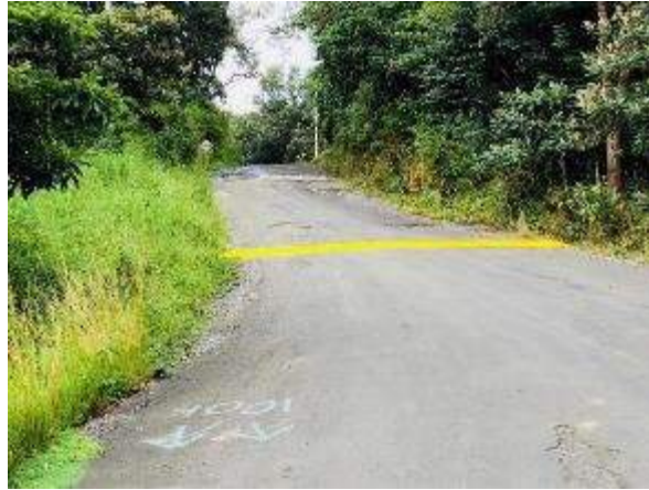
Figura 68. Reductor de velocidad. Proyecto Geotérmico Las Pailas Unidad II.
