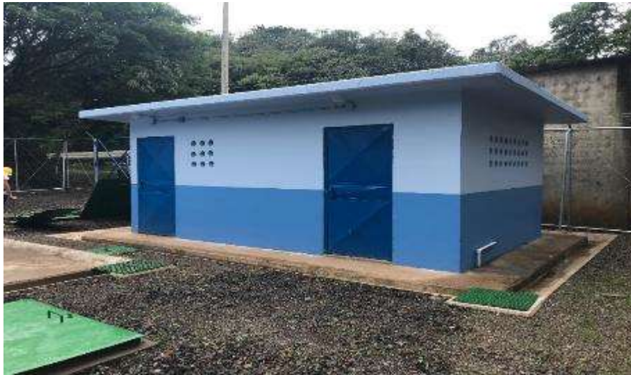
Figura 138. Caseta de cloración.
