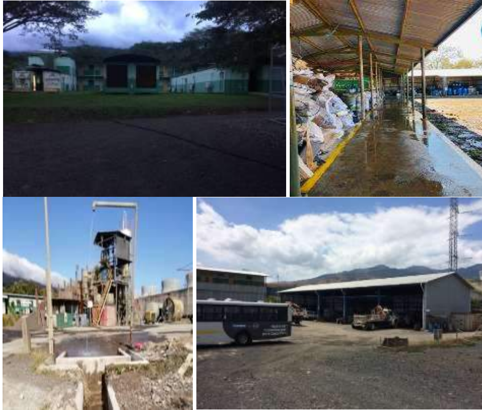
Figura 136. Instalaciones que se mantiene oficinas Pailas II, centro de acopio, planta de concreto y talleres.
