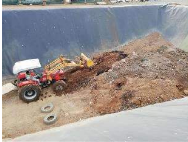
Figura 91. Vertido de residuos orgánicos en el Relleno Sanitario del Proyecto Geotérmico Pailas.
