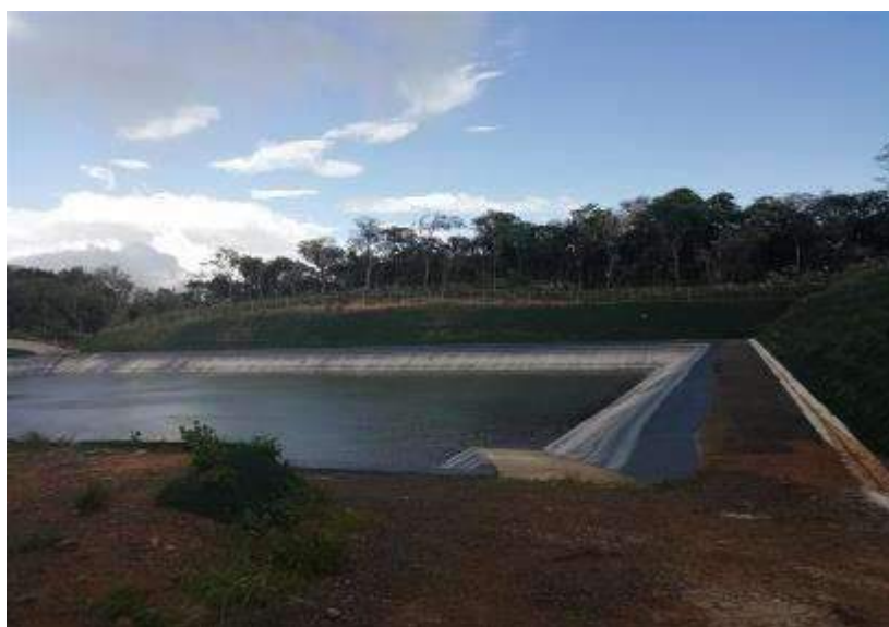
Figura 40. Taludes de la Laguna 3.
