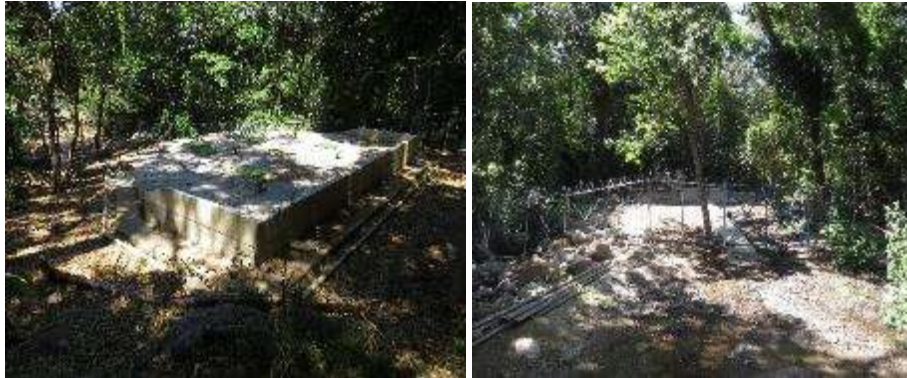
Figura 99. Toma de captación, II Trimestre, 2019.
