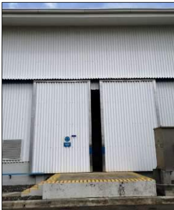
Figura 129. Puertas de entrada a Unidad I cerradas parcialmente.
