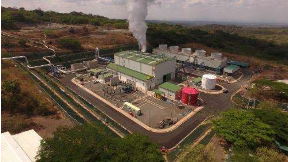
Figura 130. Avance general de Casa de Máquinas.
