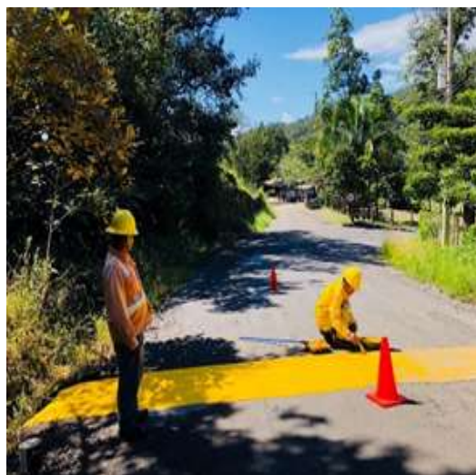
Figura 115. Reductor de velocidad, Santa María.
