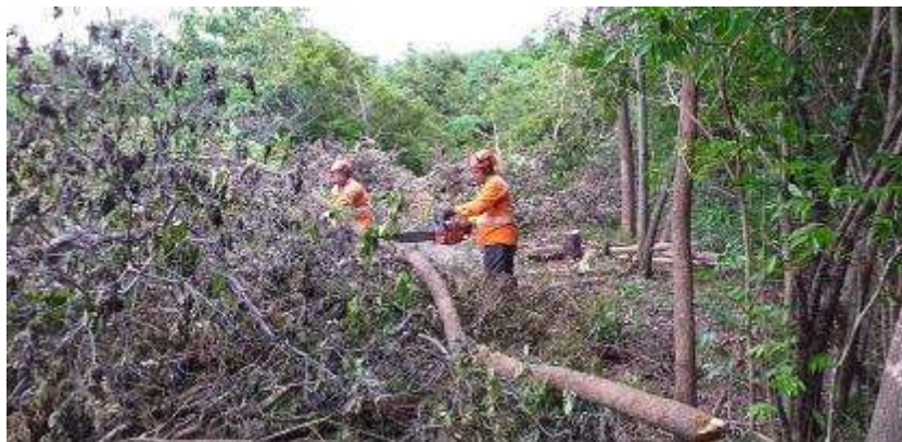
Figura 46. Corta de árboles para la construcción de la Urbanización del Centro de Servicios Recursos Geotérmicos.
