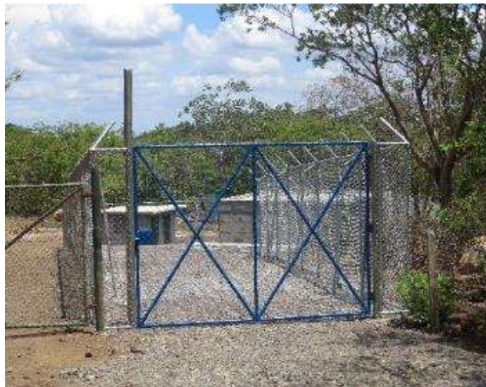
Figura 100. Tanque de almacenamiento Curubandé, II Trimestre, 2019.
