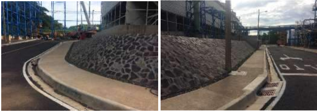
Figura 120. Empedrado de taludes internos de la Casa de Máquinas.
