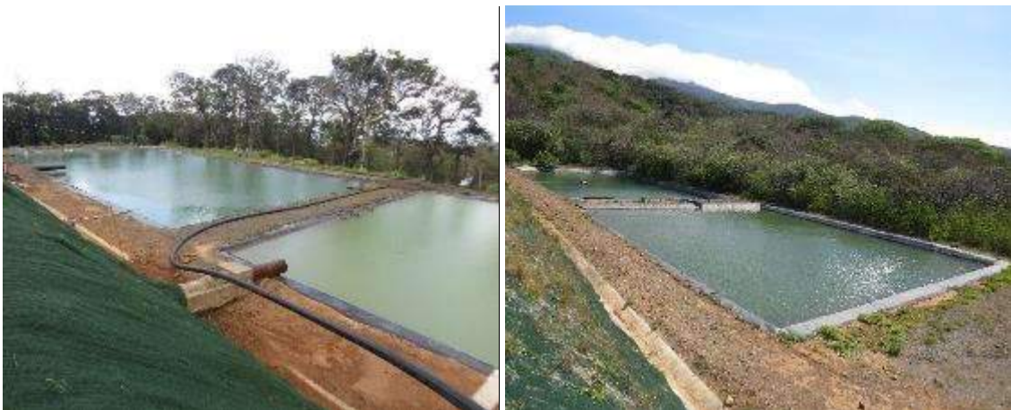
Figura 23. Lagunas almacenamiento de fluidos geotérmicos y de perforación en PGP-62.
