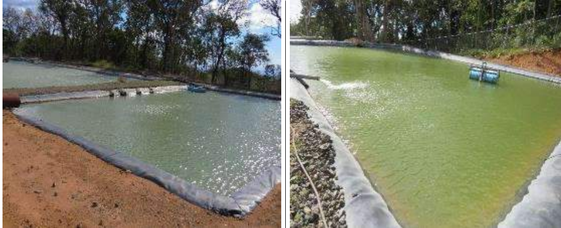
Figura 22. Lagunas almacenamiento de fluidos geotérmicos y de perforación en PGP-53.
