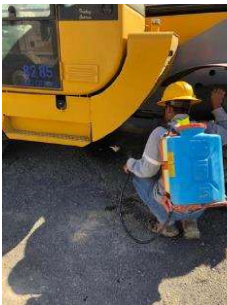
Figura 37. Aplicación de biorremediador sobre derrames de hidrocarburos.
