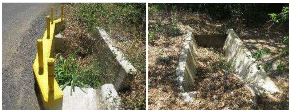
Figura 54. Inspección de sedimentadores en mayo 2019.
