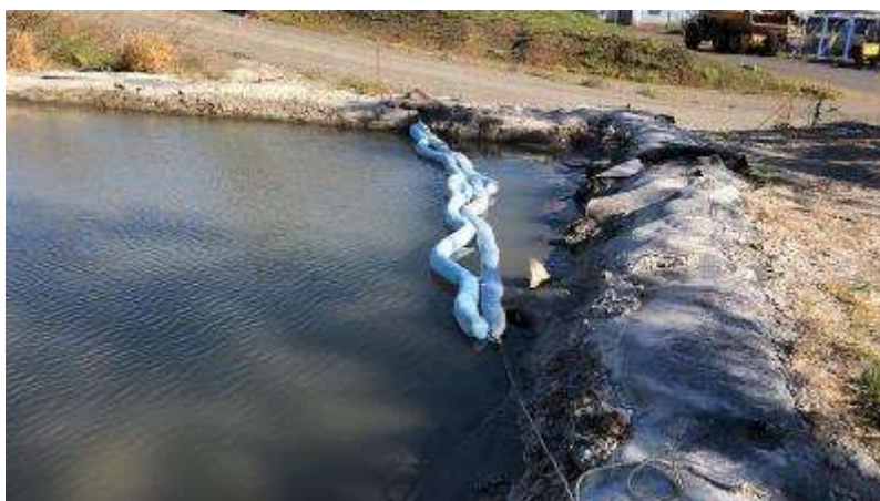
Figura 38. Colocación de barreras de contención de derrames sobre la laguna de sedimentación de Planta de Concreto.
