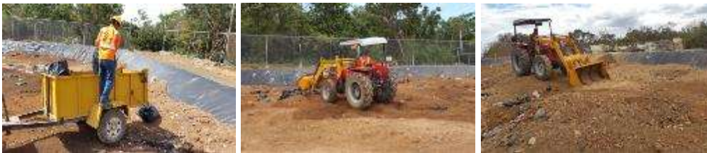
Figura 93. Vertido, cobertura y compactación de los residuos sólidos orgánicos.
