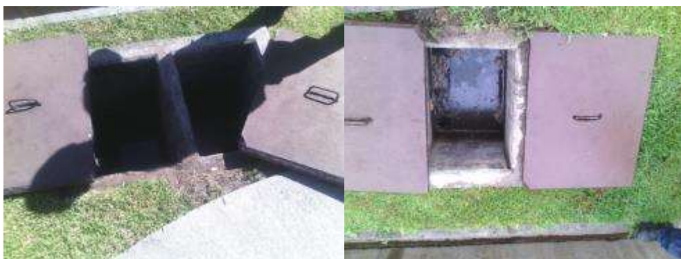
Vista del separador de grasa del taller, hay que limpiarlo 9/6/2015
