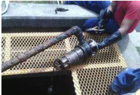
Limpiando la bomba del sedimentador
