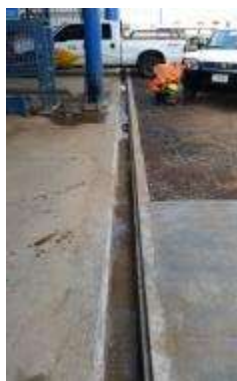
Figura 38. Construcción de la canaleta para recolección de aguas con aceite en el Taller Mecánico.
