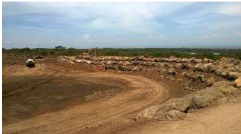
Figura 126. Construcción Dique y conformación de la escombrera 1.
