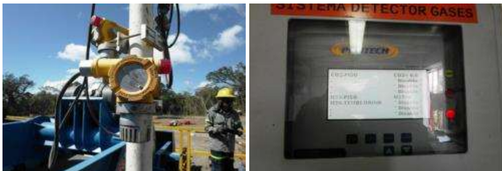
Figura 12. Alarmas audibles instaladas.
