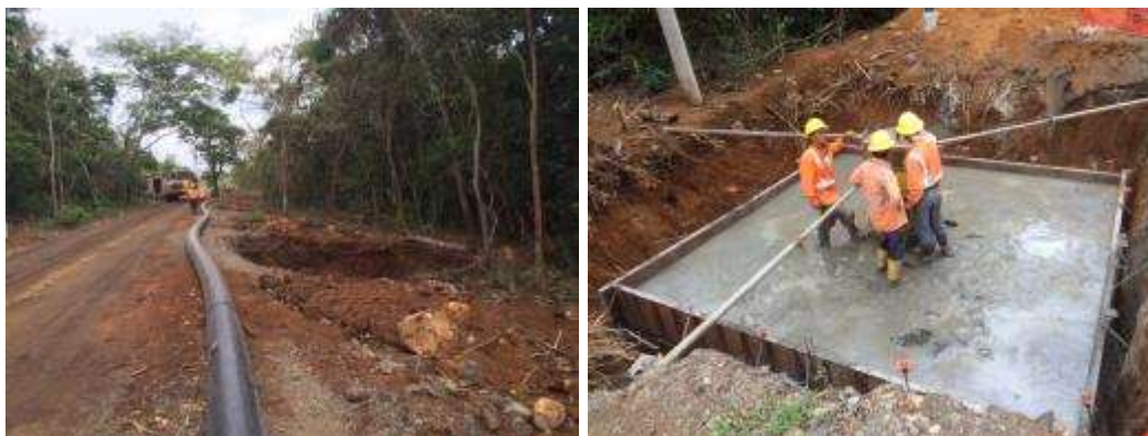
Figura 40. Trabajos de preparación de pedestales en las rutas de tuberías.
