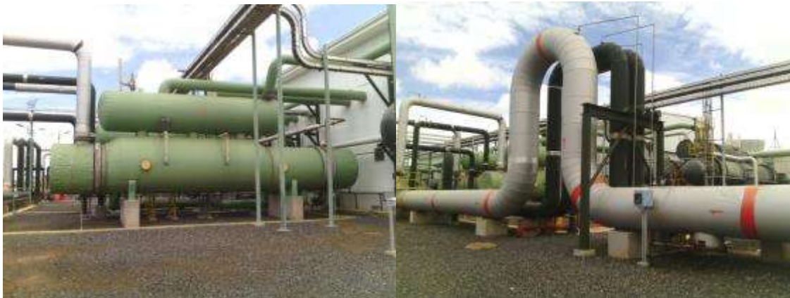
Tuberías recubiertas con forros aislantes térmicos
