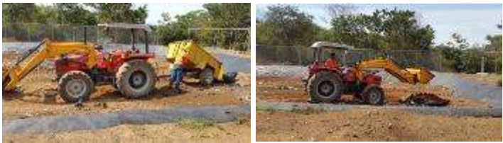
Figura 34. Cobertura de residuos vertidos en Relleno Sanitario.
