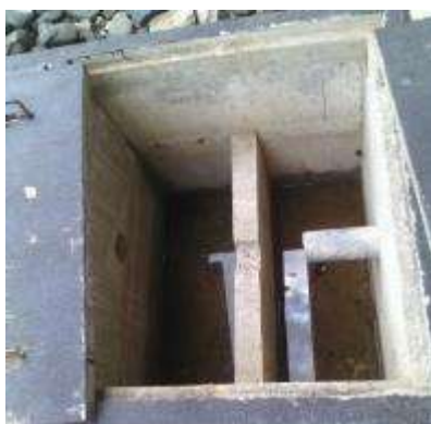
9/6/15, Sistema de contención de derrames de bodega de inflamables.
