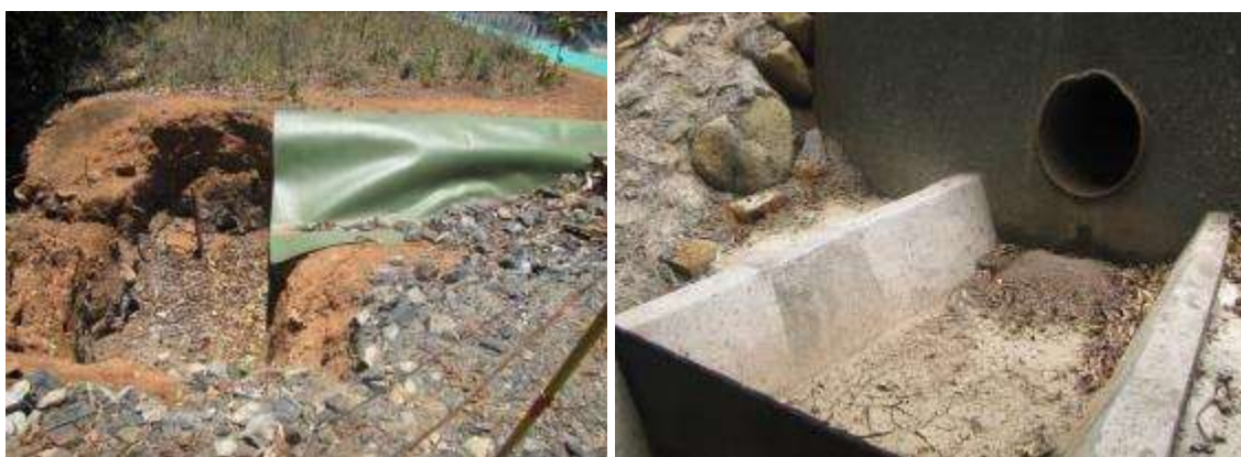
Figura 26. Estructuras para reducir la velocidad del agua PL-16 y camino a PL-12.
