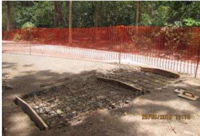
Figura 76. Construcción de reductor de velocidad.
