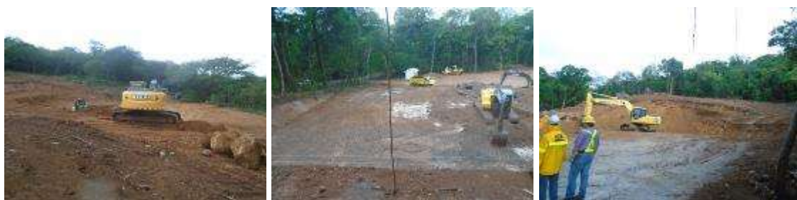
Figura 39. Trabajos de conformación del terreno en los sitios de ubicación de obras de los satélites N° 2, N° 3 y N° 4, respectivamente. Los taludes se protegerán de la erosión con eco-matrix.
