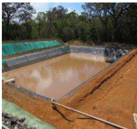
Figura 22. Lagunas utilizadas para el manejo de fluidos geotérmicos y de perforación.
