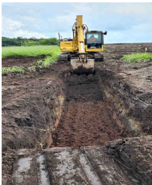
Figura 134. Monitoreo de trincheras utilizadas como sedimentadores para drenar el agua pluvial CM.
