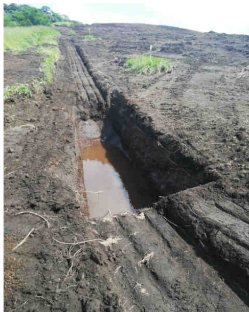
Sedimentadores superficiales en sitio de obra Casa de Máquinas.
