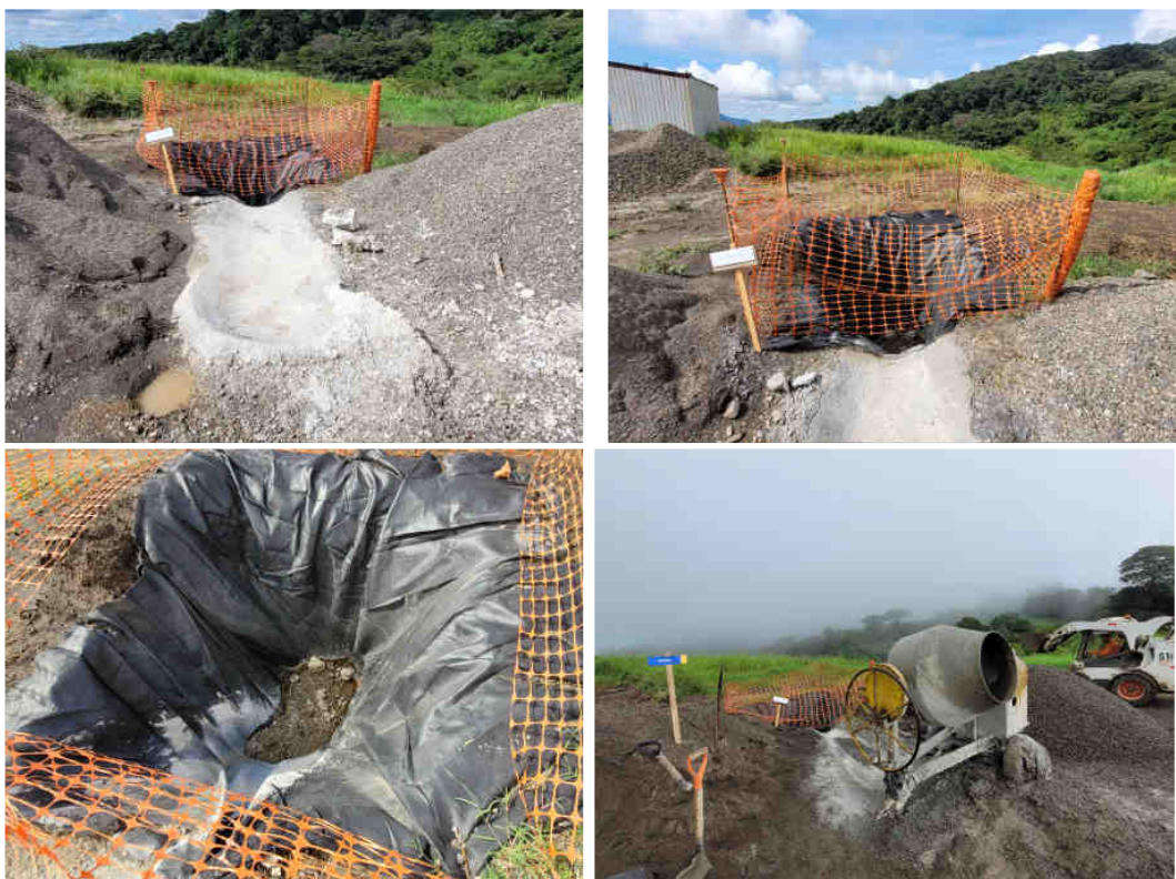
Figura 67. Fosa para la sedimentación de aguas residuales con concreto.
