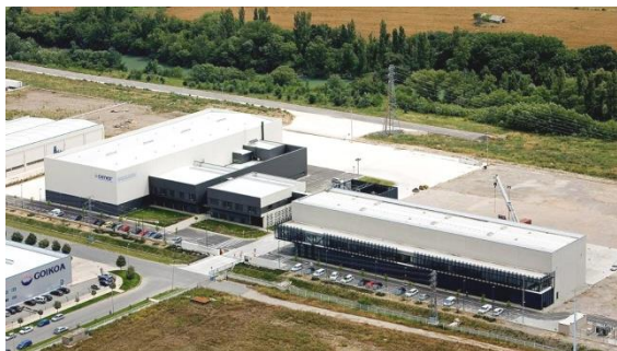
Laboratorio de Ensayo de Aerogeneradores Sangüesa
