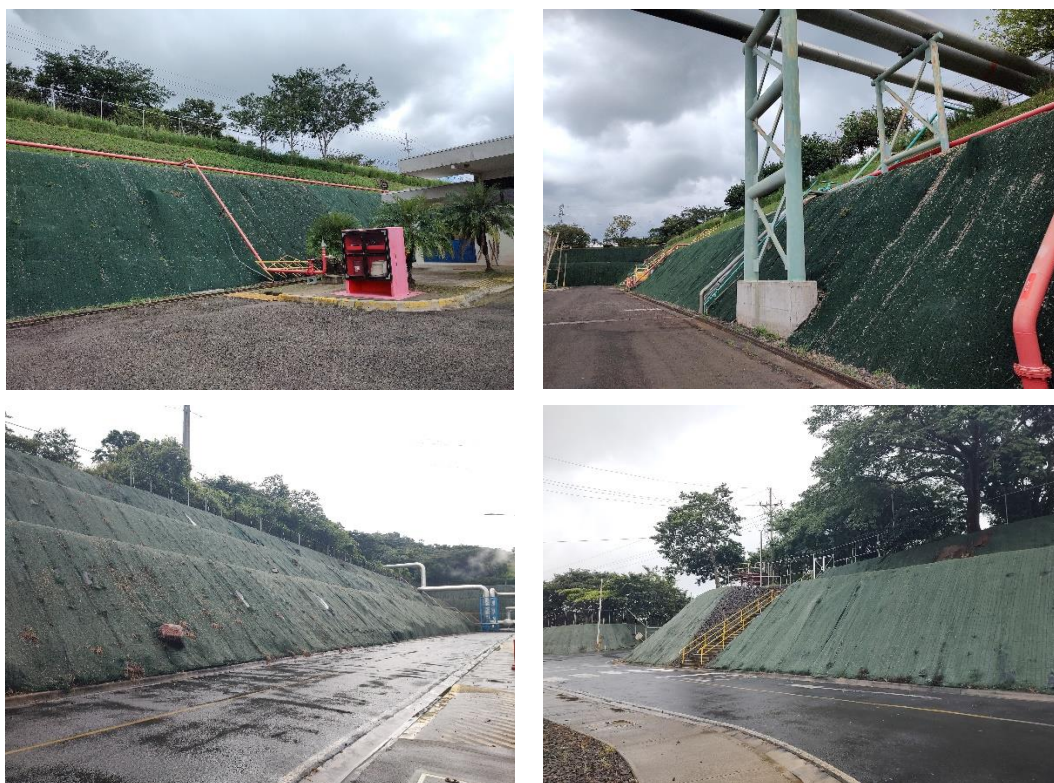
Figura 57 Taludes y estado de geomembrana en Planta
