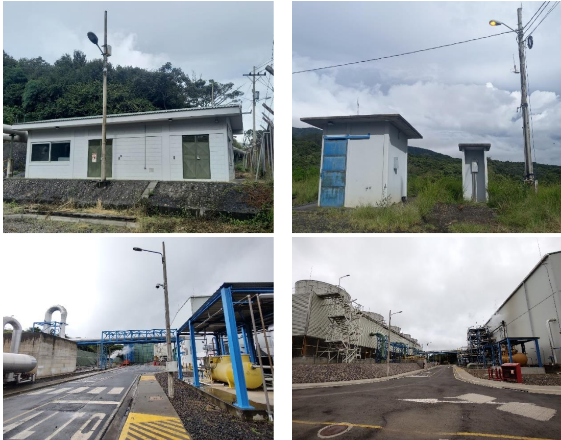
Figura 25. Iluminación en obras del Campo y Planta Geotérmica
