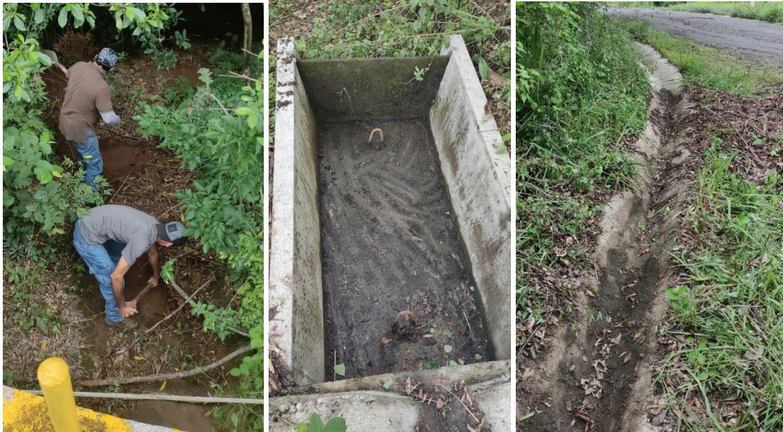
Figura 34. Limpieza de sedimentadores durante inspección de sistemas de evacuación pluvial, julio 2023.
