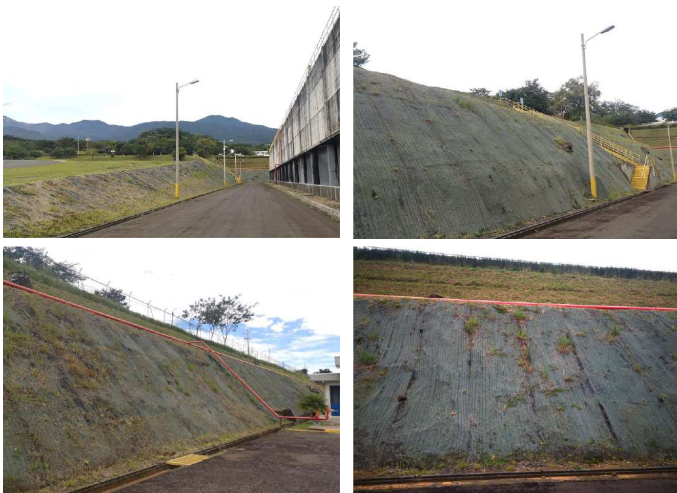
Figura 82 Estado estable y reparación de geomembrana de los taludes en Unidad I
