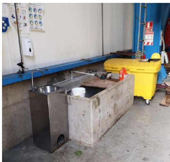
Figura 18 Pileta para lavado de equipos en Planta
