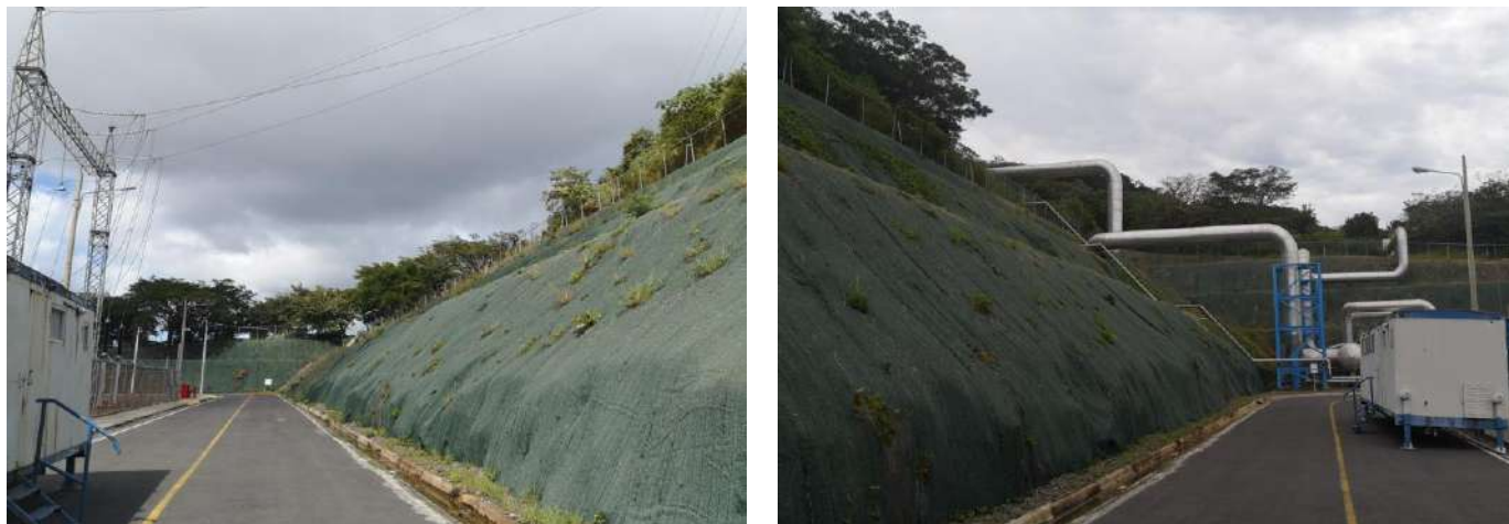
Figura 83 Estado estable de los taludes en Unidad II
