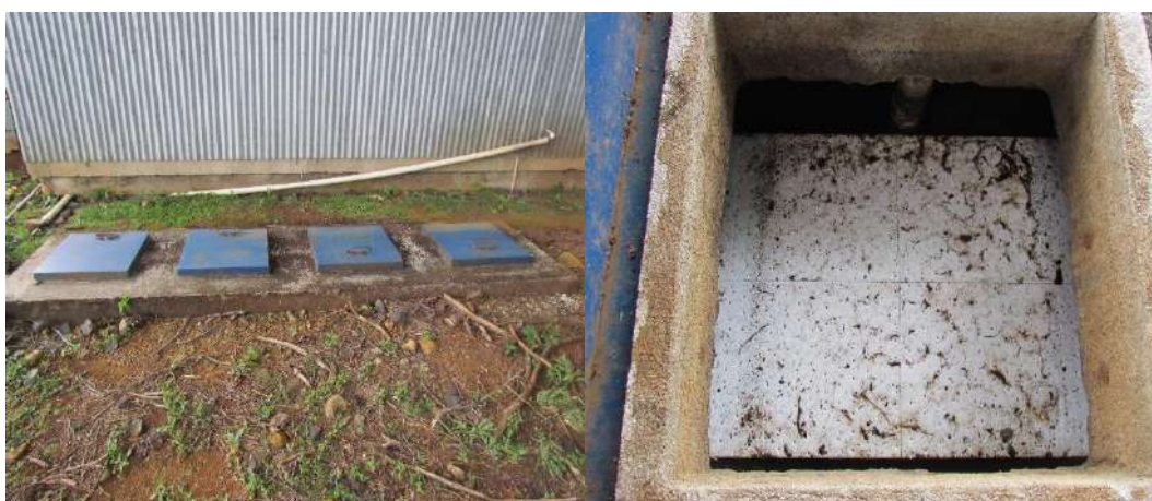
Figura 20. Trampas para aguas oleaginosas de talleres del CG Pailas.
