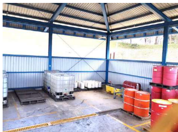
Almacenes de sustancias peligrosas con sistemas de contención antiderrames y direccionadas a tanque de neutralización
