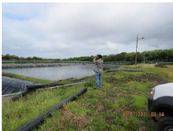
Figura 76. Revisión de sistemas de impermeabilización de las lagunas. II Semestre 2021.
