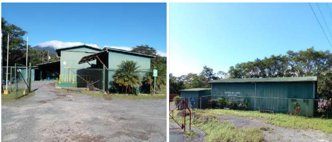
Figura 8. Instalaciones de CTR de C.S. Recursos Geotérmicos
