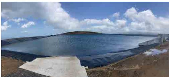
**Figura 147.** Construcción de Laguna de agua de trabajo (LGB-05).
