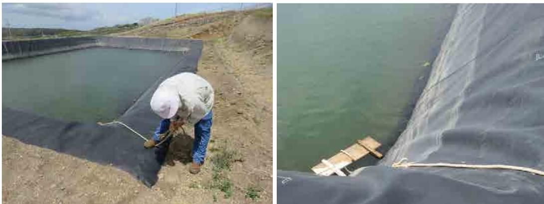
**Figura 98.** Dispositivos para rescate de fauna en lagunas, Proyecto Geotérmico Borinquen.
