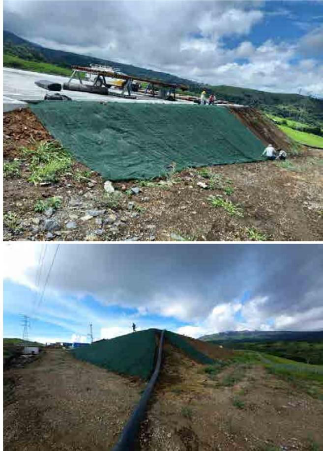
**Figura 57.** Colocación de geomanto en la plazoleta PLB-08.
