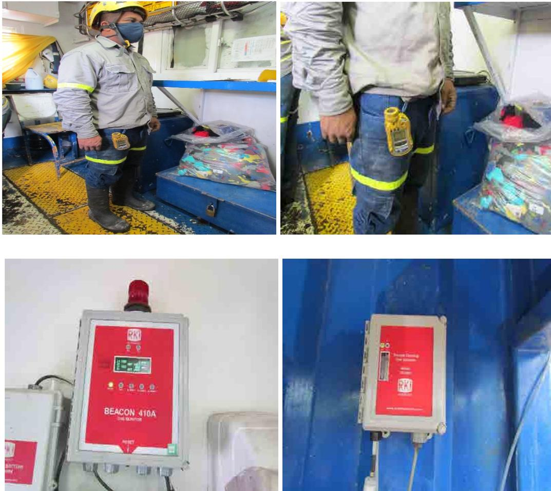
**Figura 15.** Detectores de gases utilizados en pruebas de producción y labores de perforación de pozos profundos.
