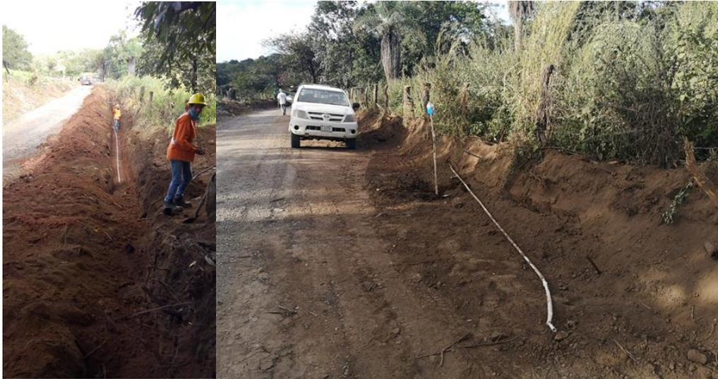
**Figura 133.** Reparación de tubería en los trabajos de la LD.
