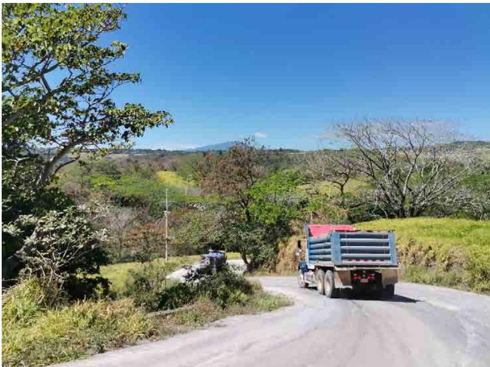
**Figura 22.** Uso de lona de vagonetas tándem para el traslado de agregados para evitar generar partículas de polvo.
