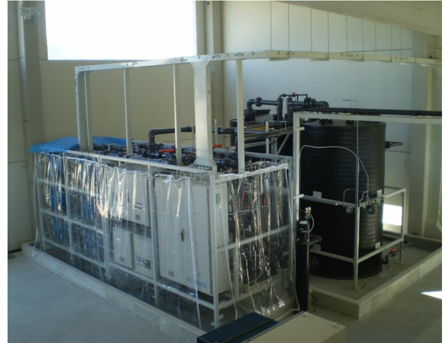
S- Batería de flujo, 50 kW x 4 horas
