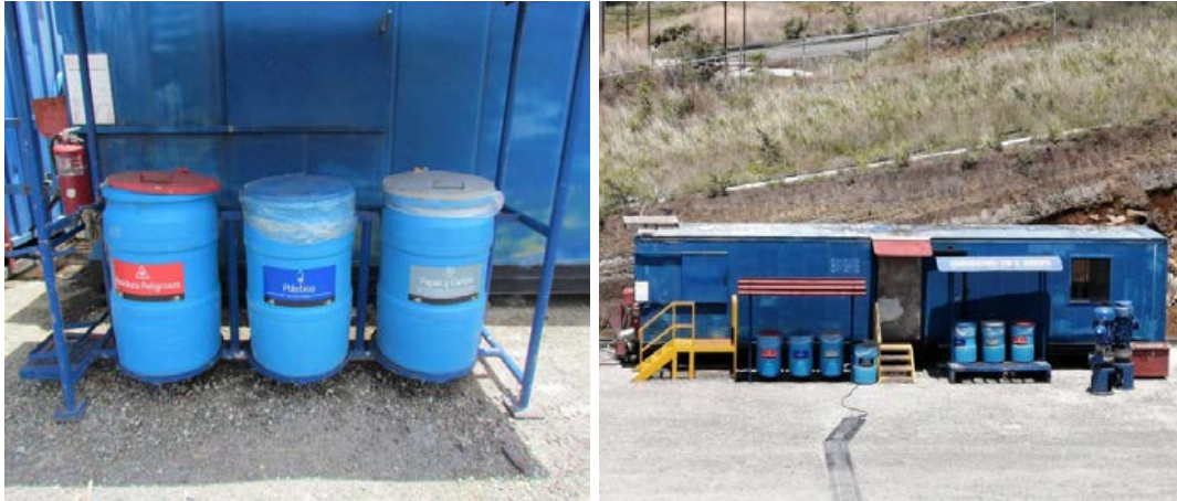
Figura 26: Áreas utilizadas para almacenamiento temporal de residuos peligrosos.
