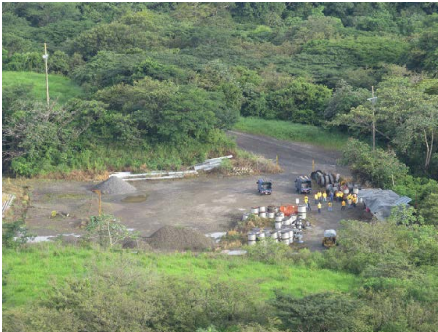
Vista panorámica del sitio de obra Plazoleta PLB-03. Julio 2022.
