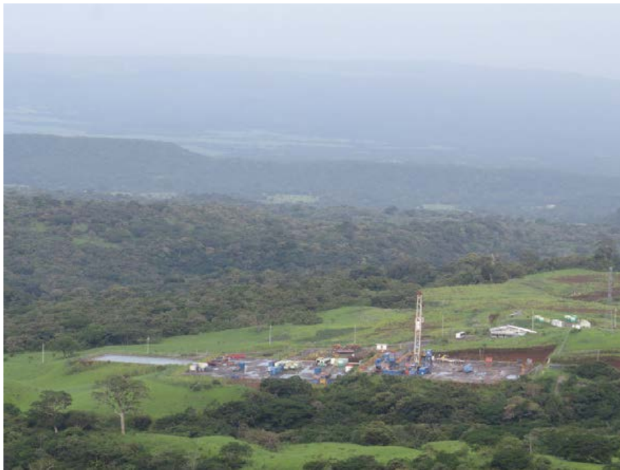
Vista panorámica del sitio de obra Plazoleta PLB-08. Julio 2022.
