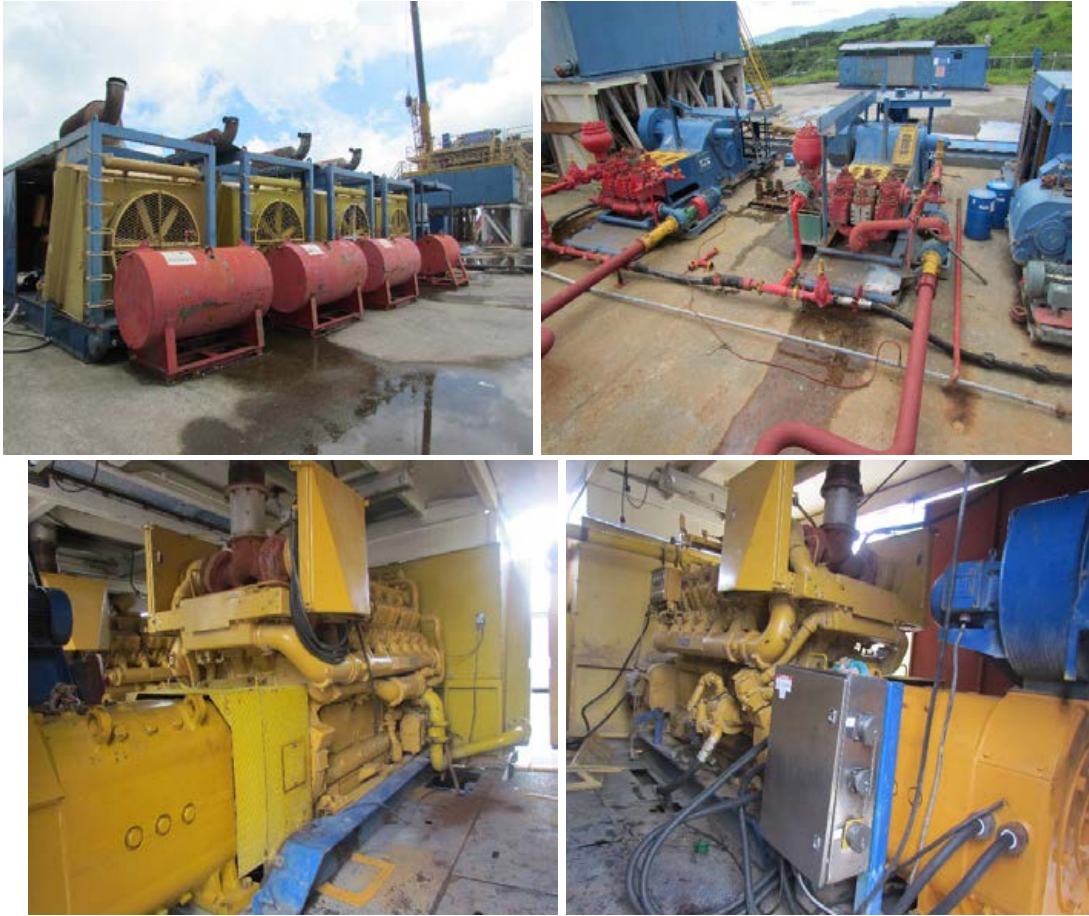
Figura 8. Panorámica de los equipos de perforación.
