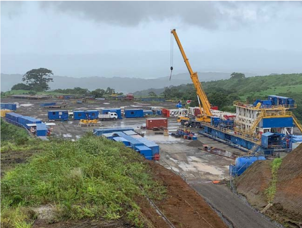
Figura 116. Vista panorámica de la plazoleta PLB-05.
