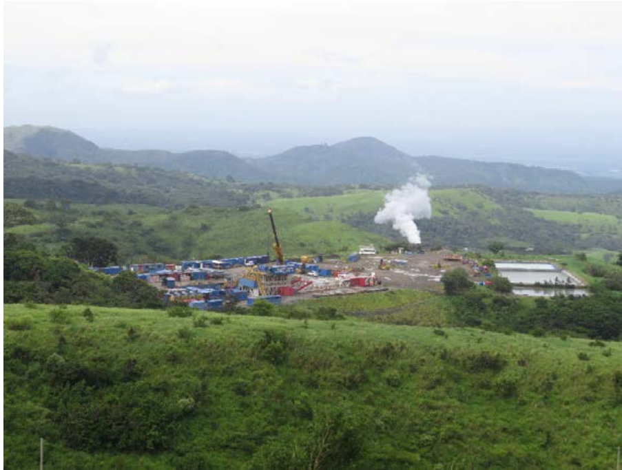
Vista panorámica del sitio de obra Plazoleta PLB-05. Julio 2022.
