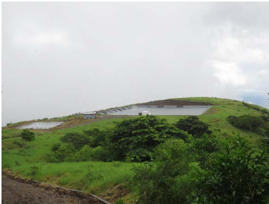
Vista panorámica sitio de obra Laguna de almacenamiento de agua de trabajo. Julio 2022.
