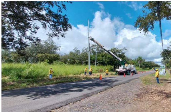
Figura 118. Construcción de la Línea de Distribución Eléctrica (LD) del proyecto.
