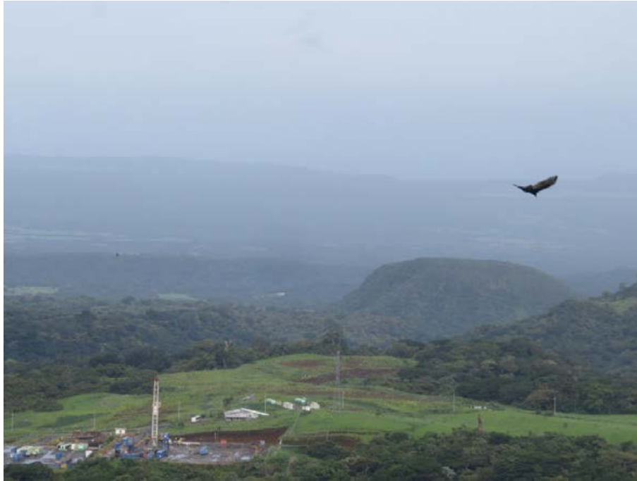
Vista panorámica sitio de obra Escombrera 1. Julio 2022.
