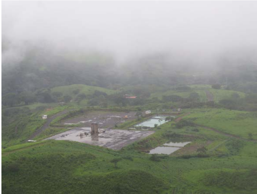
Vista panorámica del sitio de obra Plazoleta PLB-02. Julio 2022.
