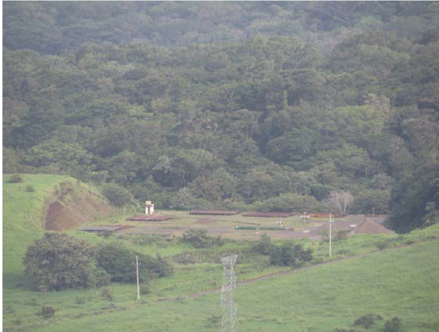
Vista panorámica del sitio de obra Plazoleta PLB-09. Julio 2022.
