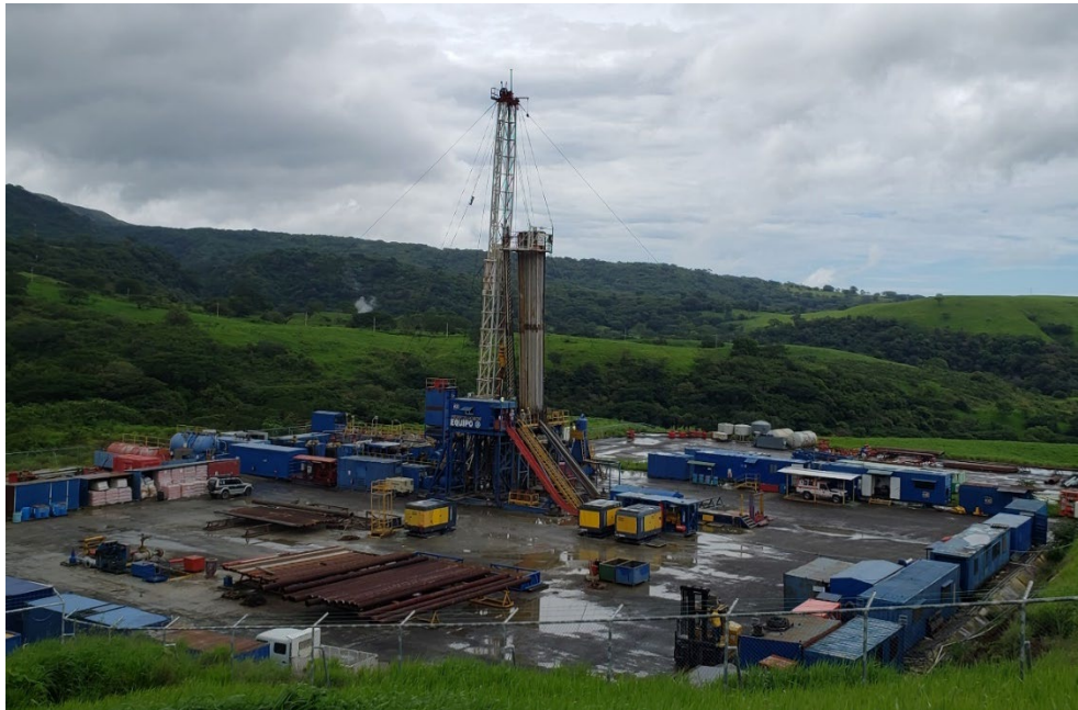
Figura 114. Vista panorámica de la plazoleta PLB-08.
