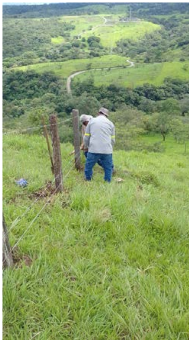
Proceso de construcción de cerca perimetral. Julio 2022.
