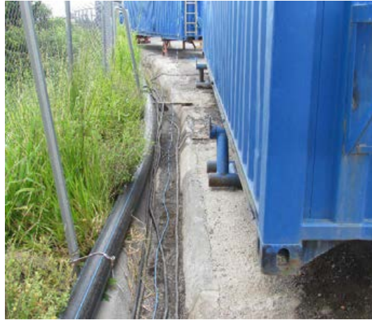
Figura 31. Manejo de aguas ordinarias en sitios de perforación.
