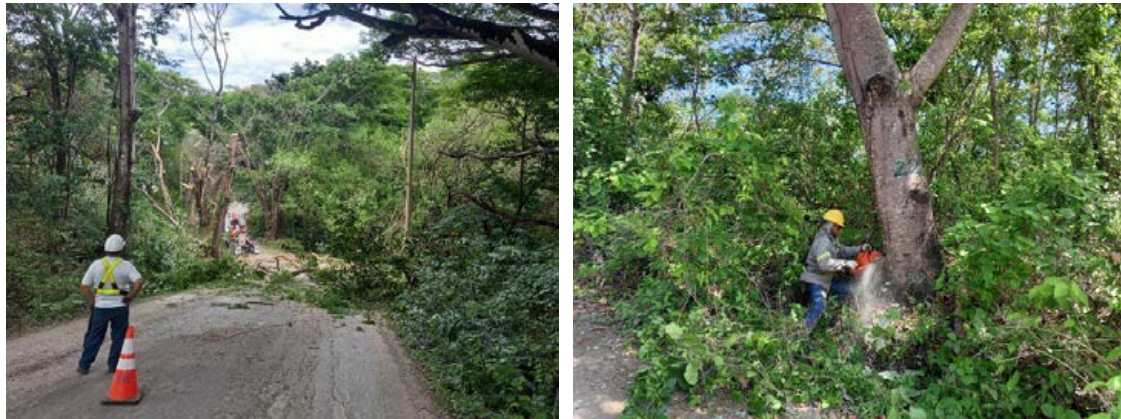
Figura 50. Actividades de aprovechamiento forestal de 30 árboles para la construcción del sitio de obra Línea de Distribución Eléctrica, en el PB Borinquen.
