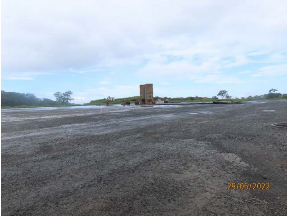
Figura 115. Vista panorámica de la plazoleta PLB-02.
