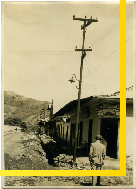
Distribución eléctrica de la CNFL, Escazú
