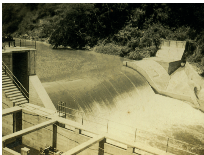
Planta eléctrica Ventanas, CNFL. 1942.
