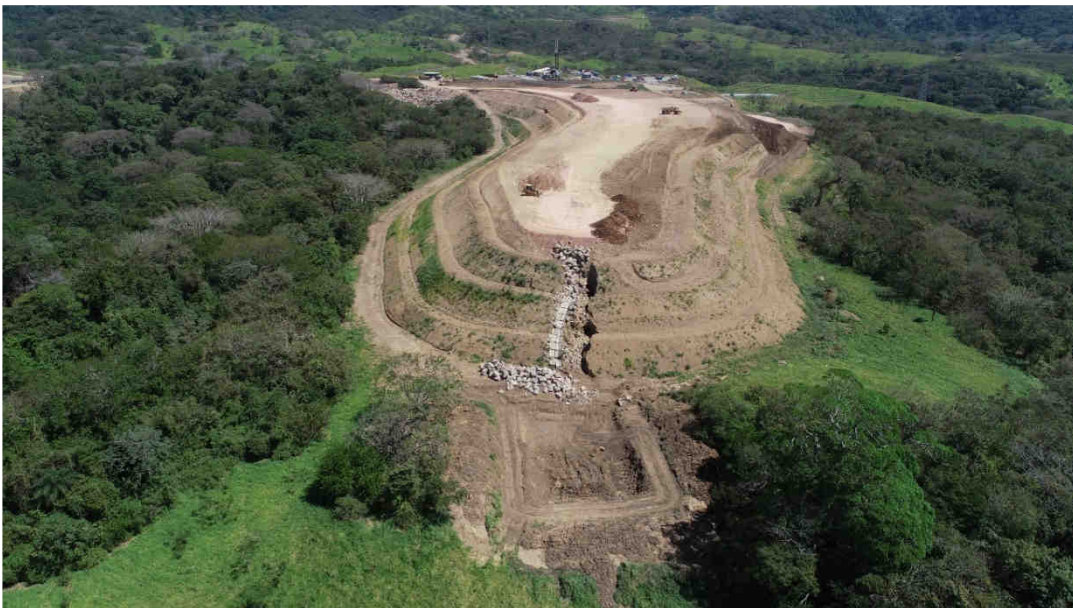
Vista panorámica sitio de obra Escombrera 1. Enero 2024.
