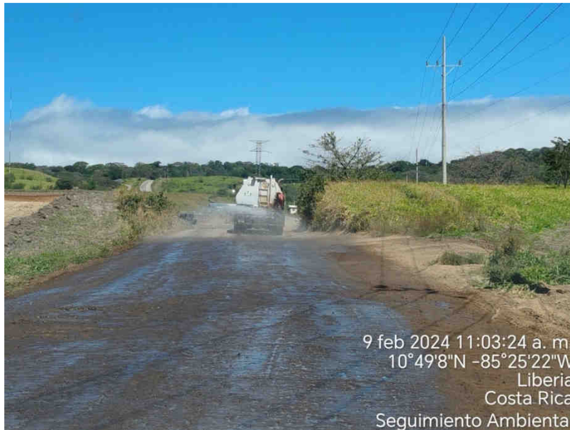
Figura 20. Irrigación de agua en frentes de trabajo internos del proyecto para mitigación de polvo.
