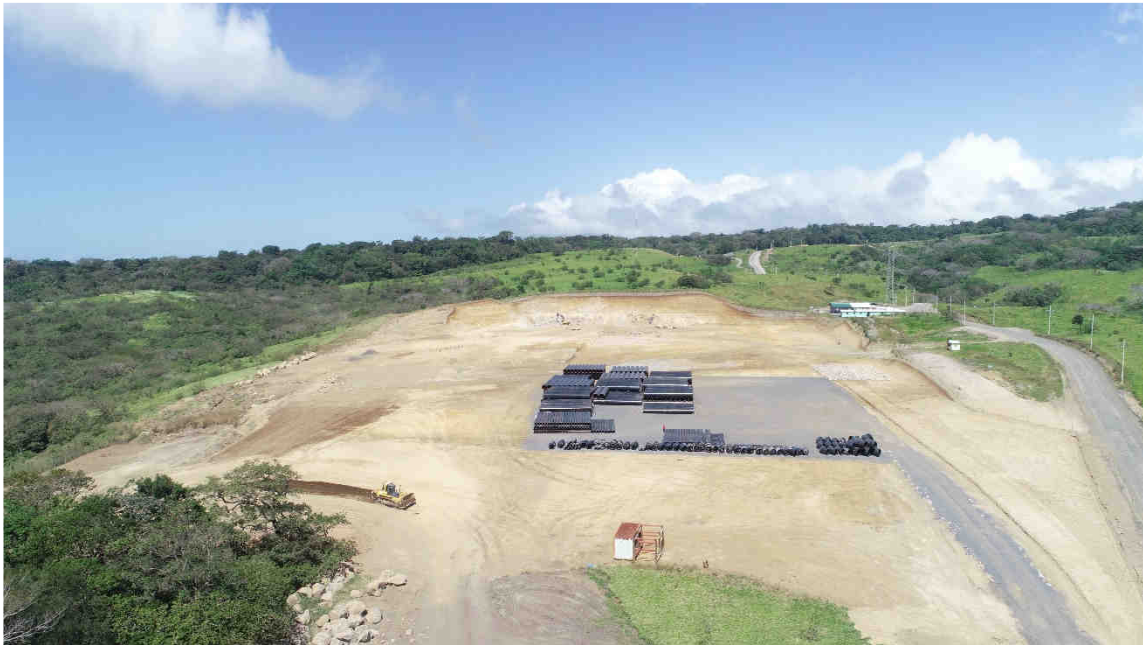
Excavación en sitio de obra Casa de Máquinas. Enero 2024.
