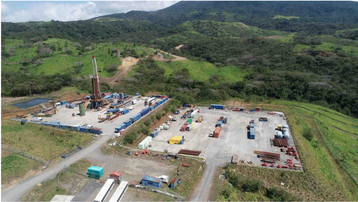
Vista panorámica del sitio de obra Plazoleta PLB-08. Enero 2024.
