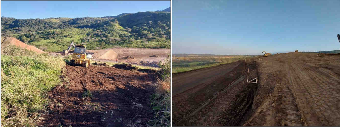
Figura 133. Supervisión de movimientos de tierra para estación separadora ESB-02.
