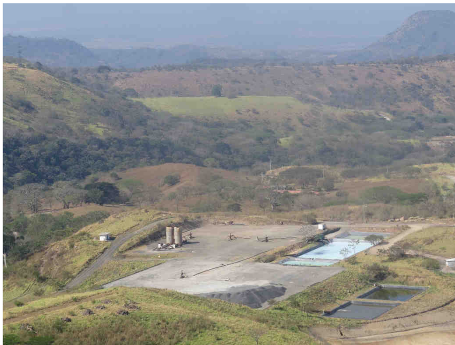
Vista panorámica del sitio de obra Plazoleta PLB-02. Marzo 2024.
