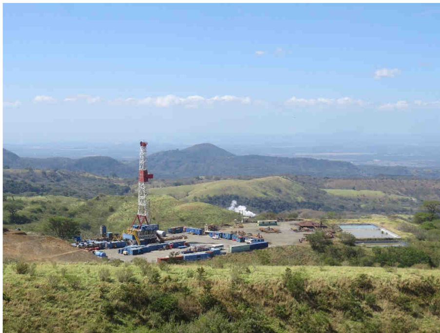
Vista panorámica del sitio de obra Plazoleta PLB-05. Marzo 2024.
