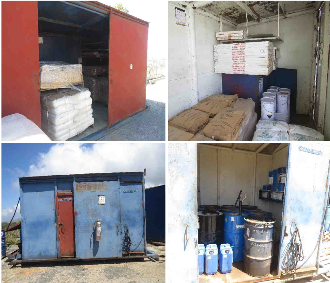
Figura 35: Áreas de almacenamientos de sustancias químicas peligrosas.
