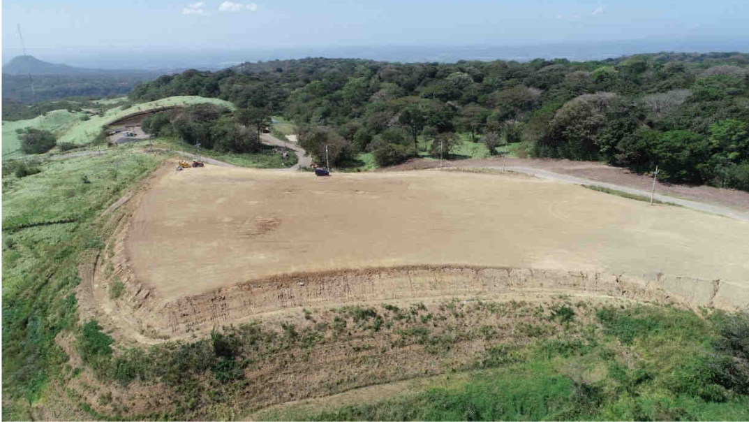
Vista panorámica del sitio de obra Escombrera 2. Enero 2024.
