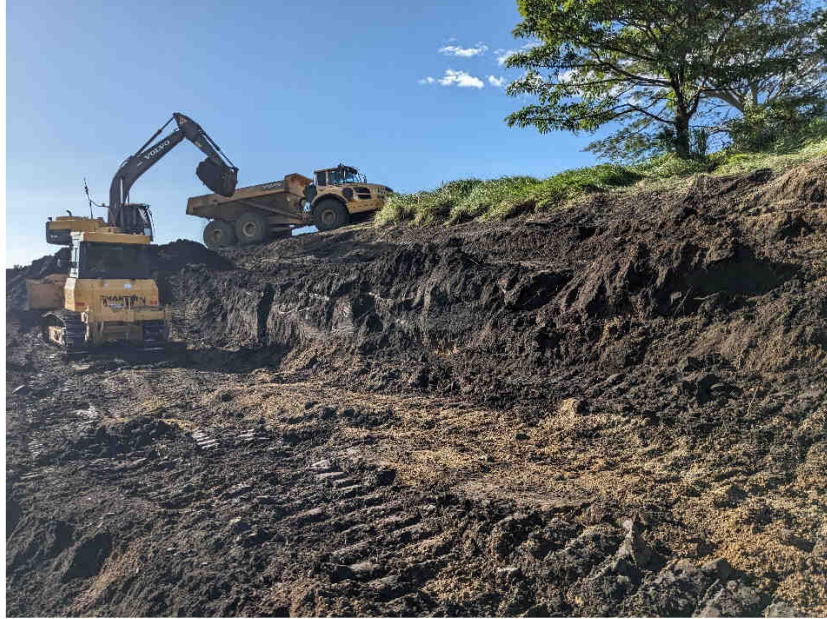
Figura 141. Capa de tefra observada durante supervisión de movimientos de tierra, obra tramo central ruta sur.
