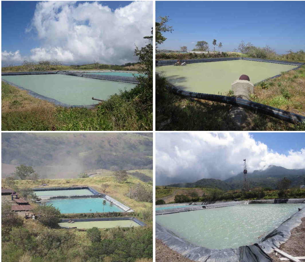
Figura 43. Lagunas impermeabilizadas en PLB-05
