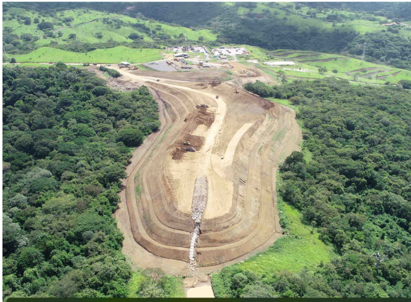
Figura 169. Vista aérea del sitio de obra Escombrera 01.
