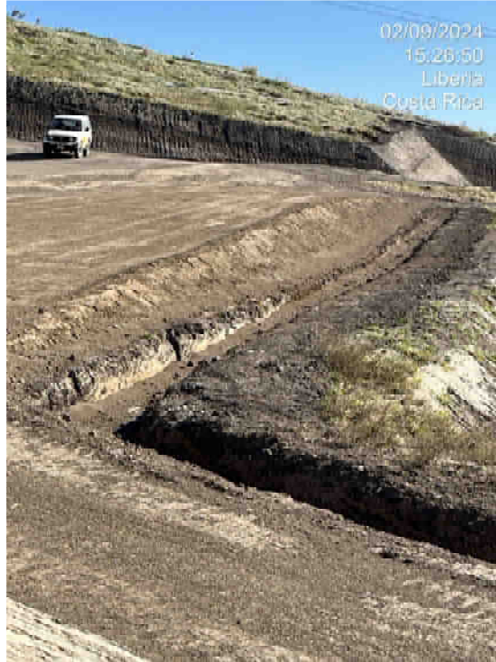
Figura 31. Canales en taludes para manejo de aguas y sedimentos.
