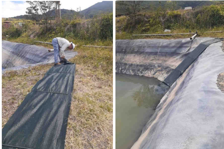
Figura 101. Dispositivos para rescate de fauna en lagunas, Proyecto Geotérmico Borinquen.
