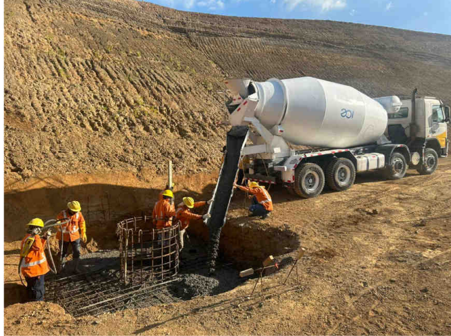
Colada de cemento para tubería en sitio Ruta PL05-SAT05.
