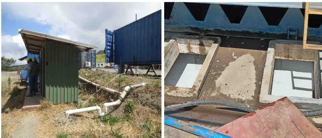
Figura 45. Manejo de escorrentía de aguas.
