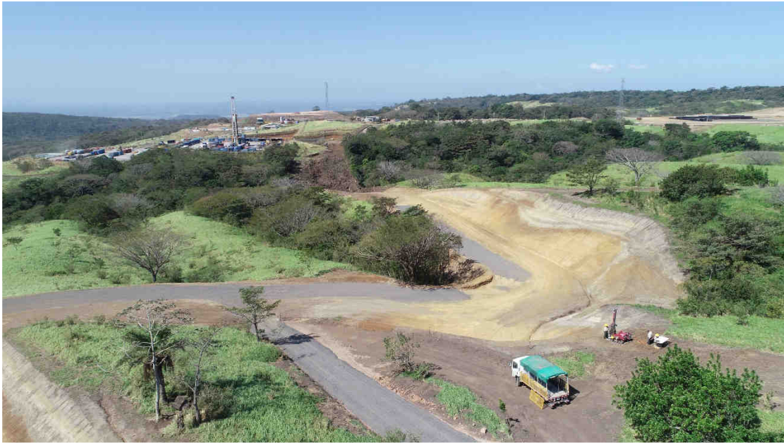
Excavación en sitio de obra Tubería de fluidos geotérmicos, salida de Plazoleta PLB-2 del sector ruta sur. Enero 2024.
