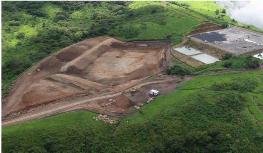
Figura 177. Vista aérea del sitio de obra Laguna LGB-02.
