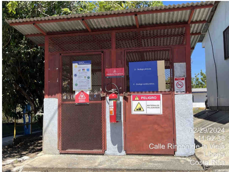
Figura 40. Sitio de almacenamiento de sustancias y residuos peligrosos.
