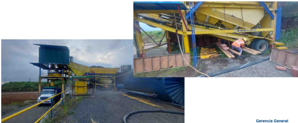
Figura 179. Sitio de obra Planta de Concreto.
