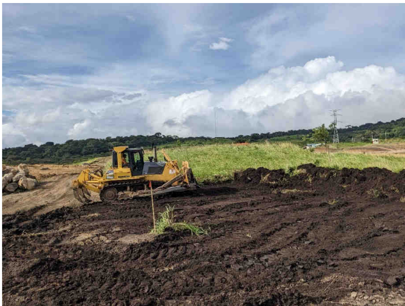
Figura 143. Movimiento de tierra con tractor para obra tramo central-ruta sur.
