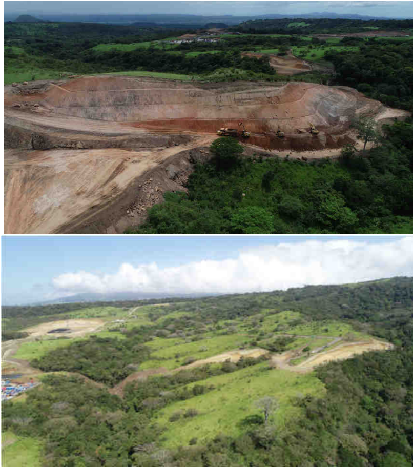
Figura 175. Vista aérea del sitio de obra Ruta Vapoducto Sur PLB-02 – UV1 – Ruta Especial.
