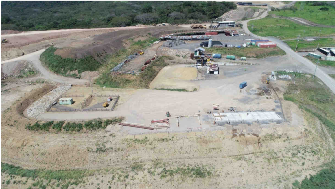
Vista panorámica sitio de obra Planta de concreto. Enero 2024.
