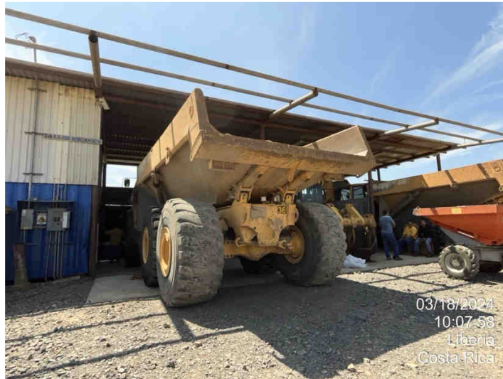
Figura 11. Extensión de losa para reparación de equipos en taller mecánico.
