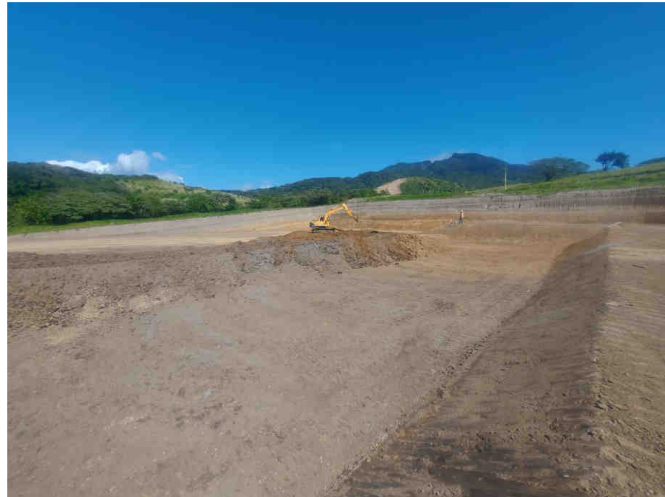
Figura 183. Sitio de obra Estación Separadora ESB-05.
