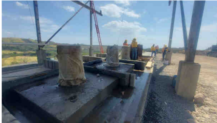
Cimientos de tubería prefabricados.
