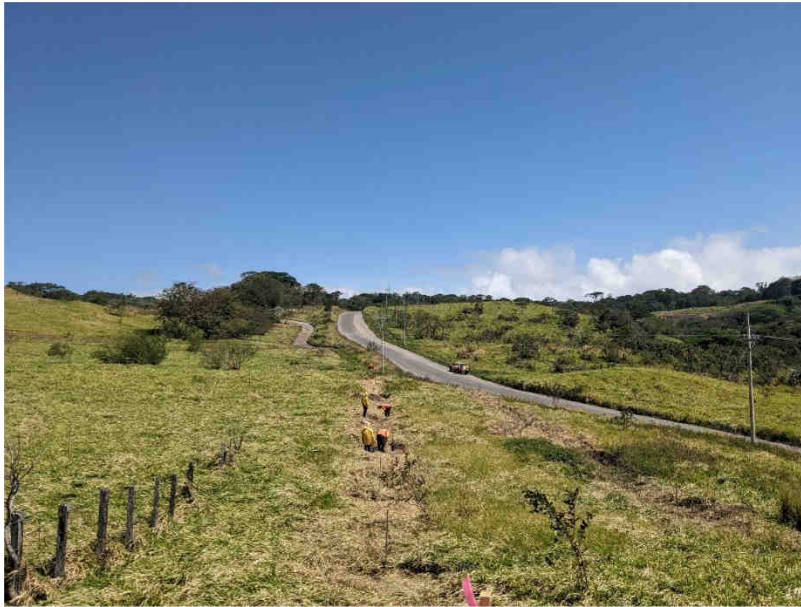
Figura 157. Inicio de trabajo de campo con excavación de pozos de sondeo, evaluación arqueológica “entrada de tubería a Casa de máquinas, sitio Ajuate G-941 Aj”.
