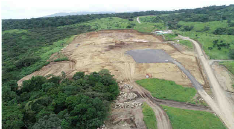
Figura 165. Vista aérea sitio de obra Casa de Máquinas.
