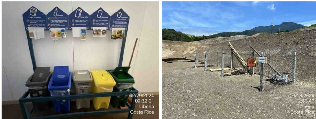
Figura 49. Manejo de los residuos en obra.
