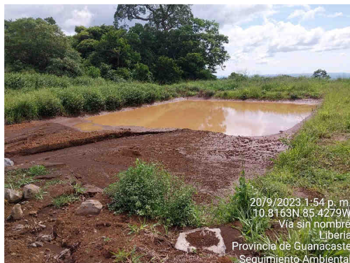
Figura 34. Sedimentador de la escombrera 1, invierno 2023.
