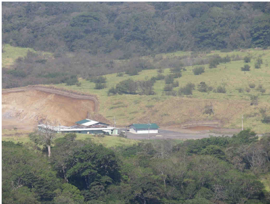
Vista panorámica sitio de obra Oficinas y comedor de Servicios No Regulados. Marzo 2024.
