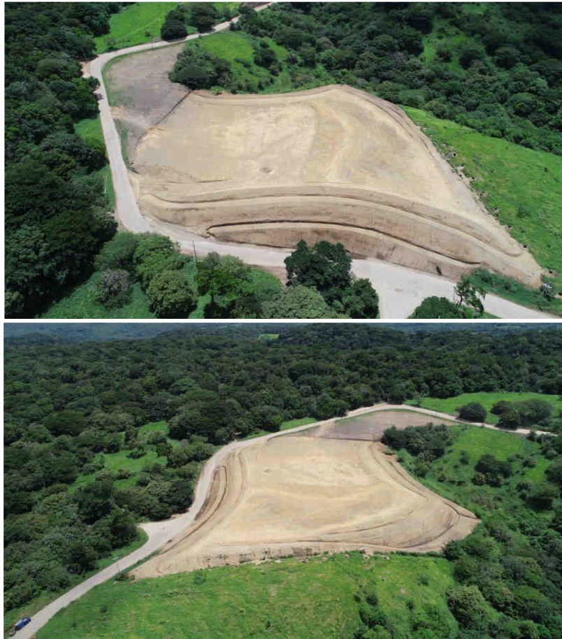
Figura 171. Vista aérea del sitio de obra Escombrera 01.
