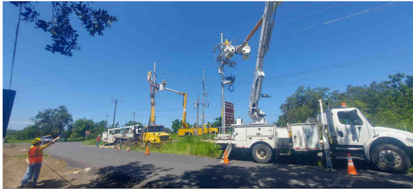
Figura 181. Proceso constructivo de la obra Línea de Distribución Eléctrica LD.
