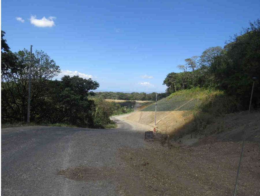
Excavación en sitio de obra Tubería de fluidos geotérmicos, ampliación de camino en sector ruta norte. Marzo 2024.
