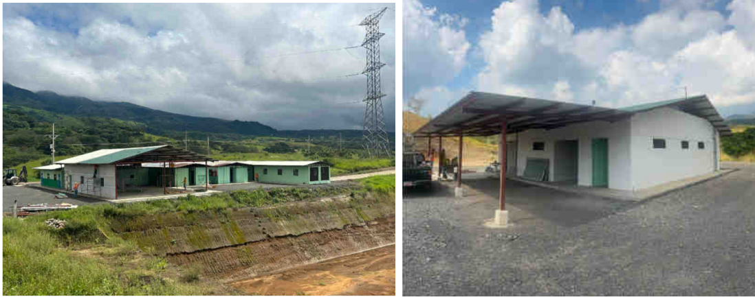
Figura 180. Sitio de obra Campers de Oficina, Comedor Satélite y Dispensarios en Casa de Maquinas.
