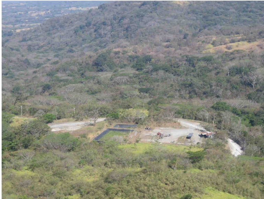
Vista panorámica del sitio de obra Plazoleta PLB-03. Marzo 2024.
