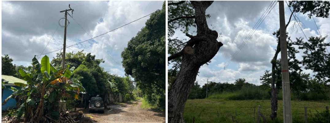
Figura 182. Proceso constructivo de acometida eléctrica para pozo de agua en la comunidad de El Cedro.
