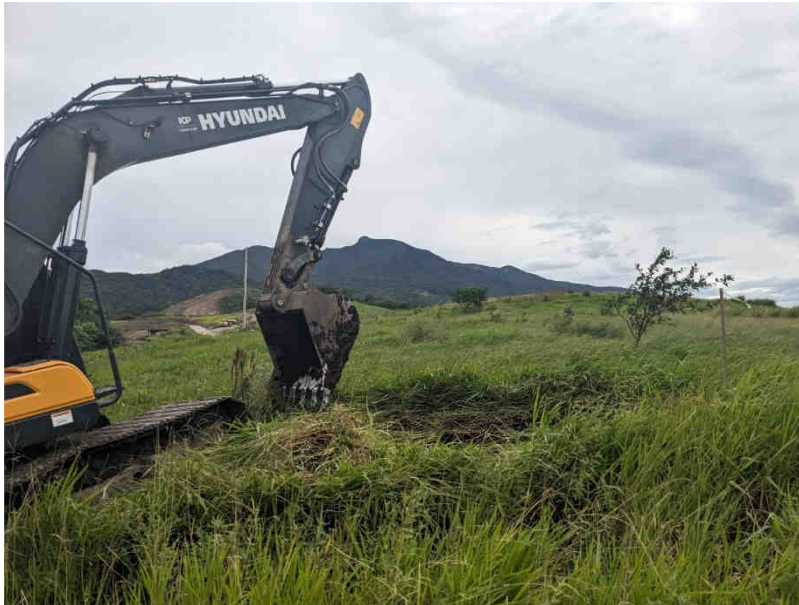
Figura 145. Movimiento de tierra para obra ruta tradicional norte.
