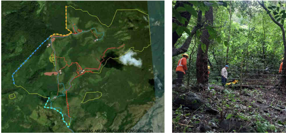
Figura 81. Construcción de cerca perimetral del Campo Geotérmico Borinquen.
