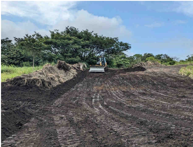
Figura 140. Movimiento de tierra con tractor para obra tramo central-ruta sur.
