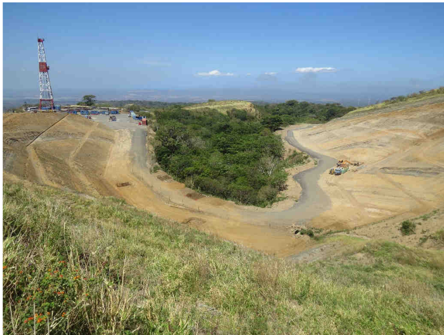
Excavación en sitio de obra Tubería de fluidos geotérmicos, salida de Plazoleta PLB-5 del sector ruta norte. Marzo 2024.
