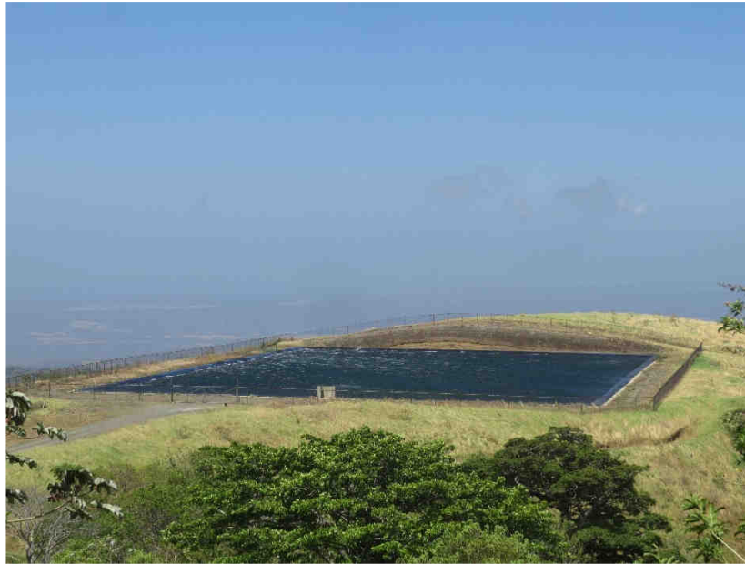
Figura 159. Laguna de almacenamiento para agua de trabajo.
