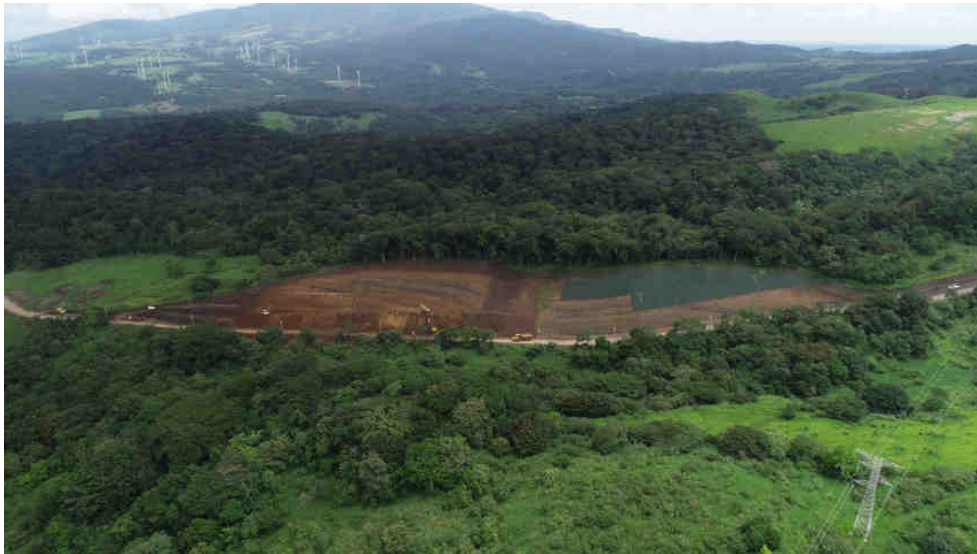
Figura 167. Diseño y vista aérea del sitio de obra Tonería vaporducto ruta norte.
