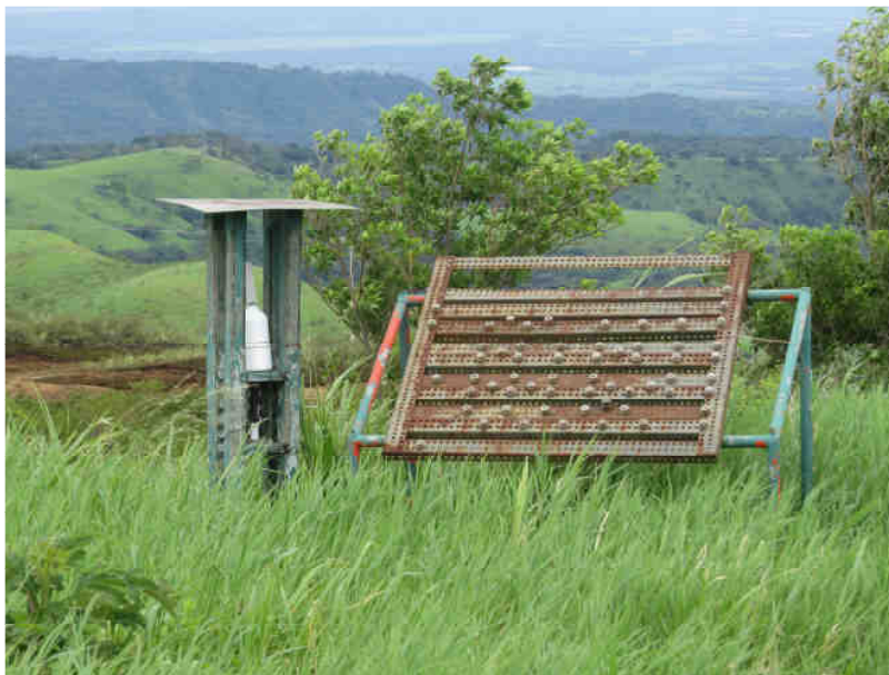
Figura 53. Estación de monitoreo de corrosión en PLB-05.
