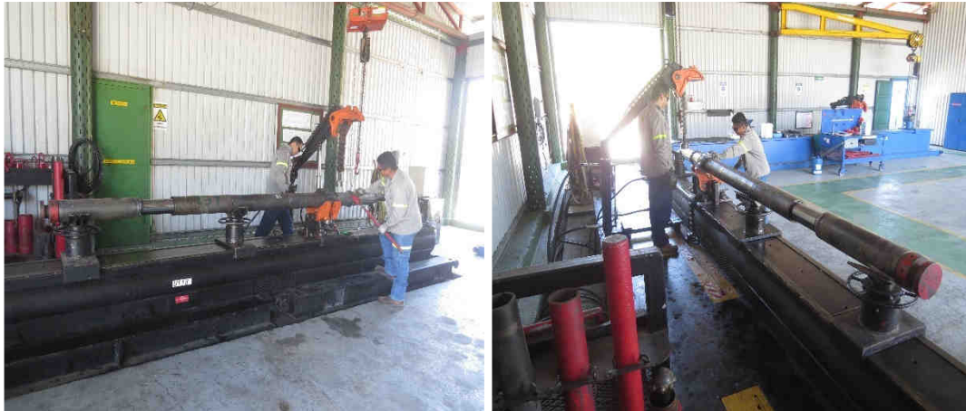
Figura 6. Mantenimiento de equipos de perforación
