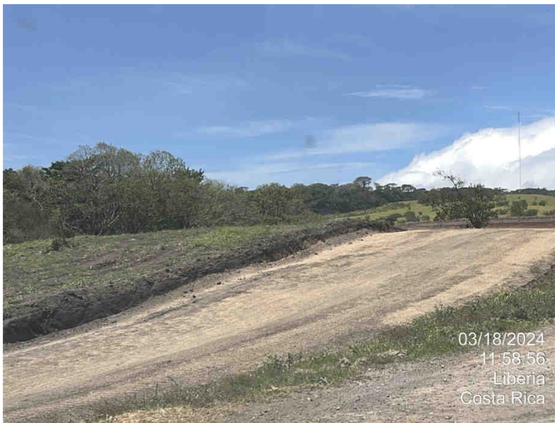
Figura 72. Talud camino a casa maquinas.
