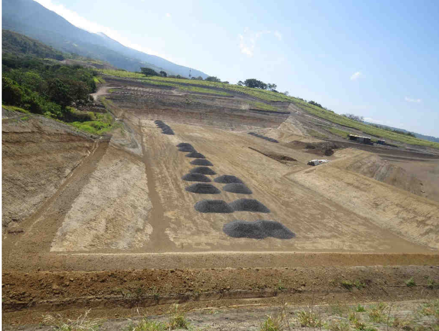
Excavación en sitio de obra Laguna 05 (LGB-05) y Estación Separadora 05 (ESB-05). Marzo 2024.
