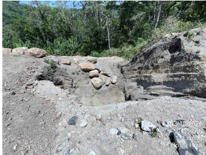
Figura 32. Limpieza de sedimentadores.
