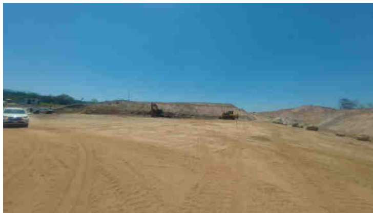
Figura 184. Sitio de obra Estación Separadora ESB-02.
