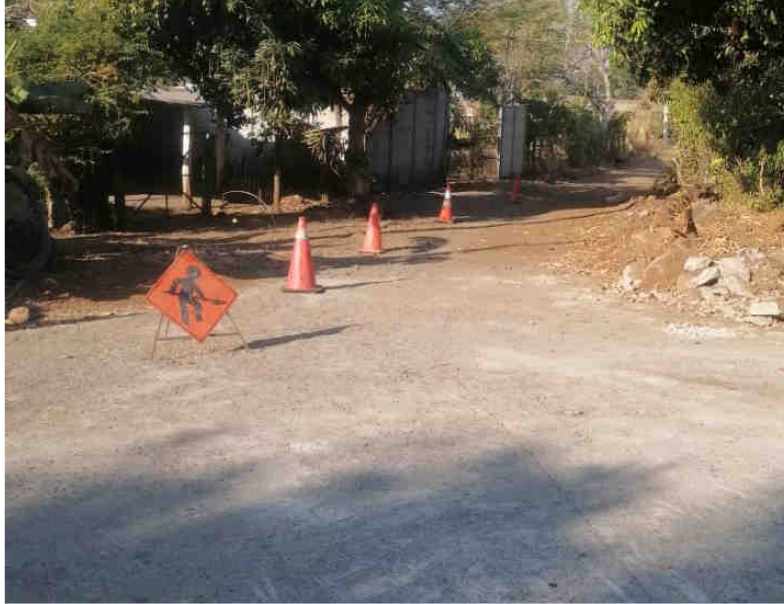
Figura 163. Demarcación y regulación de tránsito para los trabajos de la LD.
