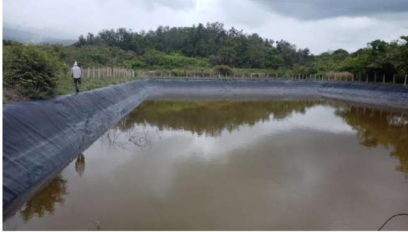
Figura 66. Revisión de sistemas de impermeabilización de las lagunas. I Semestre 2022.
