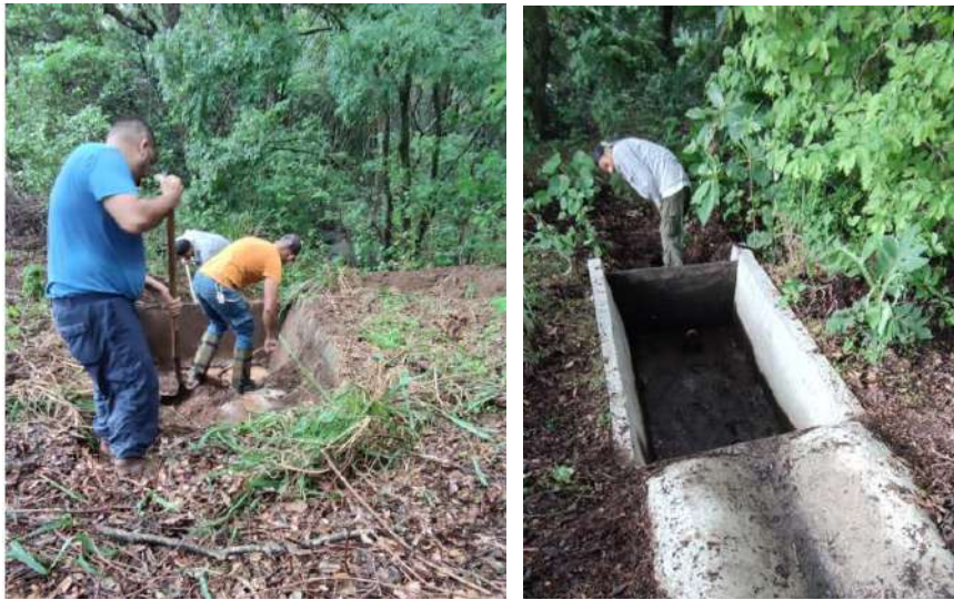
Figura 34. Limpieza de sedimentadores durante inspección de sistemas de evacuación pluvial. Mayo, 2022
