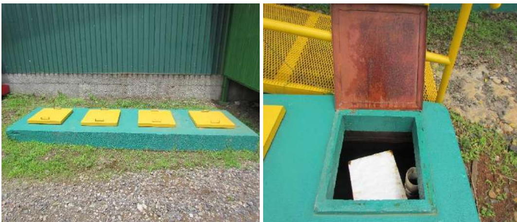
Figura 13. Trampas para aguas oleaginosas de talleres del CG Pailas.
