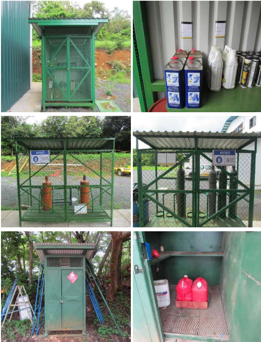
Figura 15 Áreas de almacenamiento para sustancias peligrosas en el CG Pailas
