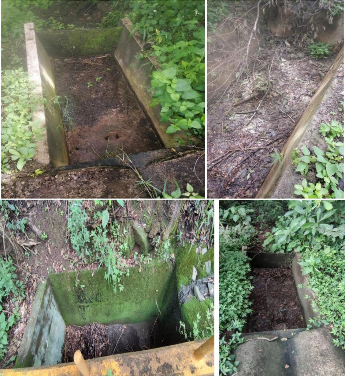
Figura 49. Limpieza de sedimentadores durante inspección de sistemas de evacuación pluvial. Campo Geotérmico Las Pailas, julio y setiembre 2022.
