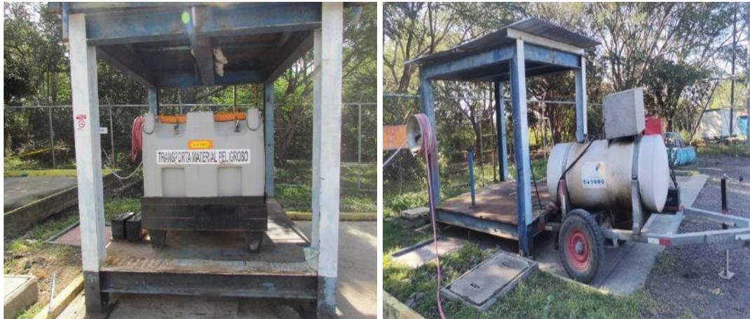
Figura 29. Tanqueta y equipos dispensadores utilizados para el despacho de combustibles.
