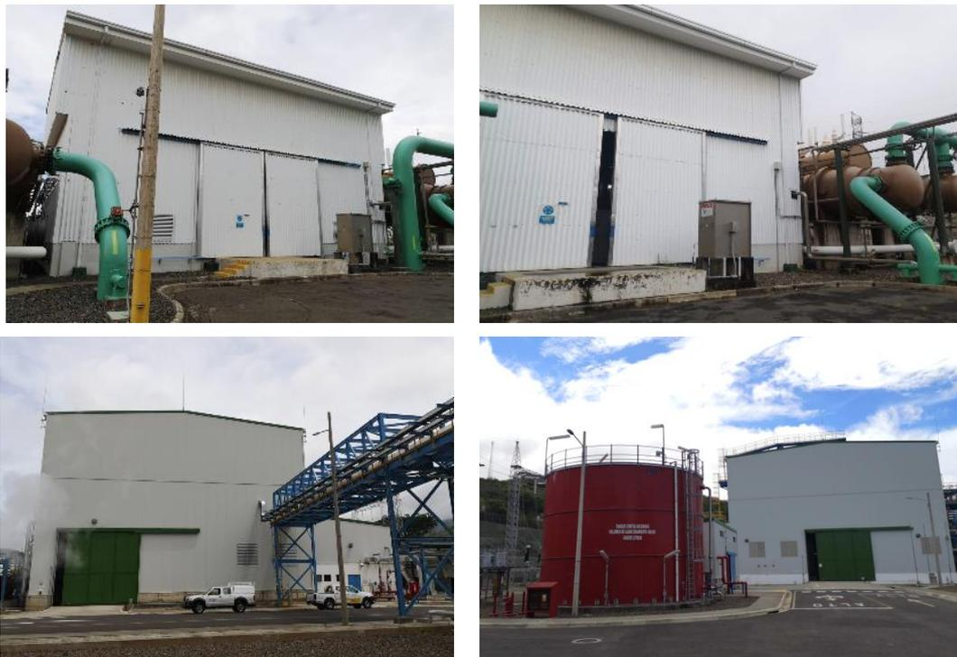
Figura 44 Estado de casas de máquinas cerradas para evitar salida de ruido en Planta
