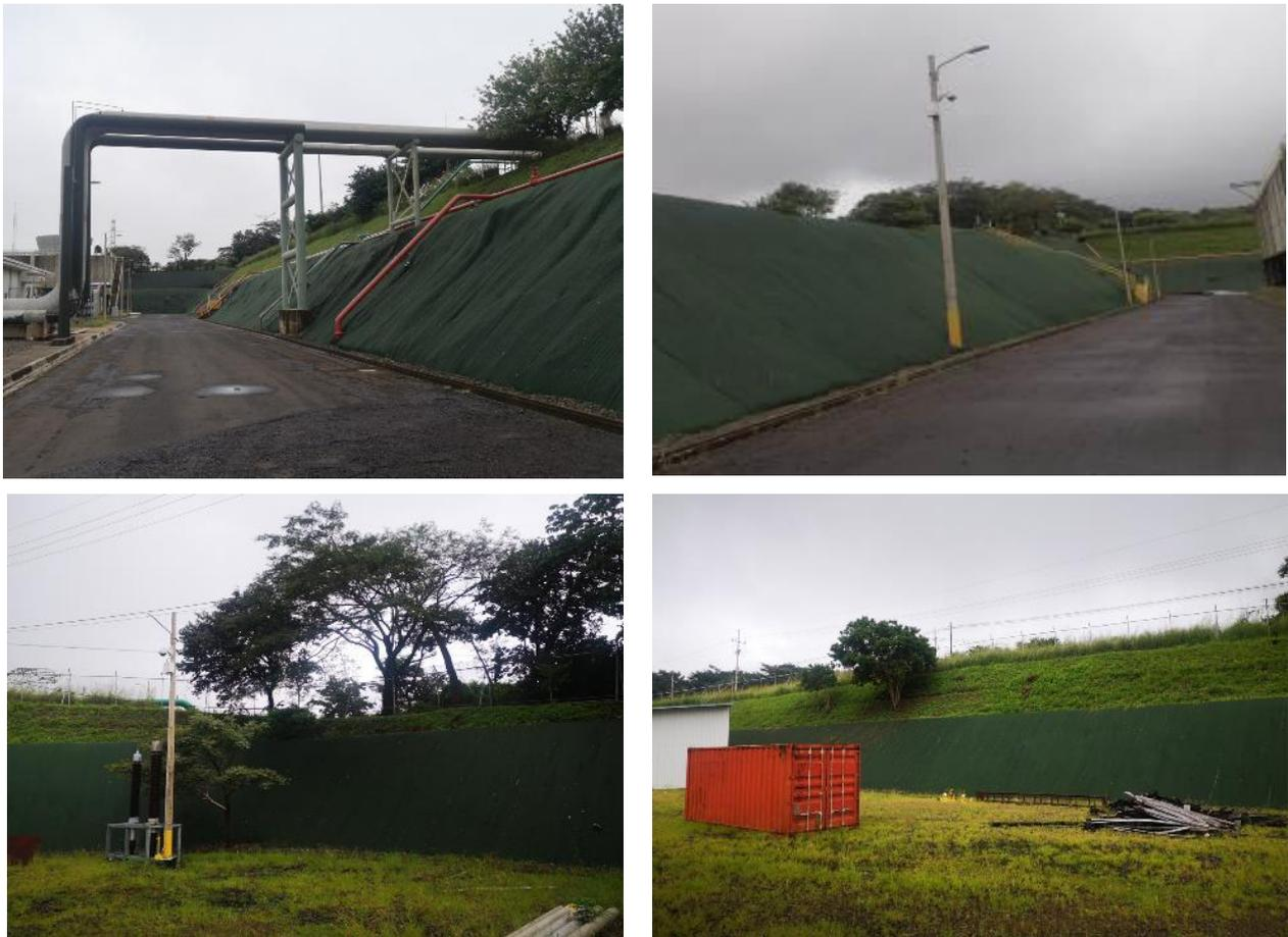
Figura 75 Instalación de nueva geomembrana que protege los taludes en la Unidad I
