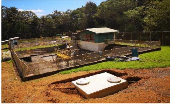
Figura 26 Instalación completa del tanque séptico que reemplaza la PTAR en Unidad Pailas I
